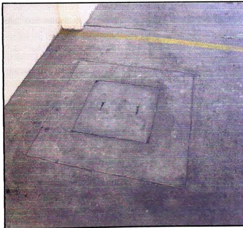
Foto N°2.5: Detalle de Buzón de Concreto
