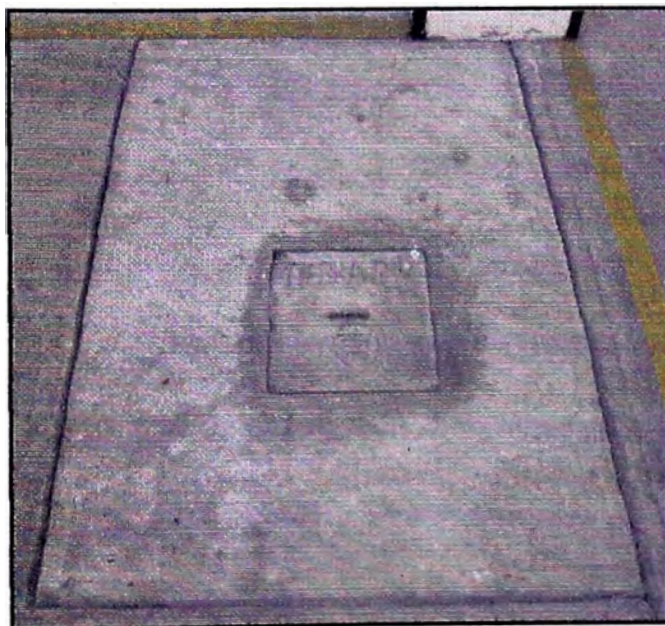
Foto N°4.1: Detalle de Pozo a Tierra
