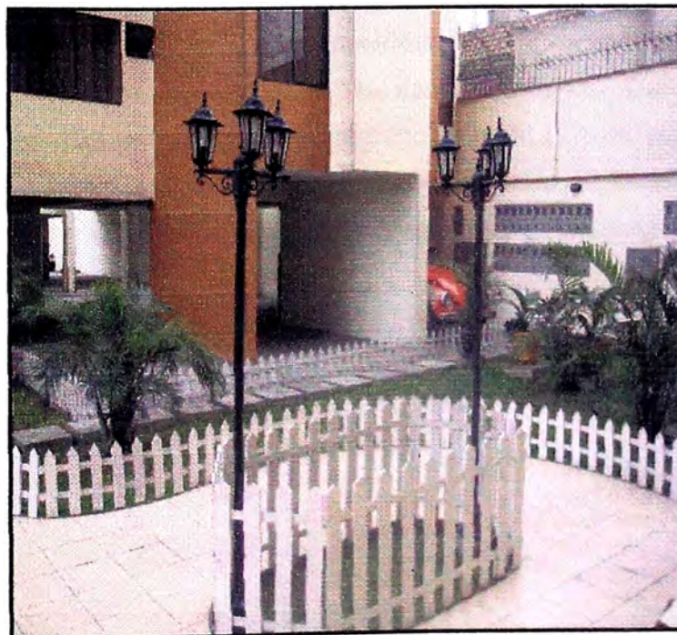
Foto N°5.1: Equipo para Alumbrado Exterior
