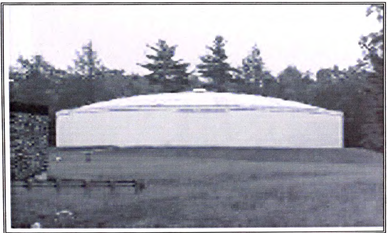
Figura 1.5: reservorio circular apoyado
