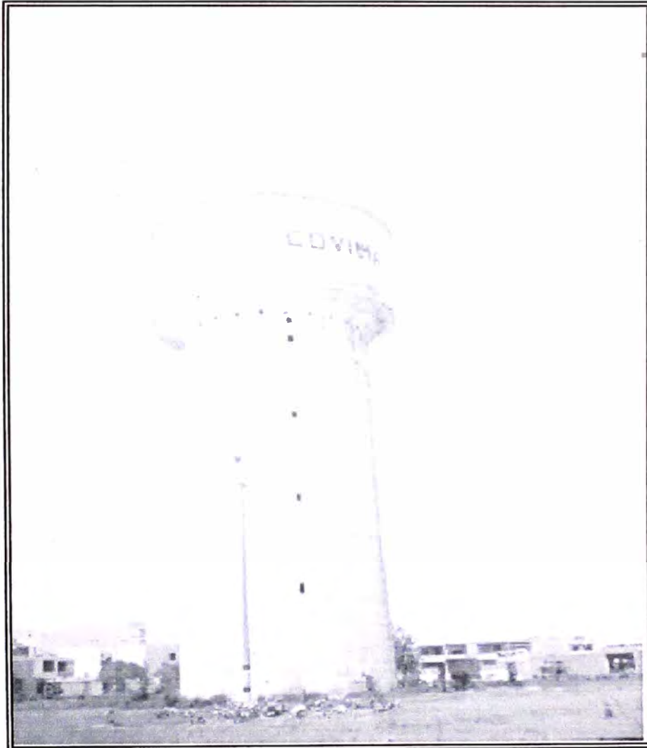
Figura 1.7: Reservoirio elevado tipo Intze
