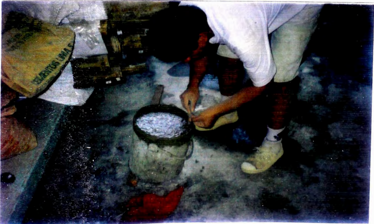
Foto N° 7 : Extracción del agua superficial
