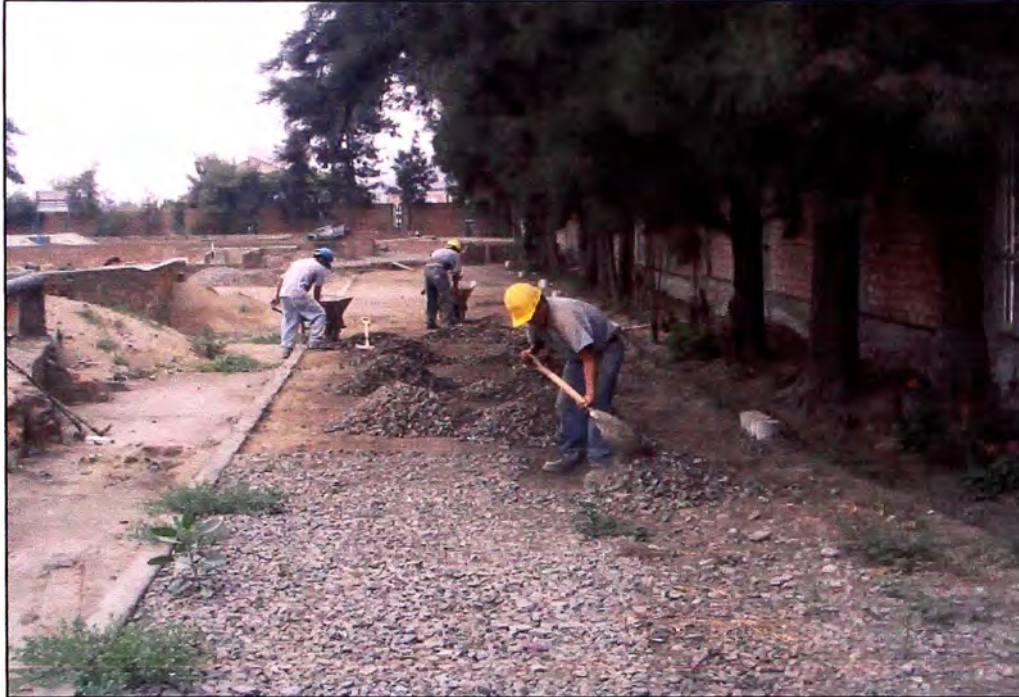
Foto 01 Limpieza del Terreno
