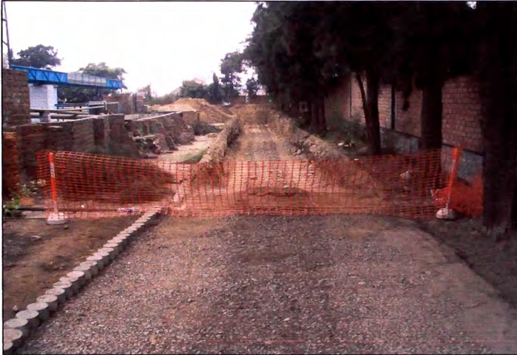
Foto 05 Malla de seguridad
