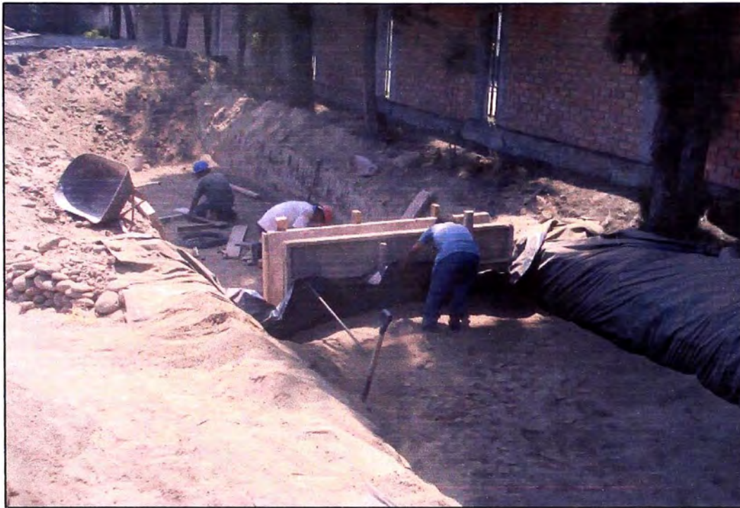
Foto 07 Encofrado de muro de separación
