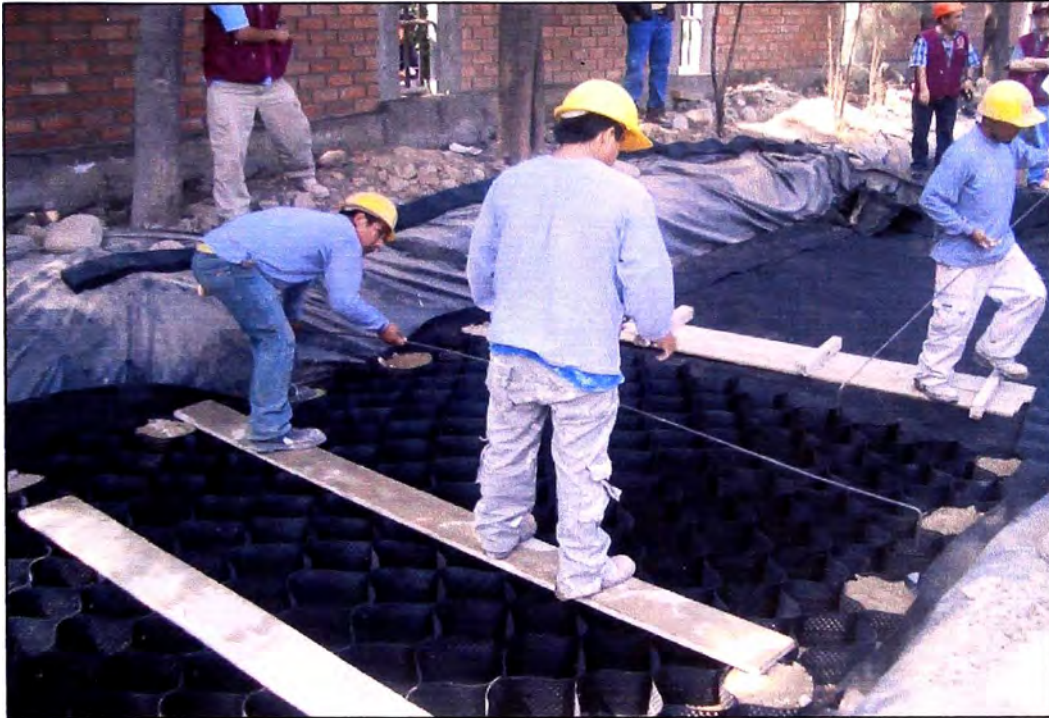
Foto 15 Instalación de los módulos de GEOWEB
