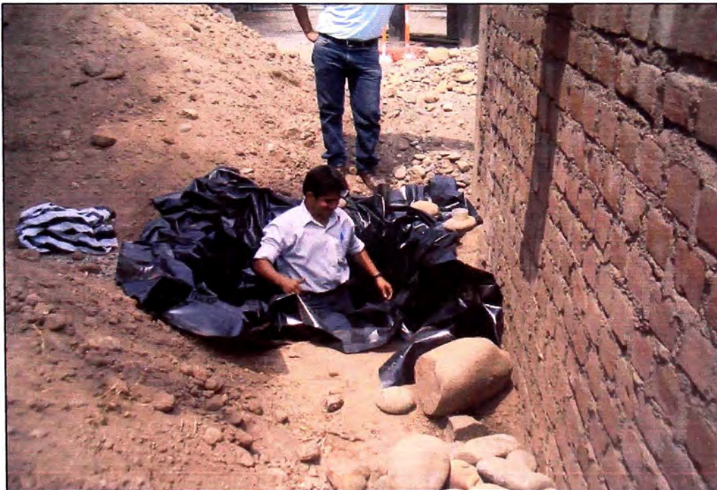
Foto 10 Impermeabilización de poza experimental con plástico
