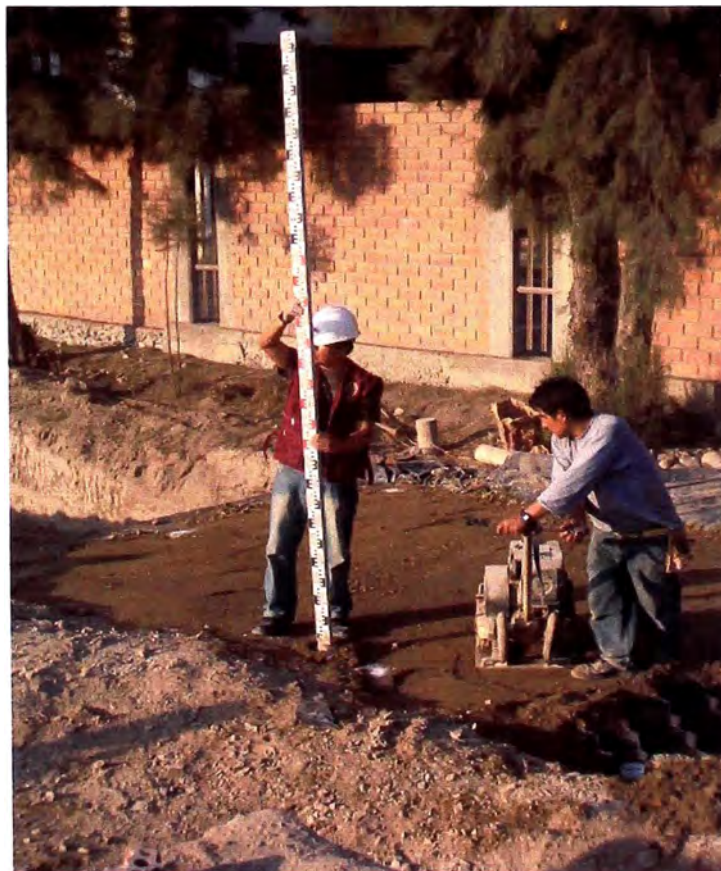
Foto 18 Verificación de cotas
