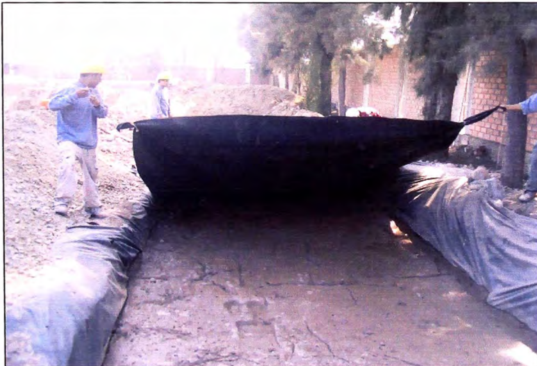
Foto 14 Instalación del geotextil no tejido de separación
