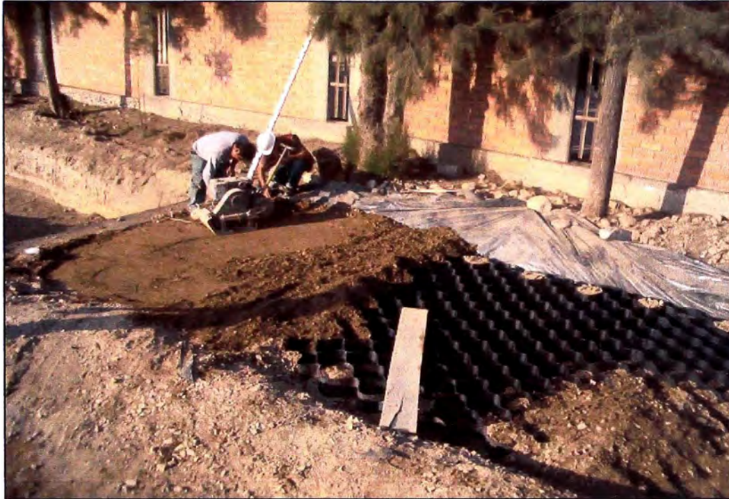
Foto 17 Compactación del terreno
