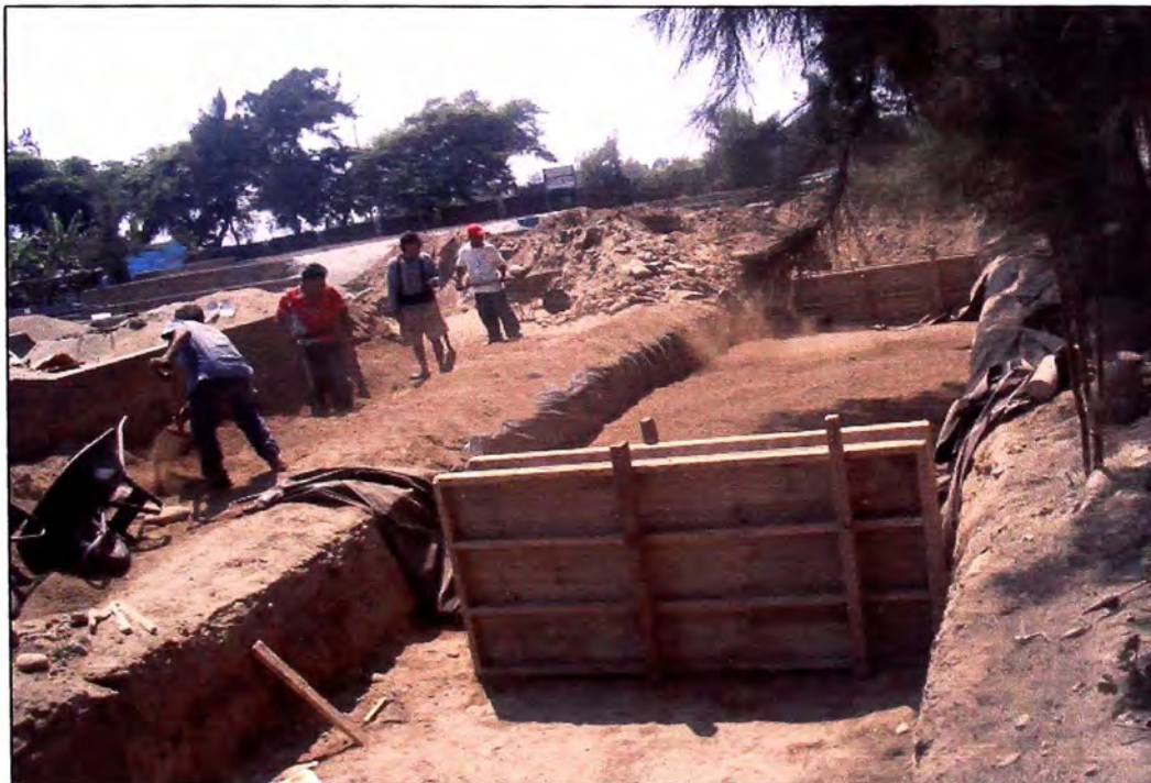
Foto 08 Relleno de zona a degradar
