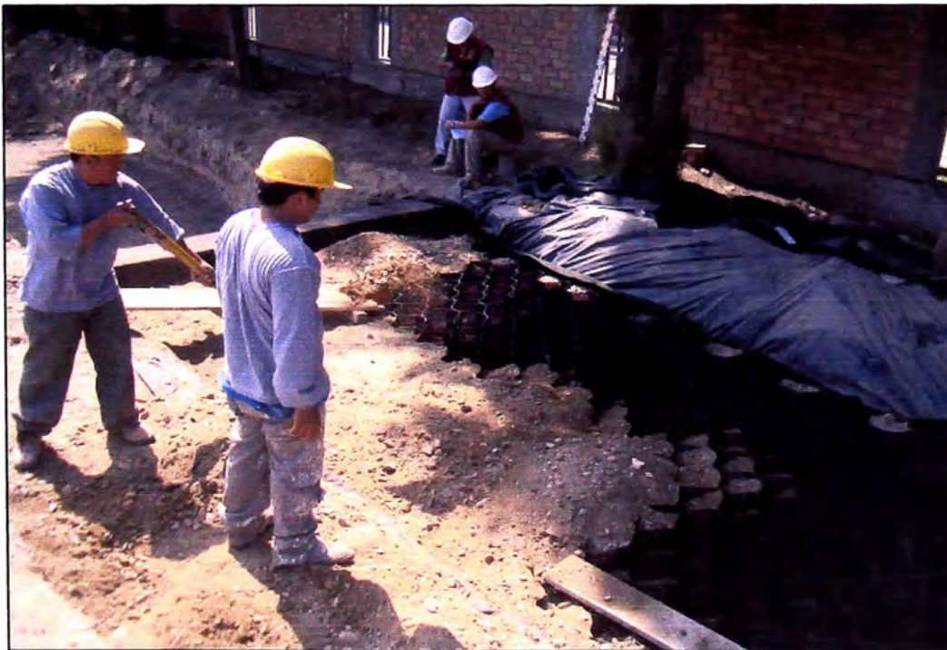
Foto 16 Relleno de las secciones de GEOWEB con material granular
