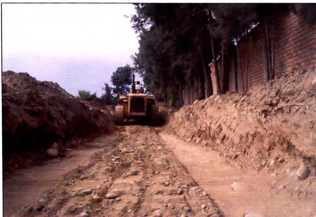
Foto 04 Corte de terreno
