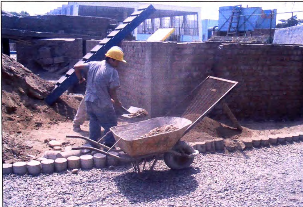
Foto 06 Tamizado del material extraído del corte del terreno
