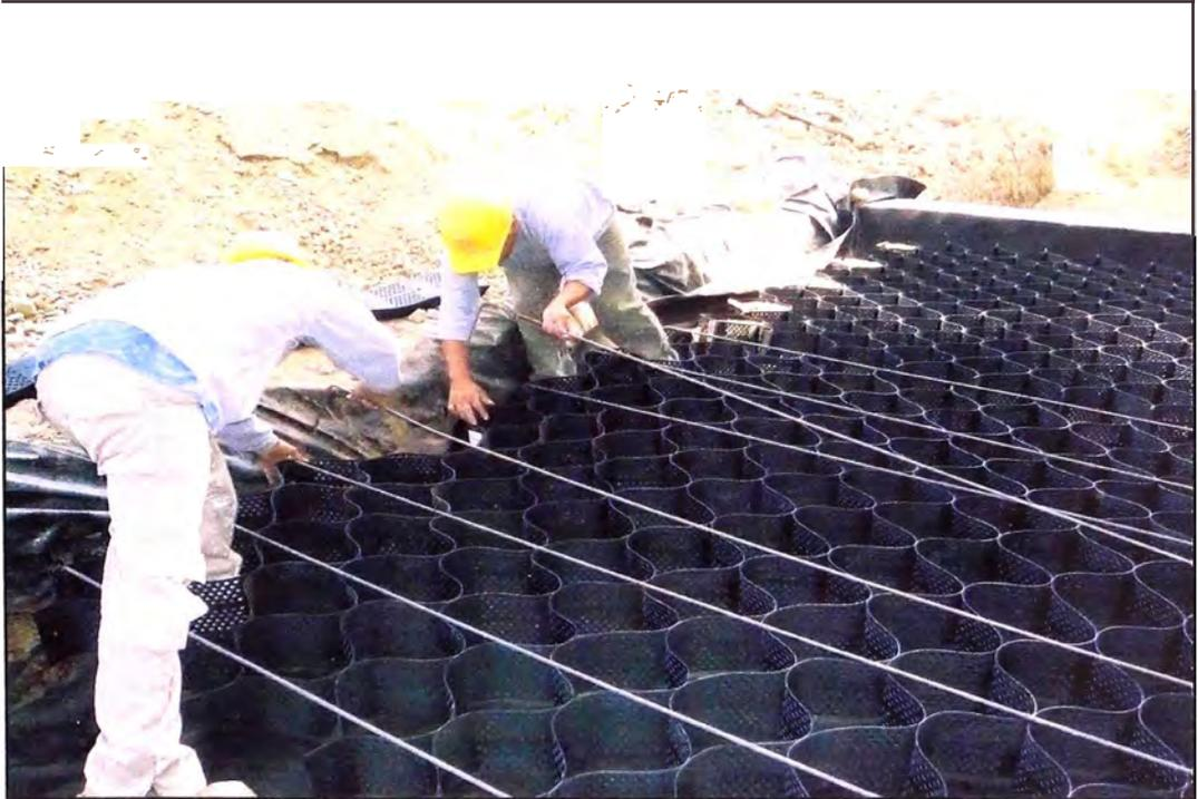
**LASTREADO DE CELDAS DE GEOWEB ( PROCESO DE RELLENO DE CELDAS)**
