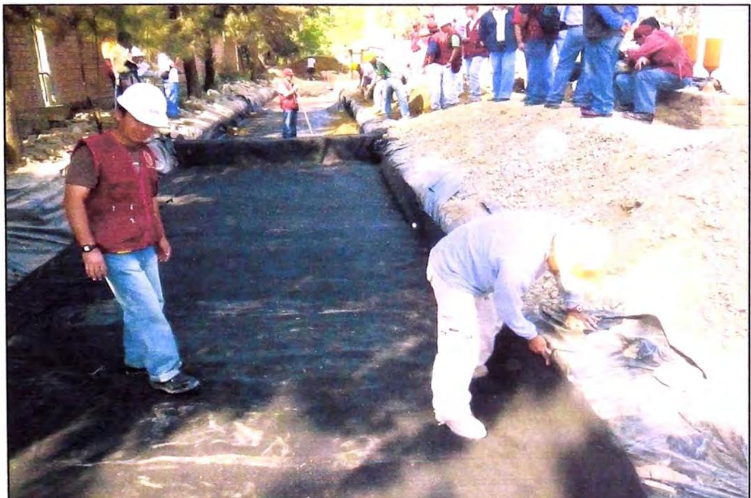
**COLOCACION DE GEOWEB PERFORADA (GW30V6), POR MEDIO DE VARILLAS DE ACERO DIMENSIONADAS**
