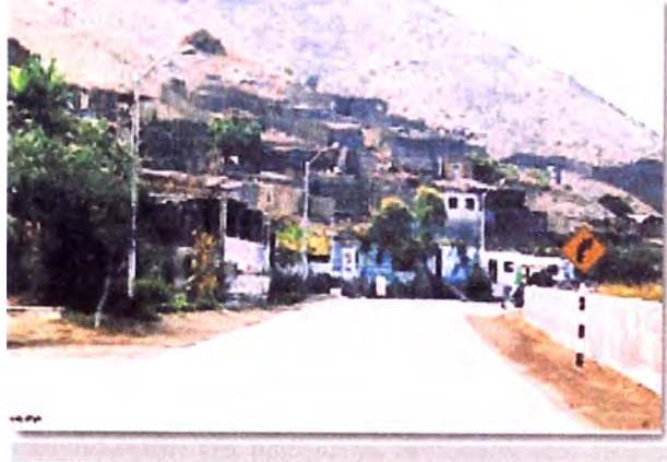
Imagen 4.6 Carretera Cañete - Yauyos
