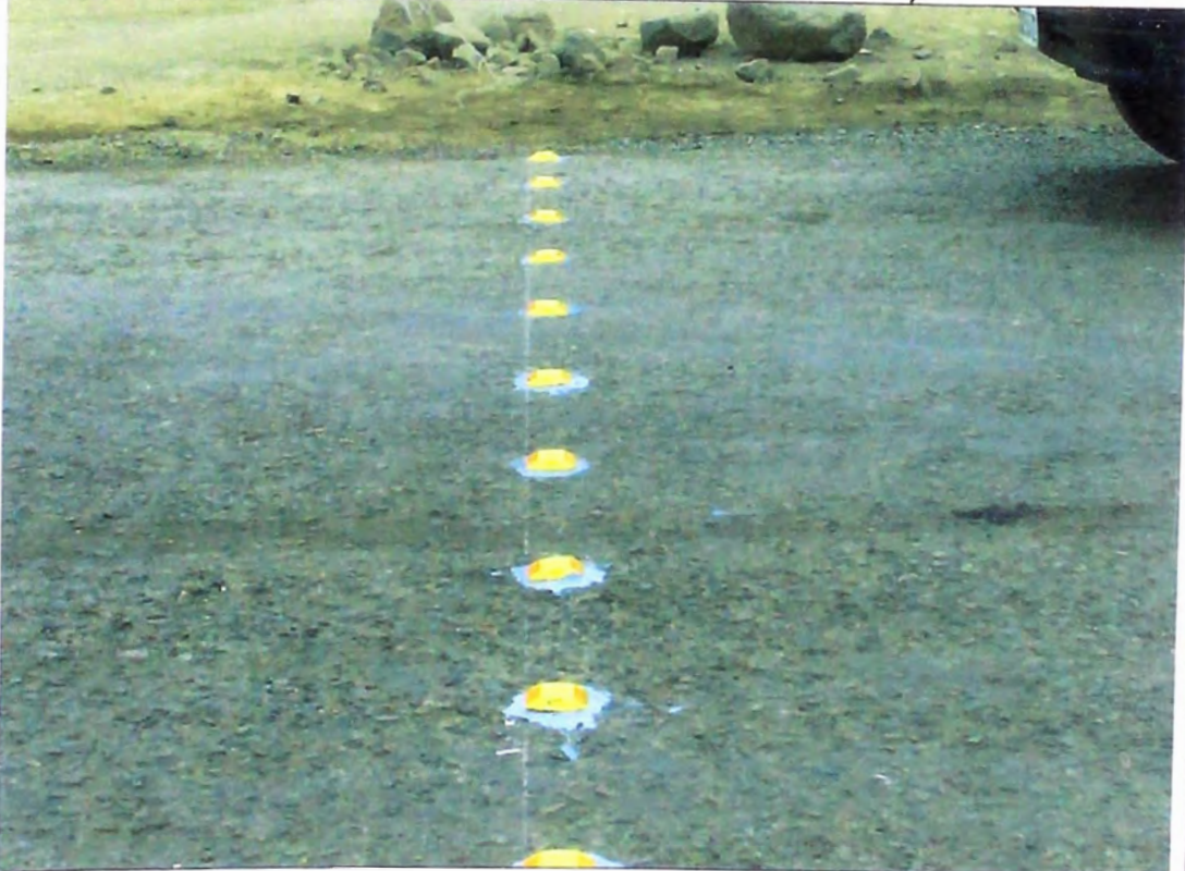
Foto N° 20 – Ensayo para la colocación de los delineadores "ojos de gato" como parte de la señalización horizontal.
