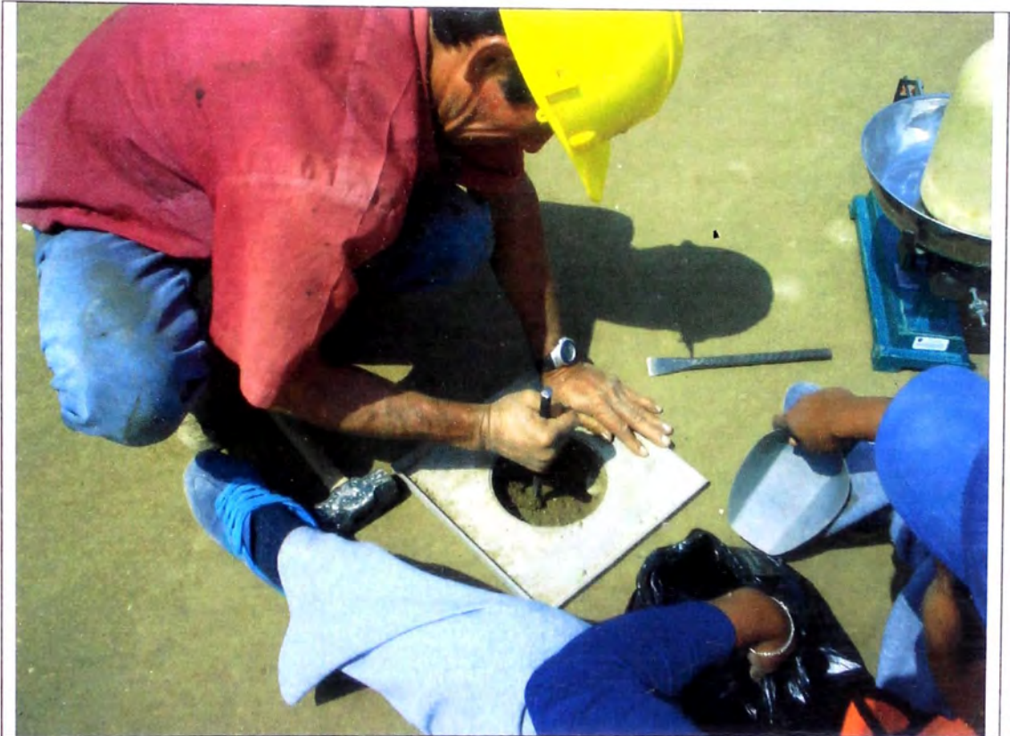
Foto N° 09 – Control de densidad en campo a la capa reconformada con afirmado.
