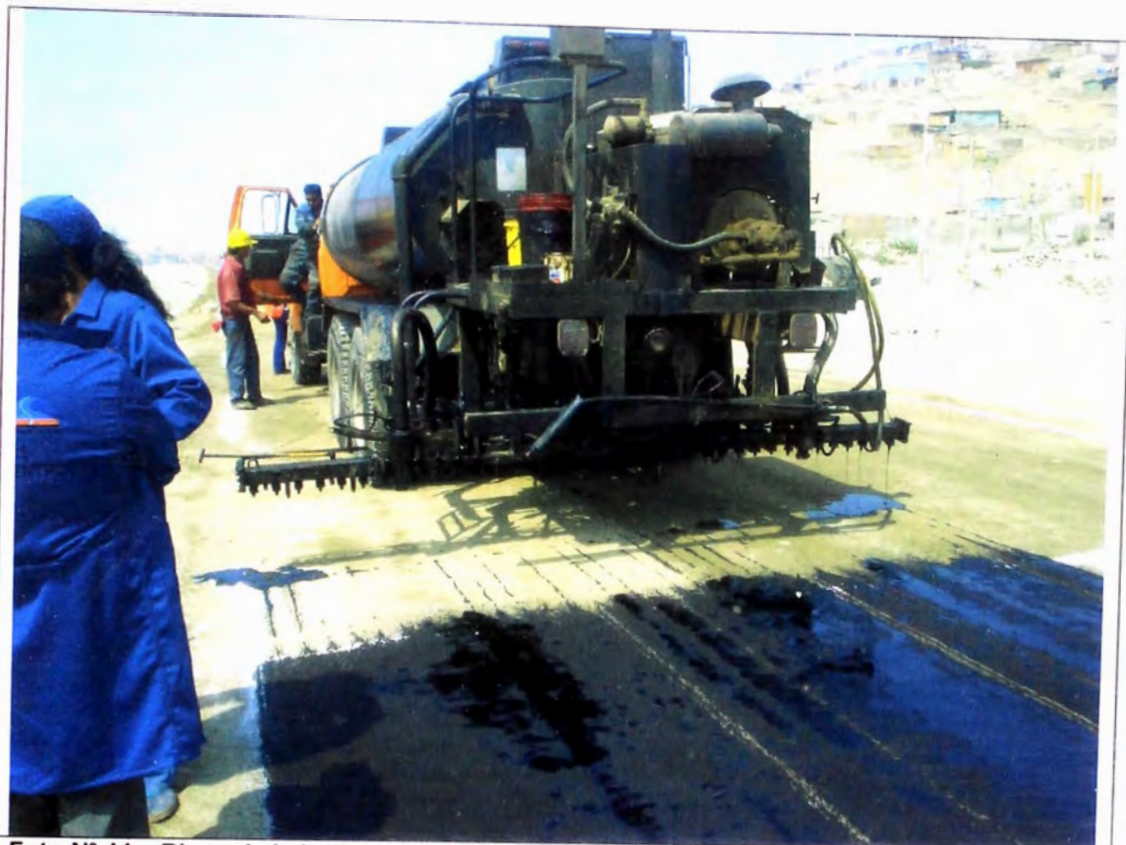
Foto N° 11 – Riego de la base afirmada (imprimación) bajo el control de personal técnico.
