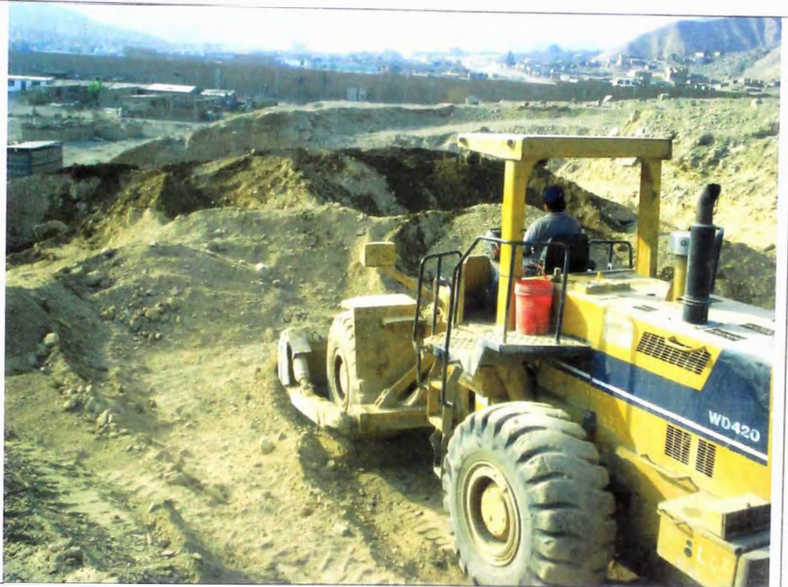
Foto N° 13 – Acumulación de material en cantera (Collanac, Km. 4+170 acceso 100 m), para rellenos y afirmado.
