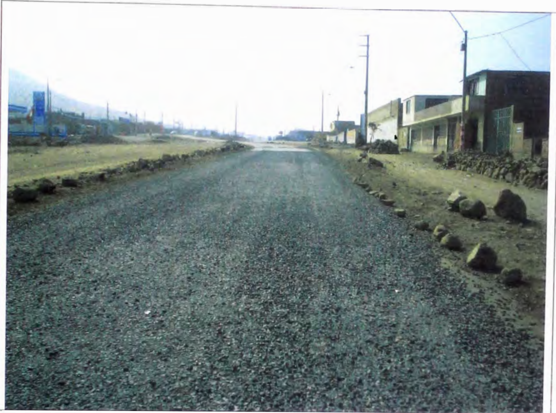
Foto N° 21 – Vista del material de 3/8" esparcido, como último proceso del tratamiento superficial bicapa, luego se le rodillará, se le colocará una capa de arena APRA evitar la exudación del líquido asfáltico, se limpiará y se colocará la señalización horizontal.
