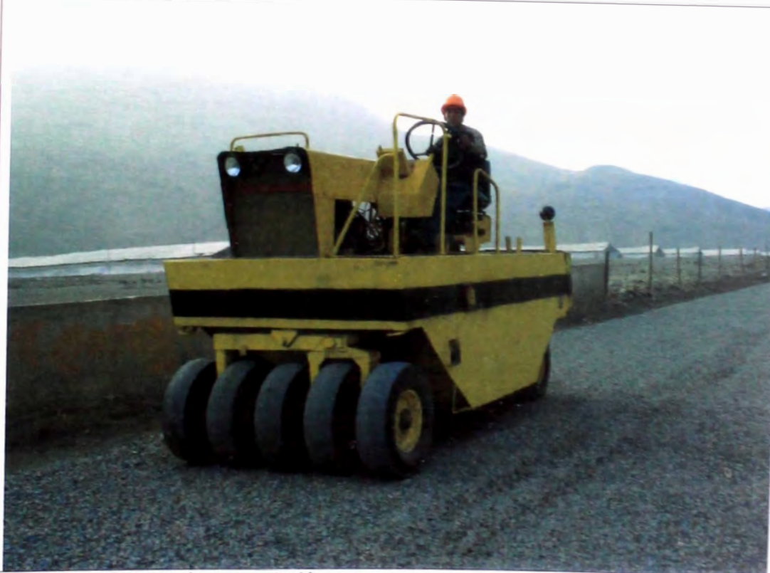
Foto N° 16 – Proceso de compactación.
