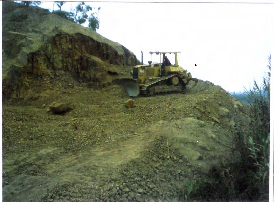
Foto N° 07 – Proceso de perfilado de taludes (corte de roca suelta) luego de ello se ejecutará el corte de roca fija para el ensanche de la plataforma mediante voladuras.
