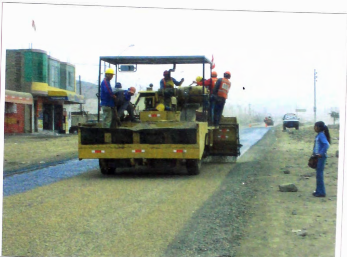
Foto N° 15 – Esparcido de la piedra de \frac{3}{4} " sobre el riego de líquido asfáltico (cut-back RC-250).
