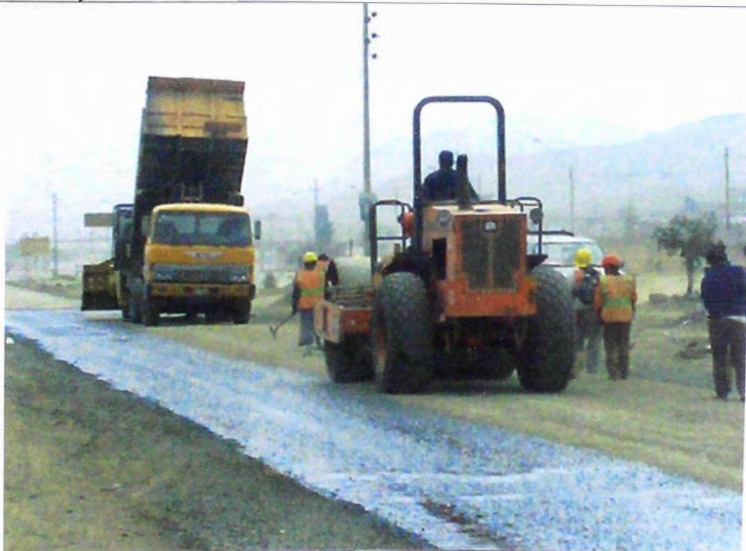
Foto N° 14 – Colocación de la primera capa del tratamiento superficial bicapa y el respectivo rodillazo del material granular (piedra de \frac{3}{4} " ).
