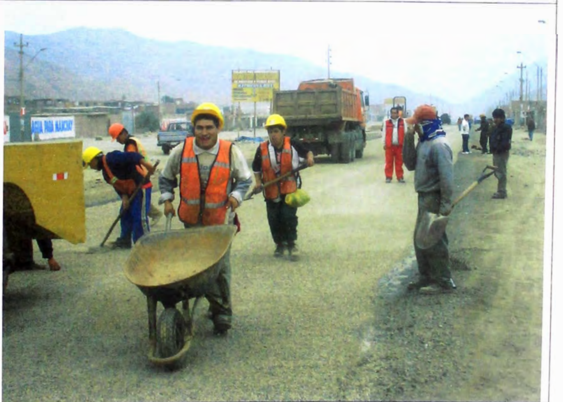
Foto N° 22 – Colocación y esparcido de piedra de 3/8" bajo el control del Asistente Técnico responsable de la obra.
