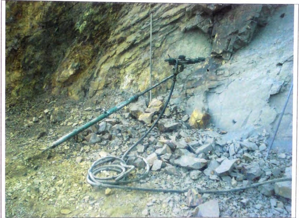
Foto N° 03 – Realizando la perforación (calambucos) para la voladura de roca fija.
