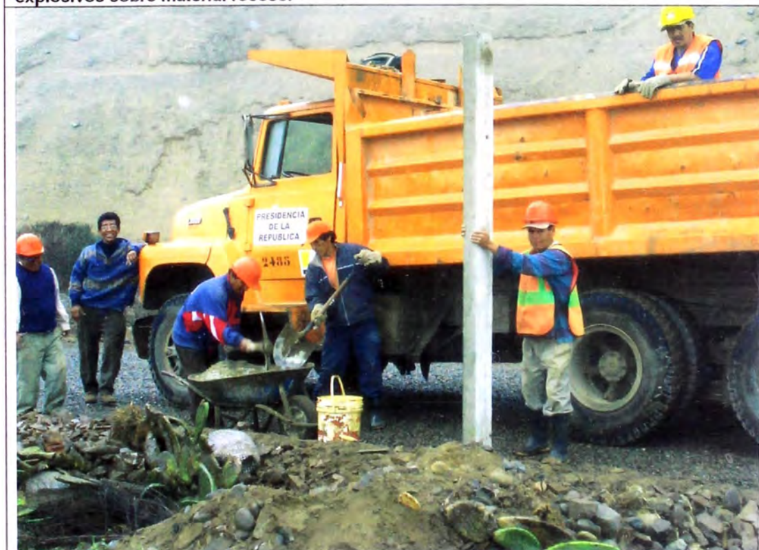
Foto N° 18 – Colocación de los postes de concreto para las señales preventivas.
