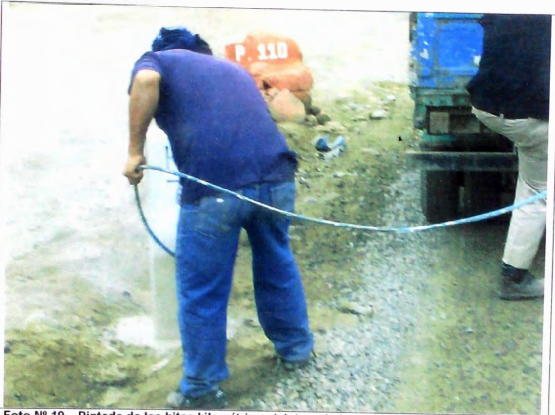
Foto N° 19 – Pintado de los hitos kilométricos (pintura de base, blanco).
