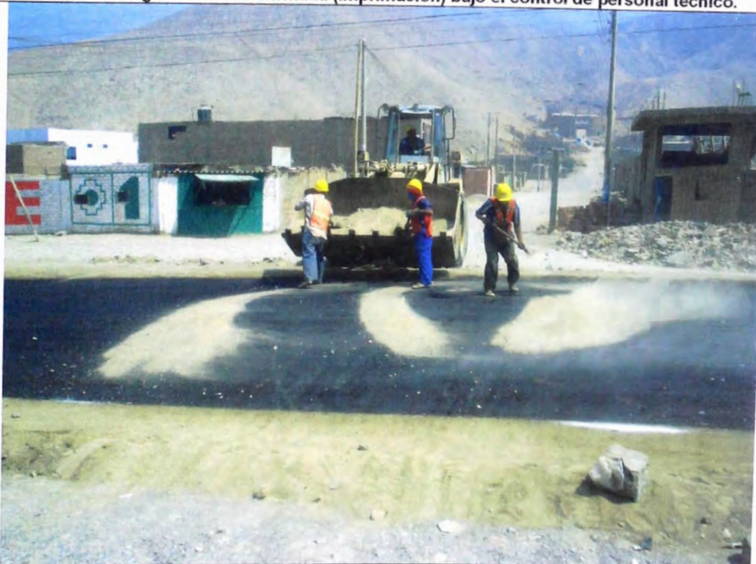
Foto N° 12 – Proceso de arenado manual sobre la base imprimada, previa a la colocación de tratamiento superficial bicapa (primera capa y segunda capa respectivamente).
