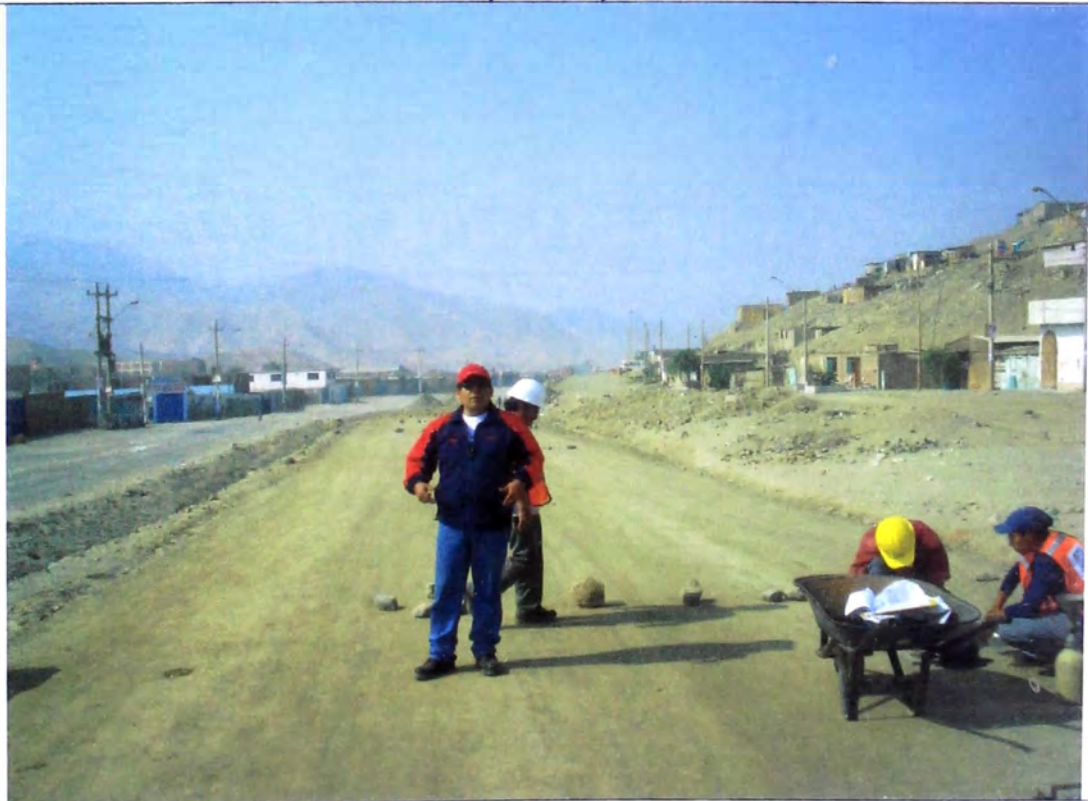
Foto N° 10 – Inspector de Obra, supervisando y/o verificando la base afirmada y control de densidad.
