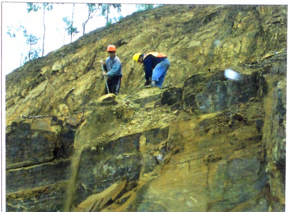
Foto N° 17 – Personal ejecutando el perforado (calambucos) para la colocación de los explosivos sobre material rocoso.
