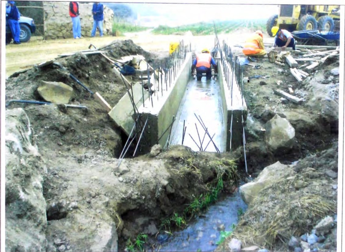
Foto N° 05 – Proceso constructivo de Alcantarilla tipo Marco
