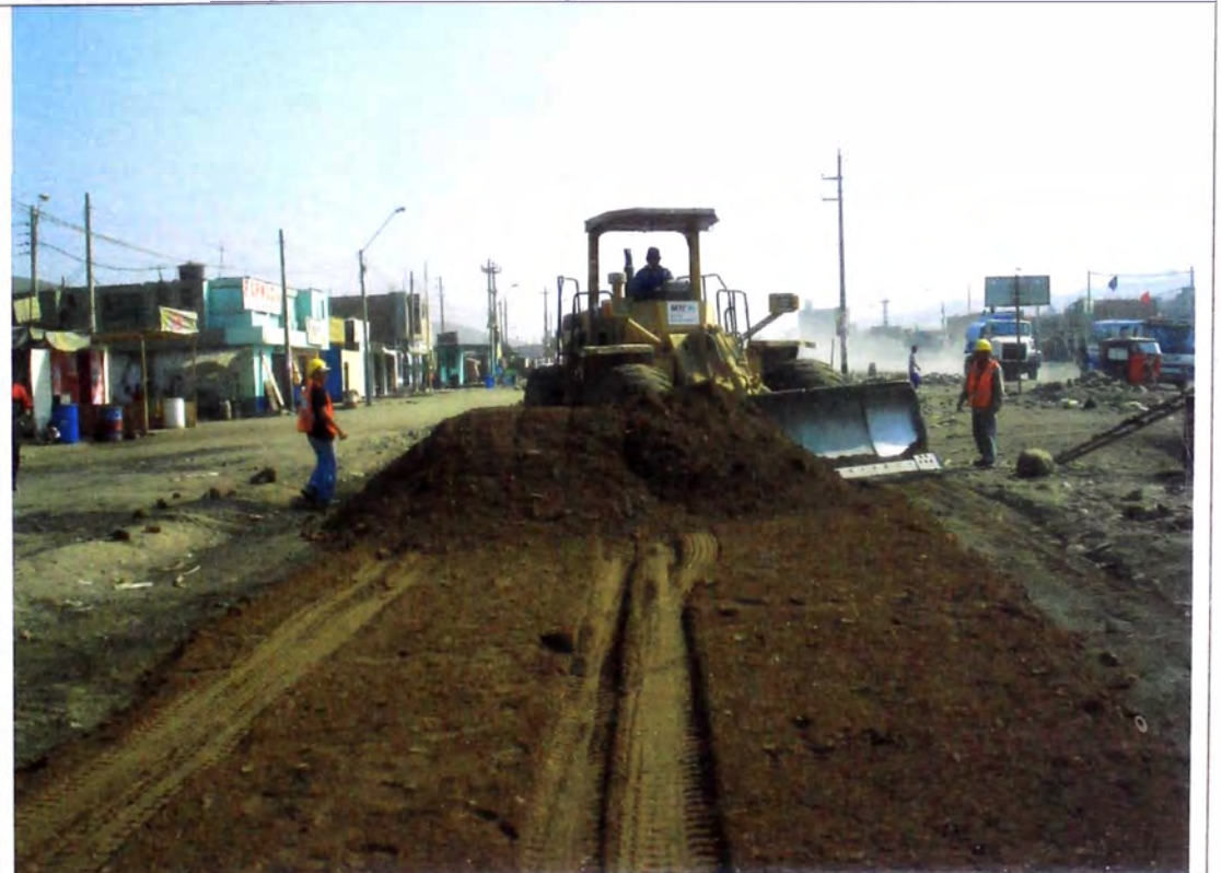
Foto N° 08 – Extendido del material de afirmado.
