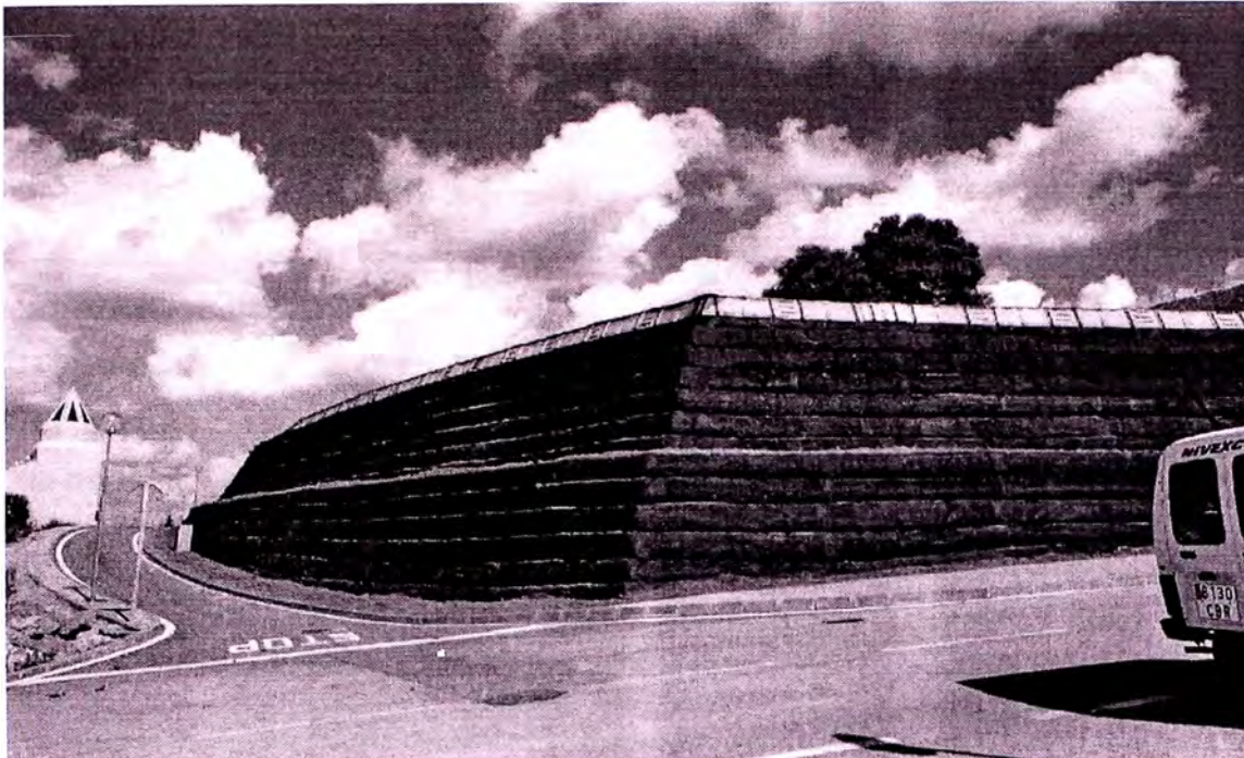
Fig. 1.11 Muro reforzado con geotextil.
