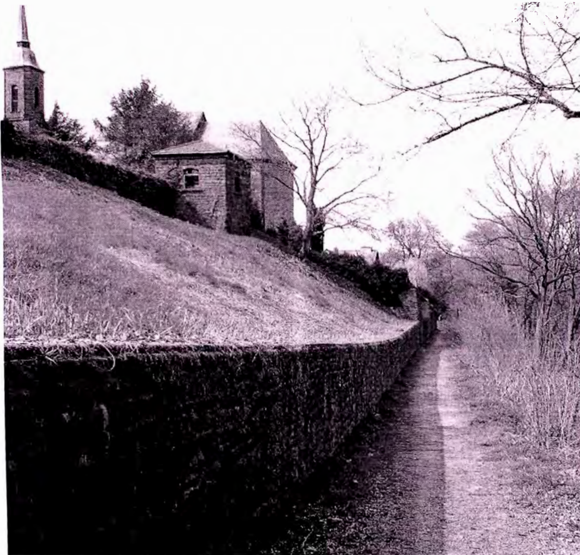
Fig. 1.1 Vista panorámica del uso de un muro de suelo reforzado.
