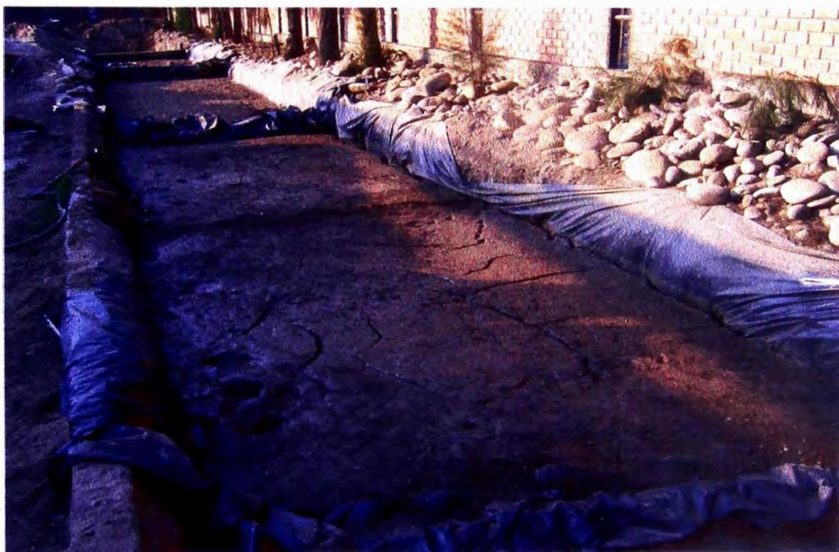
Fotografía N° 04.- Material Degradado, para realizar aplicación de mejoramiento de la subrasante, mediante la geomalla.
