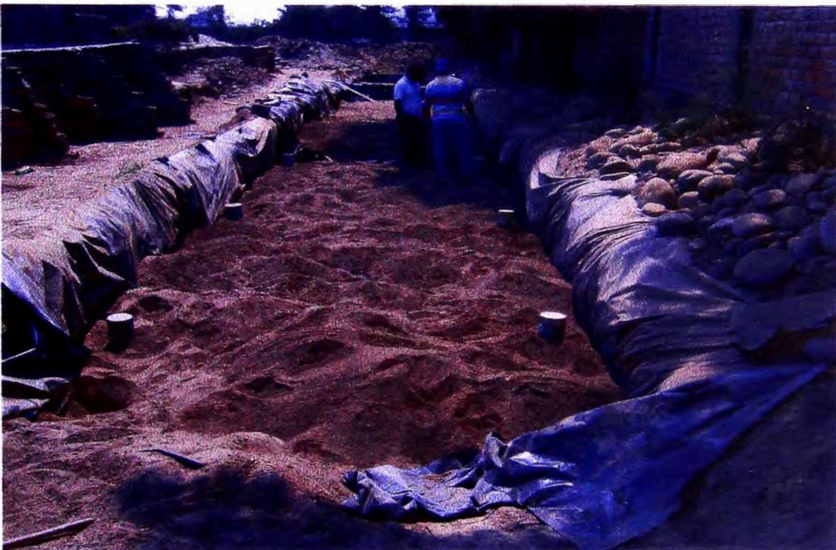
Fotografía N° 02.- Colocación de material cernido SC-SM, en el tramo de prueba, éste material presenta CBR pobres.
