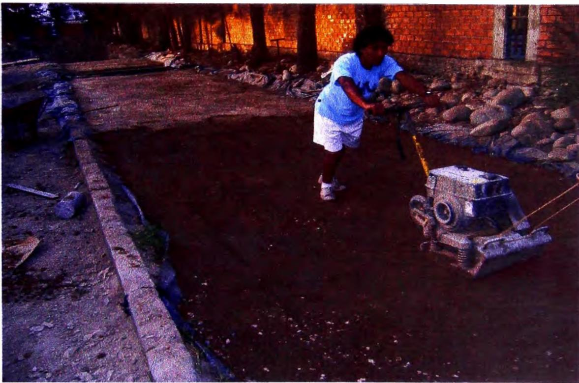
Fotografía N° 06.- Compactación de material de relleno, de acuerdo a las especificaciones técnicas.
