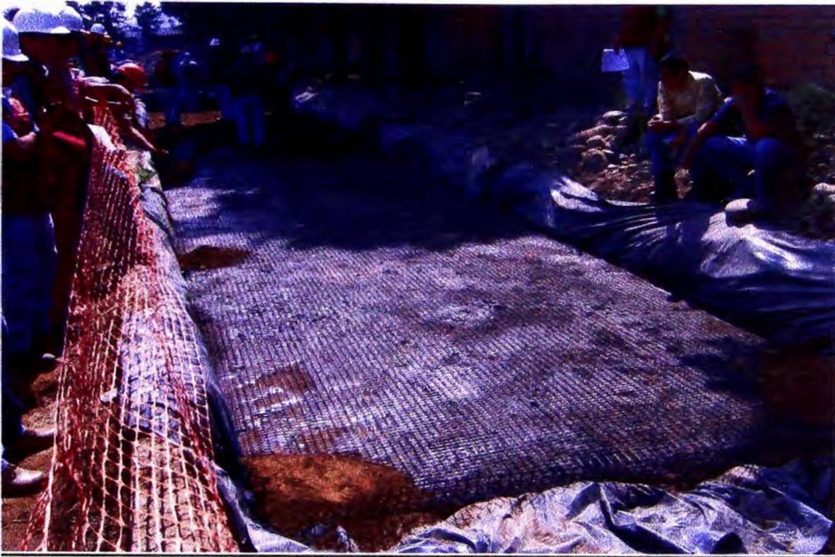
Fotografía N° 05.- Colocación de geomalla sobre material degradado.
