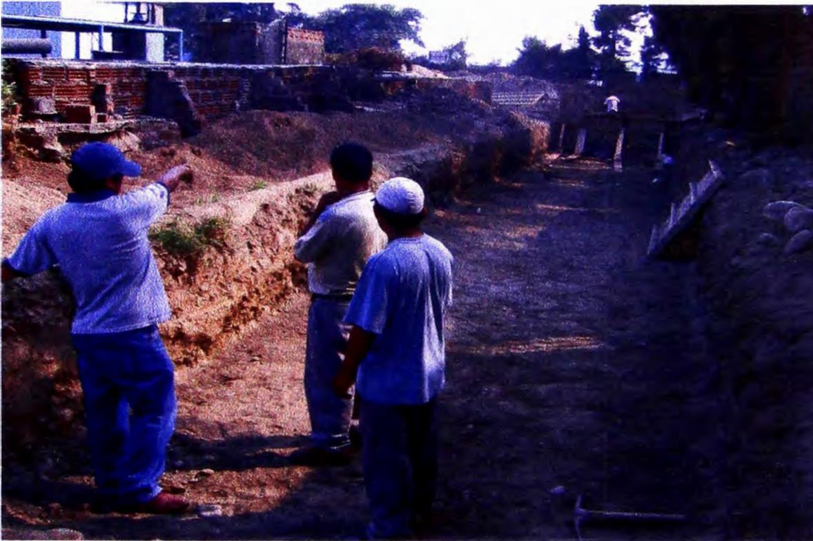
Fotografía N° 01.-Excavación de 1.2 mts., para realizar tramo de prueba sobre el comportamiento de la geomalla en terrenos que presentan CBR < 1%.
