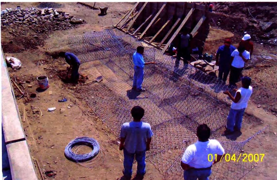
Ilustración 2.8. Colocación y despliegue de los elementos Terramesh
