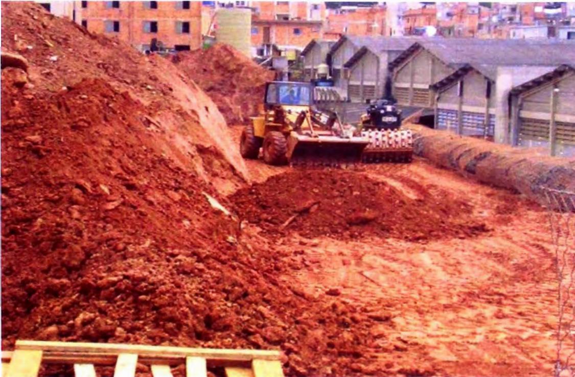
Ilustración 2.14. Colocación del material de relleno estructural
