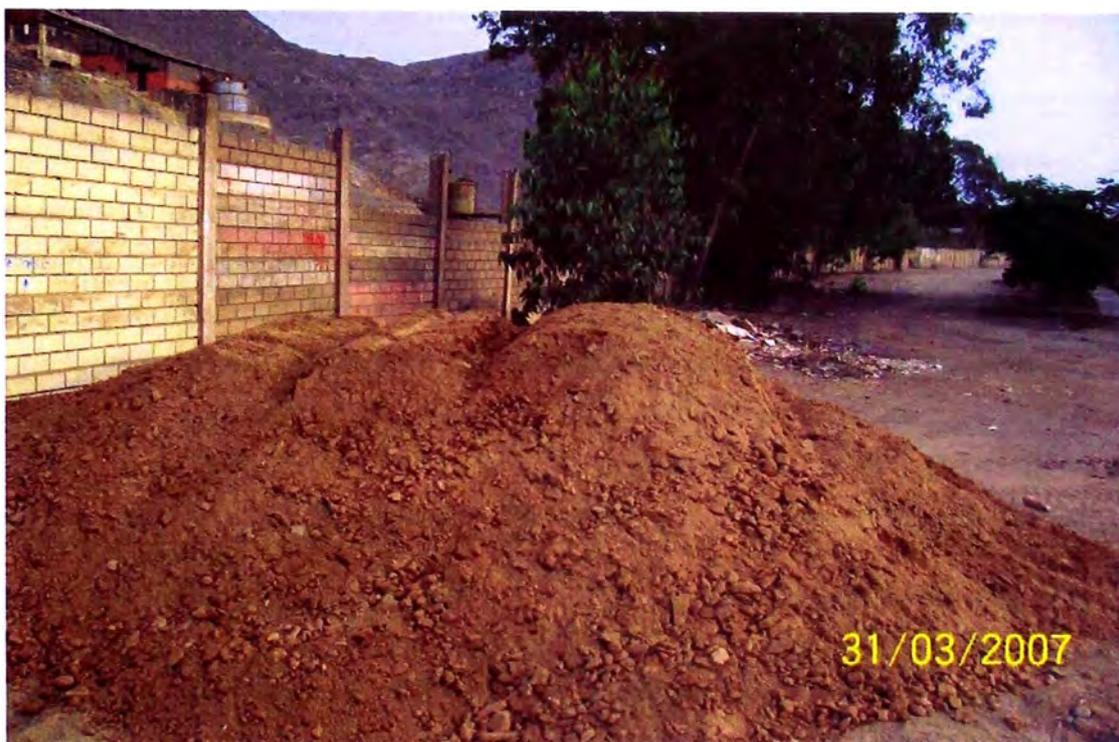
Ilustración 3.4. Apilamiento de material de relleno estructural
