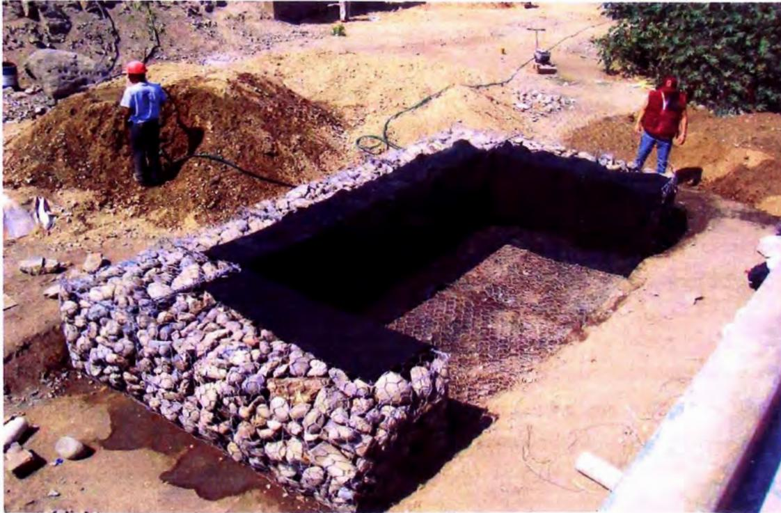
Ilustración 3.6. Colocación del geotextil de separación
