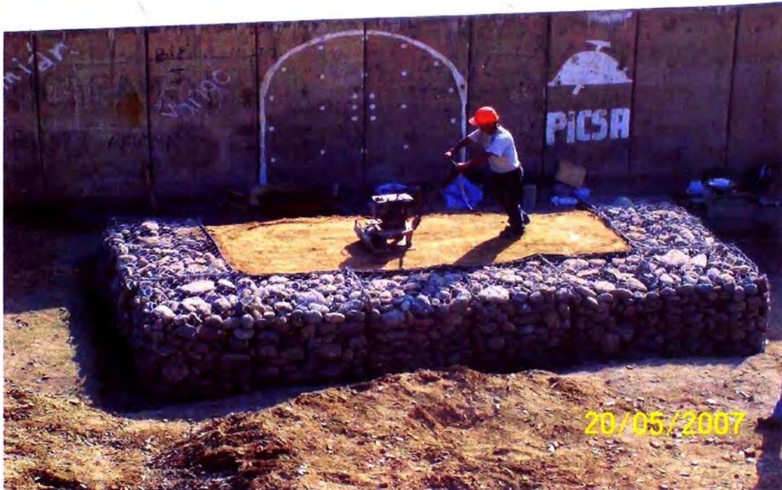
Ilustración 3.7. Compactación del material de relleno estructural
