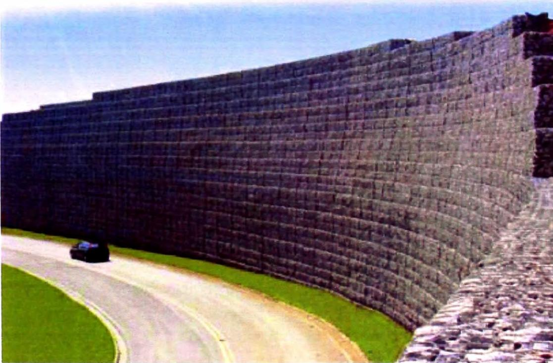
Ilustración 2.4. Estructura construida con el sistema Terramesh
