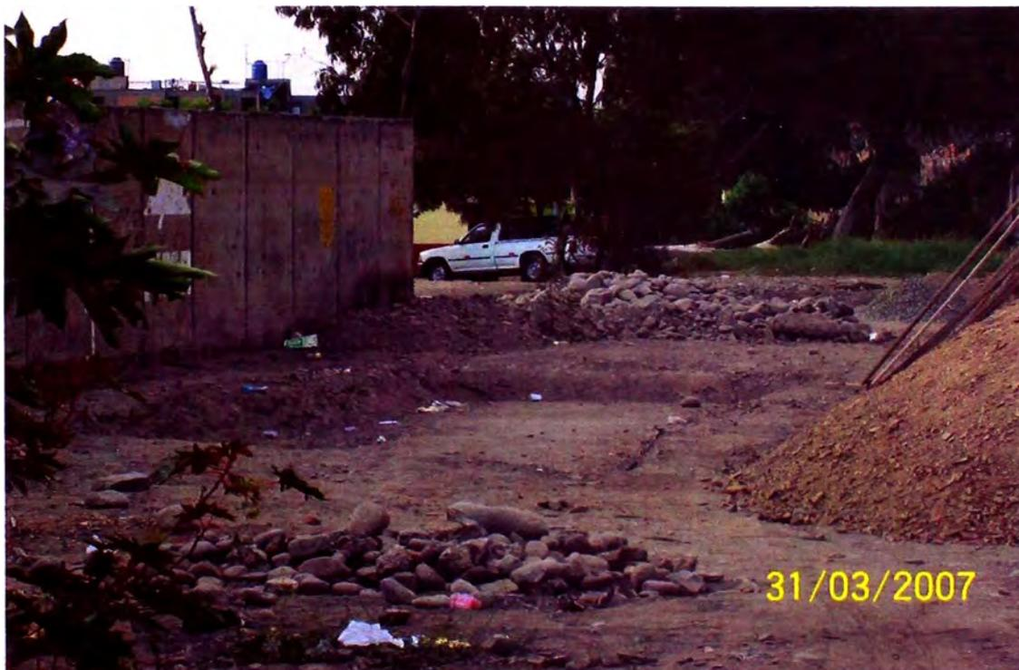
Ilustración 2.7. Nivelación del terreno antes de colocar elementos Terramesh
