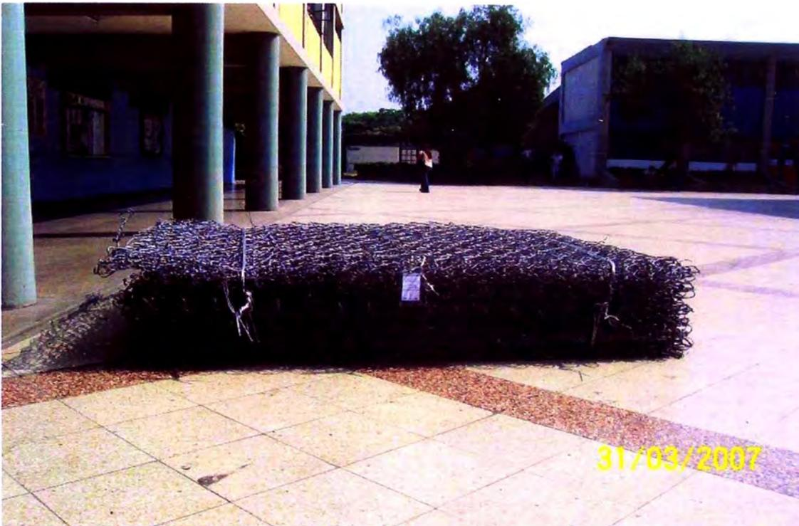
Ilustración 3.1. Elementos Terramesh entregados en obra
