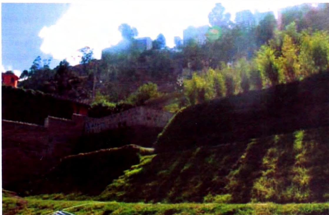
Ilustración 2.6. Muro reforzado con el sistema Terramesh Verde
