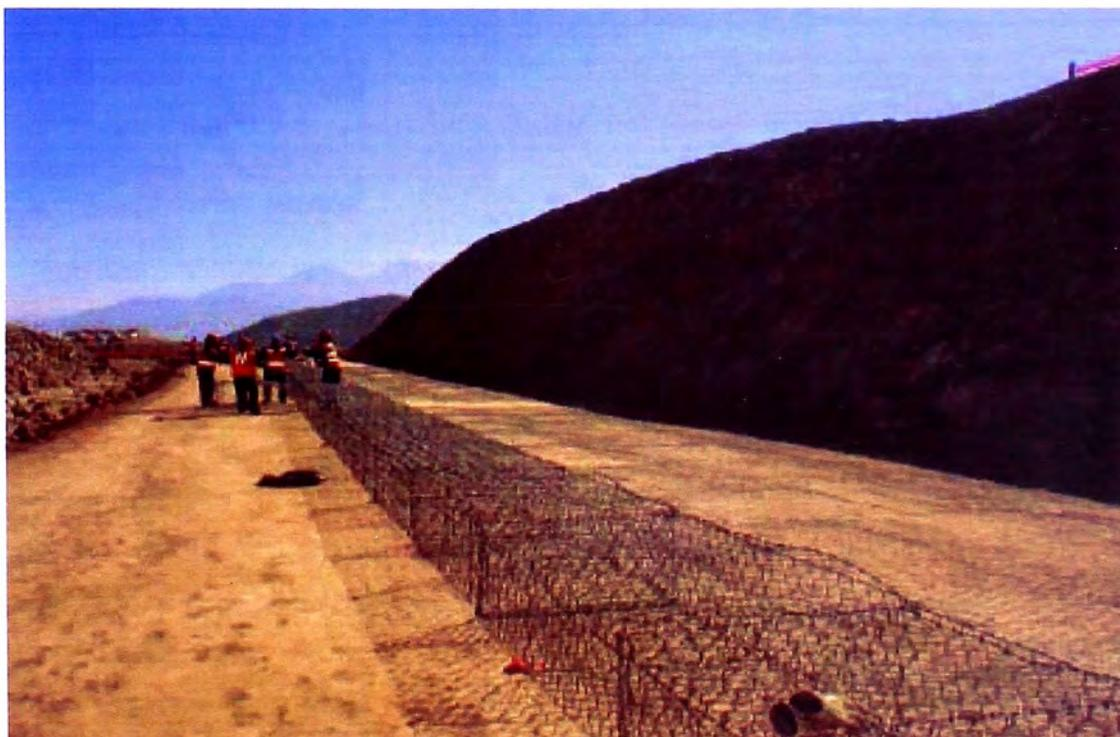
Ilustración 2.3. Elementos Terramesh dispuestos y armados en obra
