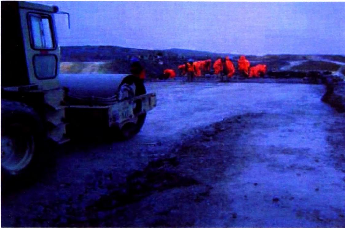
Ilustración 2.15. Proceso de compactación utilizando equipo pesado
