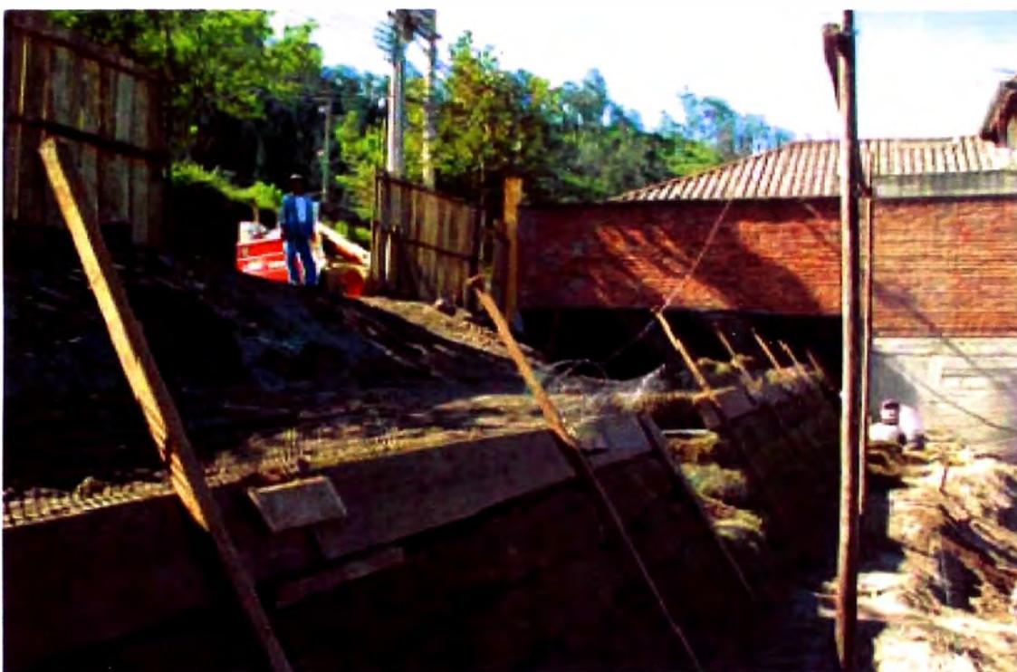
Ilustración 2.5. Construcción de un muro utilizando el sistema Terramesh Verde
