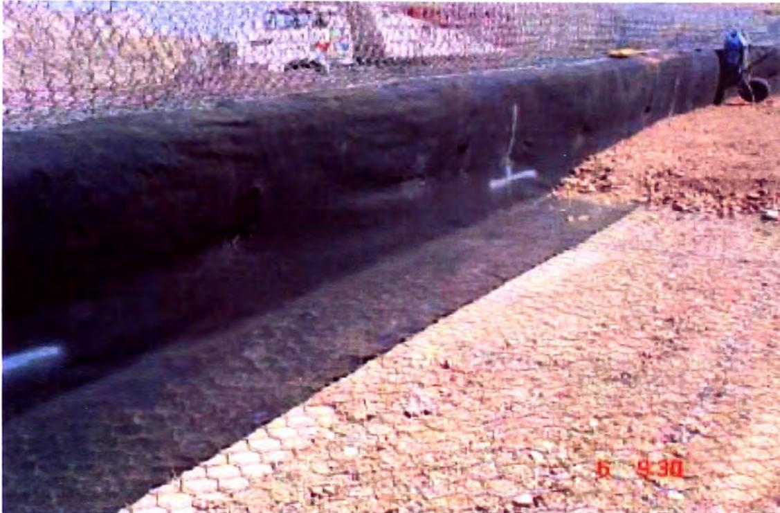
Ilustración 2.12. Colocación del geotextil de separación
