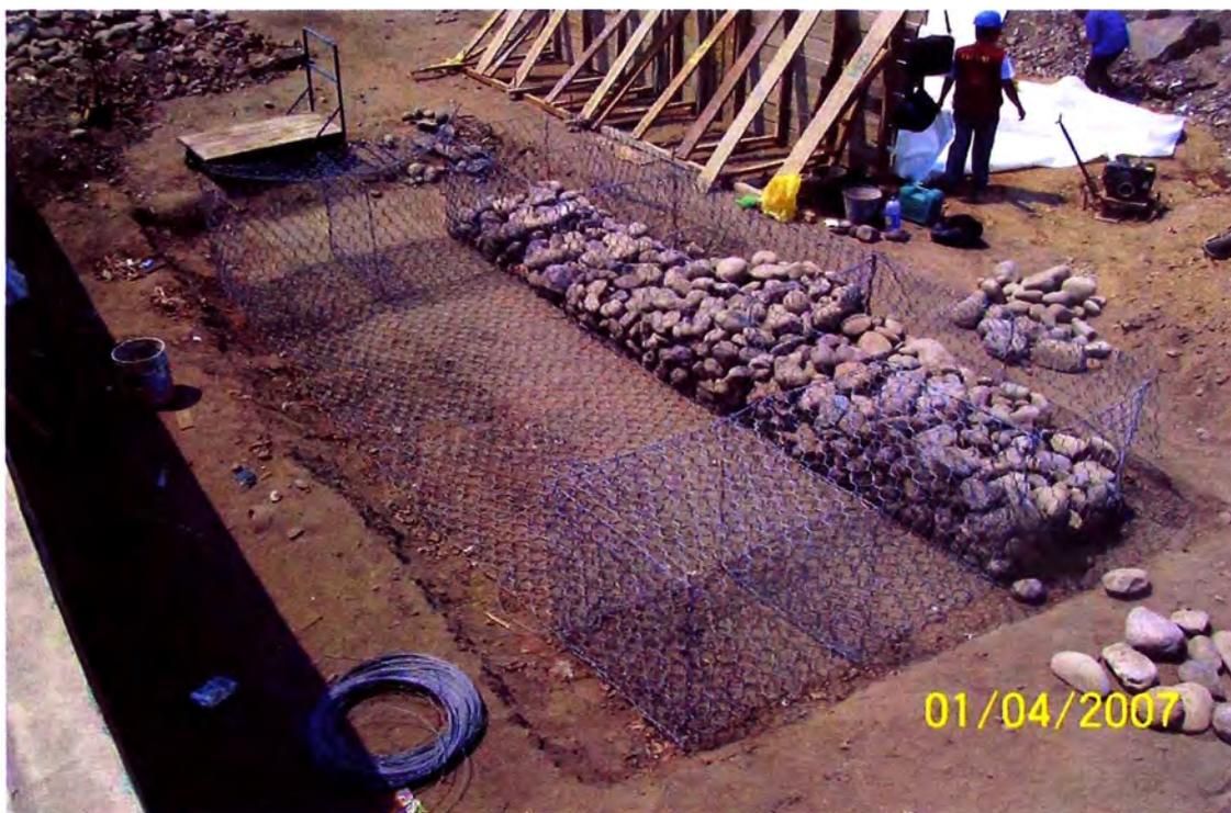
Ilustración 2.10. Colocación de la piedra dentro de los elementos Terramesh
