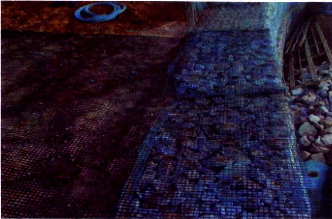
Ilustración 2.13. Colocación de geomalla de refuerzo adicional
