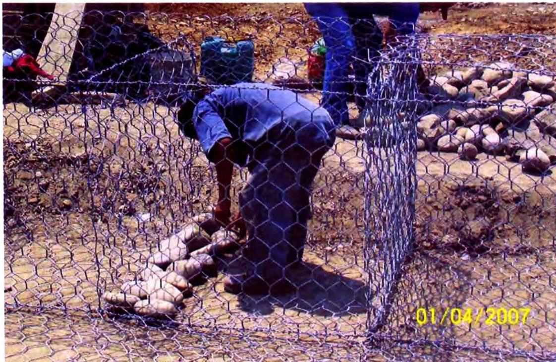
Ilustración 3.5. Colocación de la piedra dentro de las cajas de gaviones
