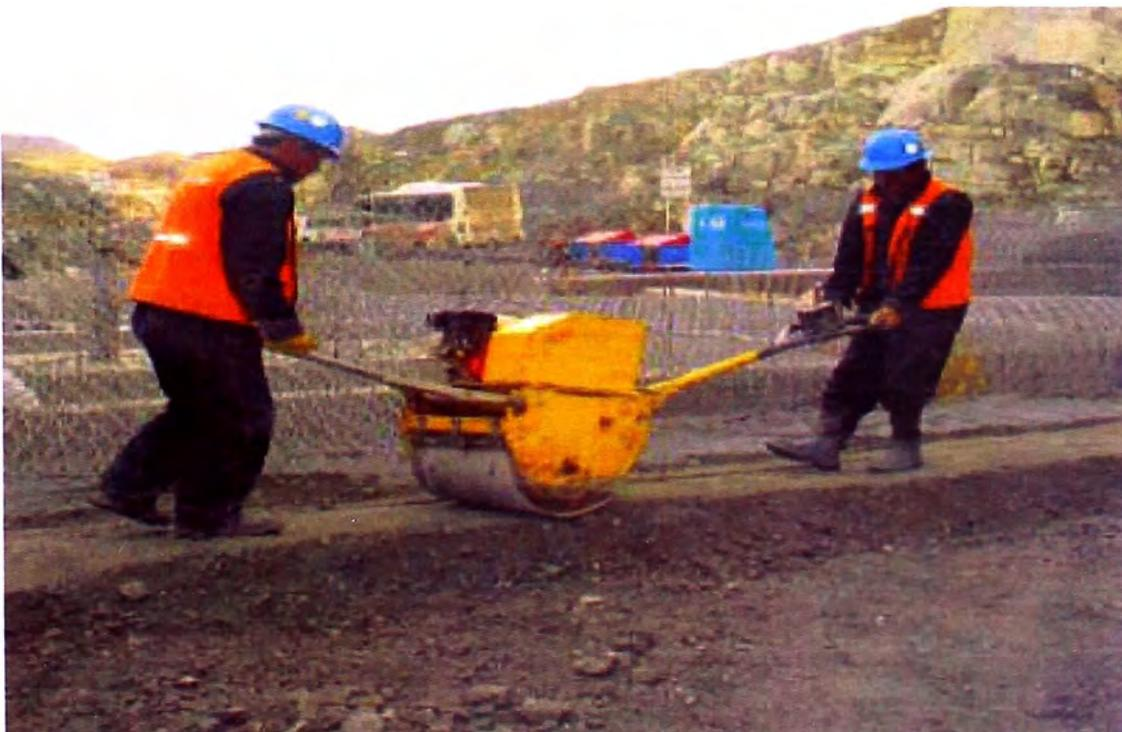
Ilustración 2.16. Proceso de compactación utilizando equipo liviano
