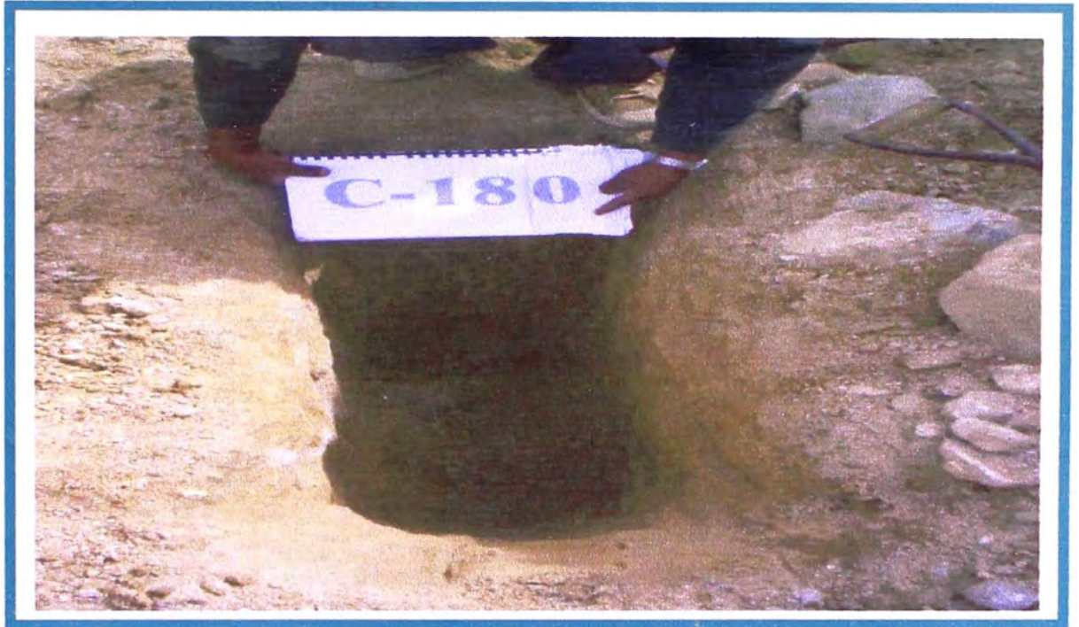
FOTO N° 27: Pozo C-180.- Se observa superficialmente y hasta la profundidad explorada de 1.50m material de arena limosa con gravas color blanquecino.
