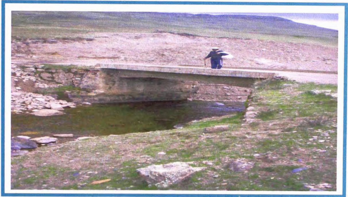
FOTO 35: Vista panorámica donde se observa el Río Ñahuinlla en el Km. 32+570
