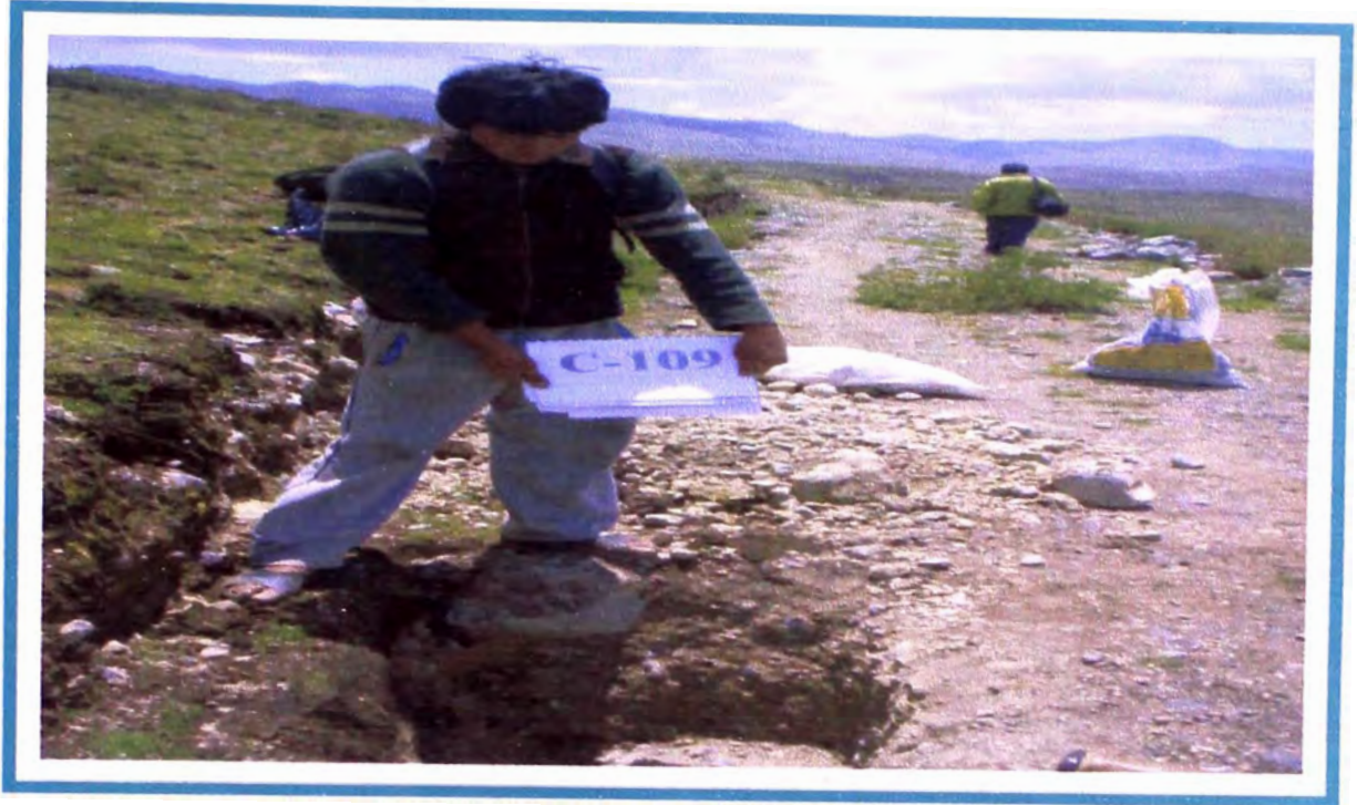
FOTO N° 21: Vista panorámica de la ubicación del pozo C-109.
