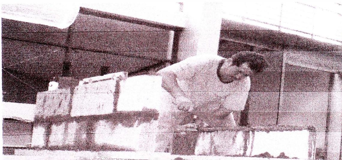
*Foto: Ahorro significativo en relación al volumen de mortero usado, velocidad de construcción, más rendimiento por m<sup>2</sup> de muro levantado. Su superficie caravista permite ahorrar el costo de tarrajeo. Se transportan más unidades en menos tiempo, los bloques de concreto celular, son un 25% más livianos que los bloques de concreto convencional.*
