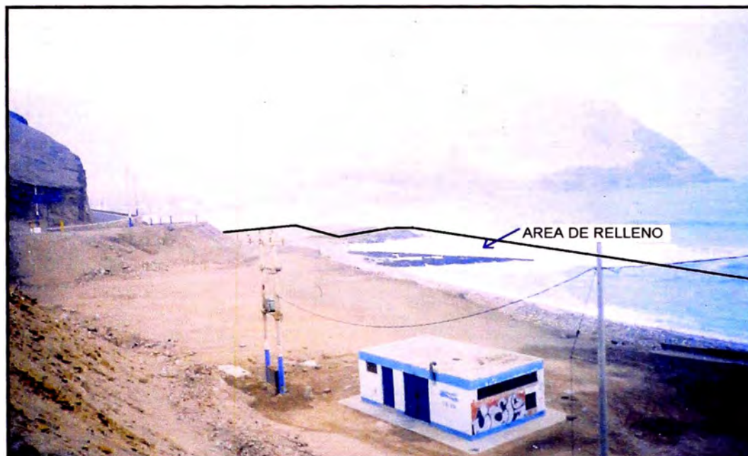
Foto N°3: Ubicación del Área del Relleno donde se ganará al mar, para la conformación de la Marina.
