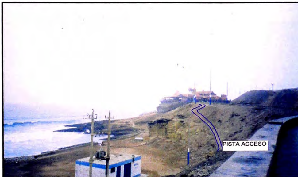
Foto N°2: Vista de la Pista de Acceso donde circulará los vehículos para el ingreso de la Marina.
