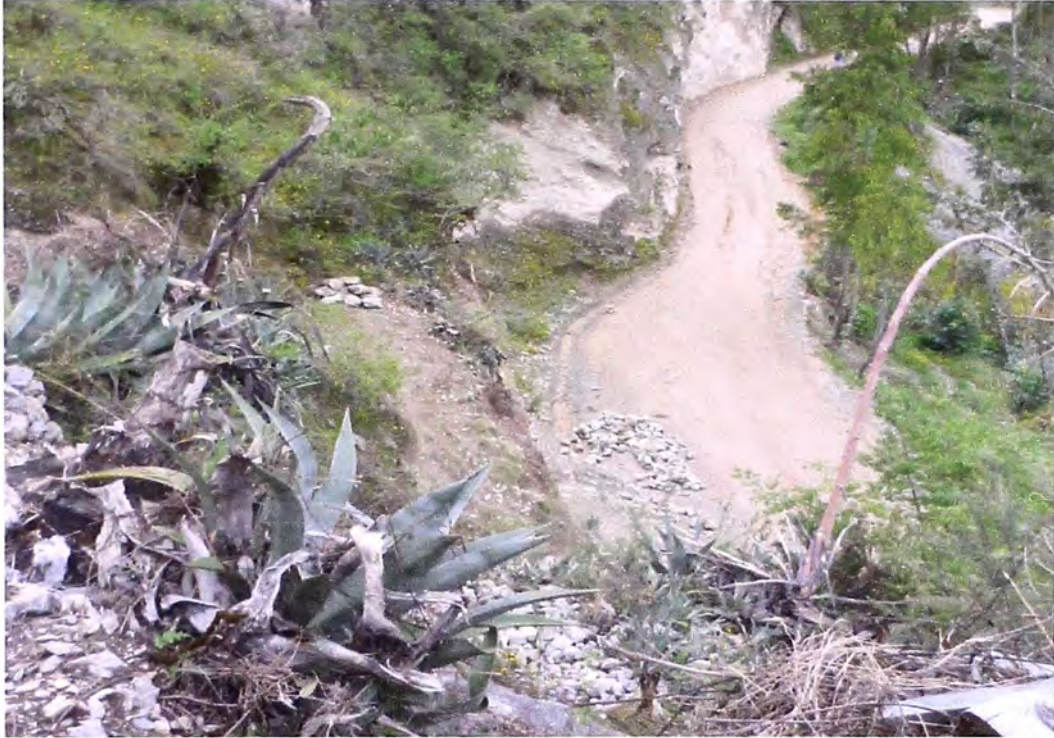
Foto N° 01: Vista del Tramo de la zona de Trabajo.
