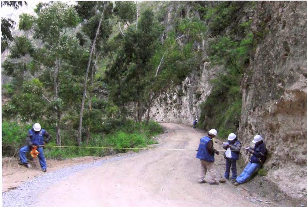
Foto N° 02: Toma de Datos para Diseño. para la ampliación de la vía será necesario realizar actividades de corte.
