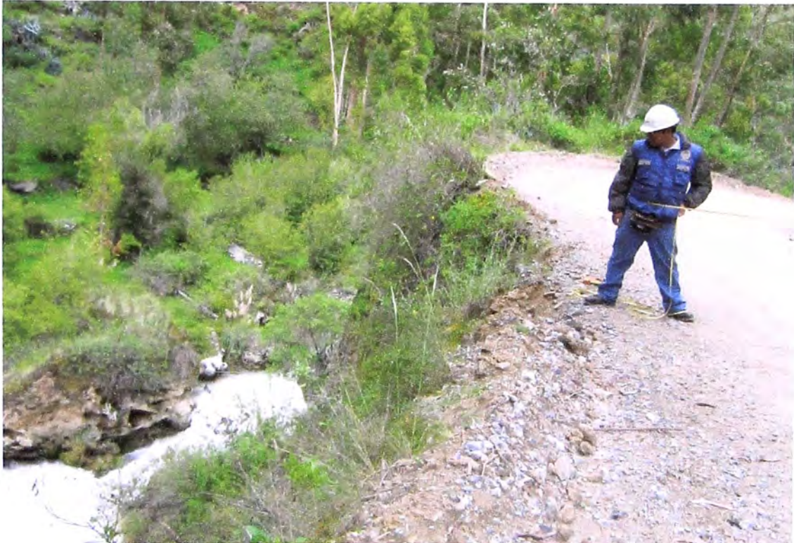
Foto N° 03: Talud derecho de vía, limitado por el Río Alis.
