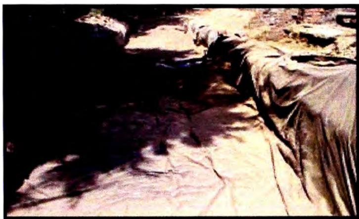
El geotextil tejido se deberá extender sin arrugas o dobleces en la dirección de avance de la construcción, directamente sobre la subrasante conformada o preparada.
