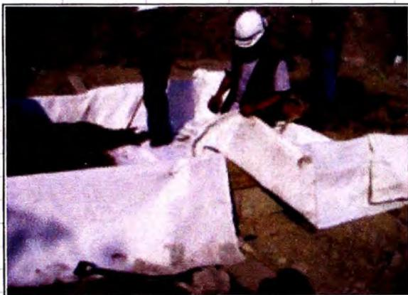
Traslape de 30cm del Geotextil
