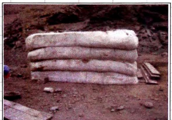
Vista Frontal del Muro de Contención de Suelo Reforzado con Geotextil
