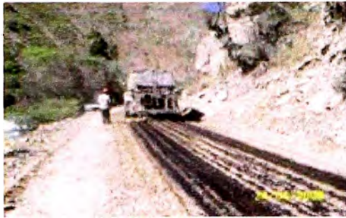
Colocación Emulsión en afirmado
