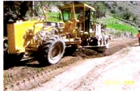
Reconformación del afirmado con emulsión
