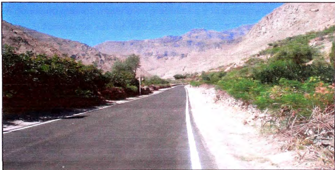
Figura N° 1.04: Tramo a realizar la evaluación estructural
