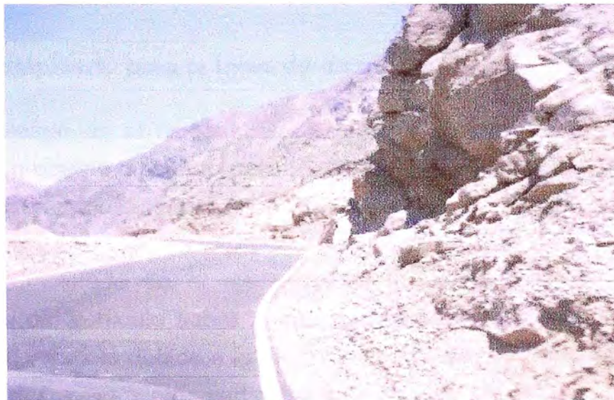
Reconocimiento del tramo y ubicación de las interferencias
