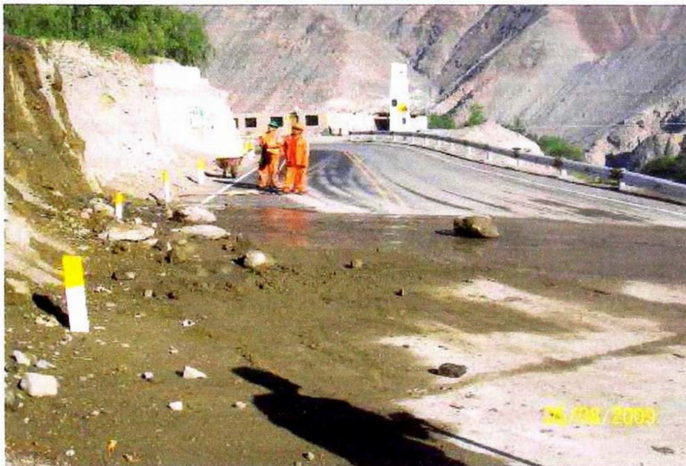
Figura 1.4: Mantenimiento rutinario de la carretera ( limpieza )
