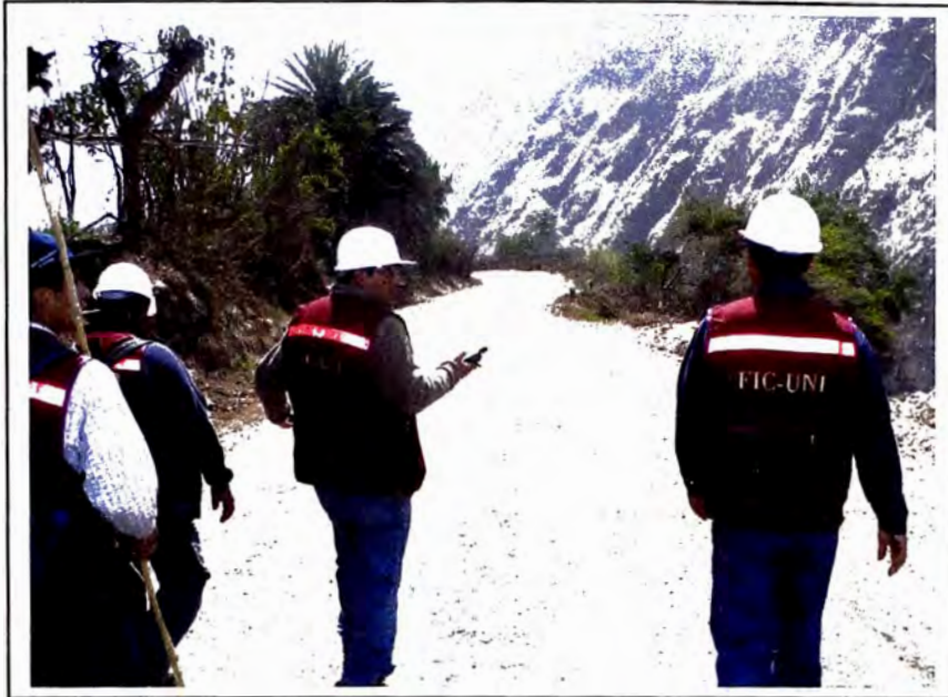
FOTO FOTO 1 VISTA PARCIAL DE LA CARRETERA
