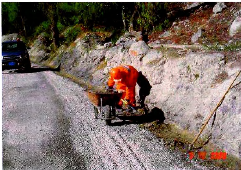
Foto. VISTA DE LIMPIEZA DE CUNETAS EN EL KM.99+000.
