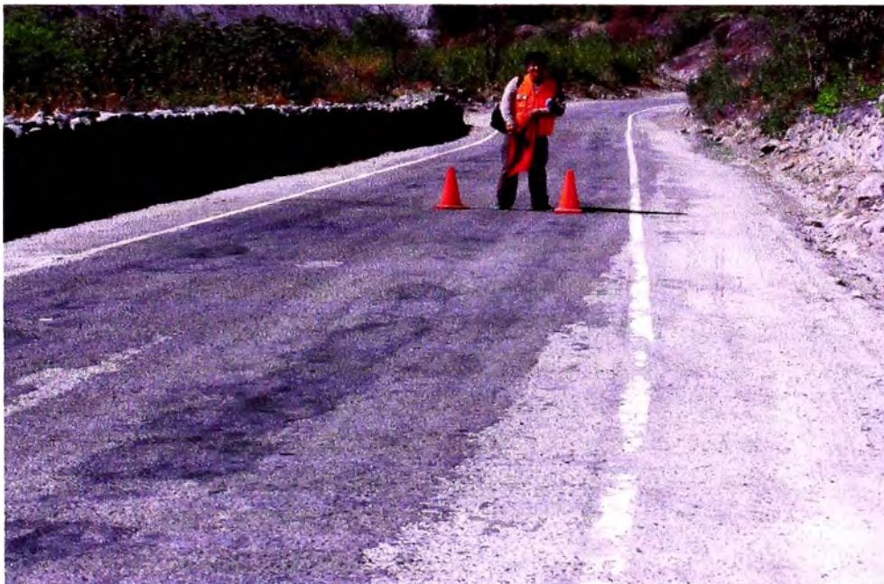
Figura N° 3.05: Vista de conos y personal de seguridad.
