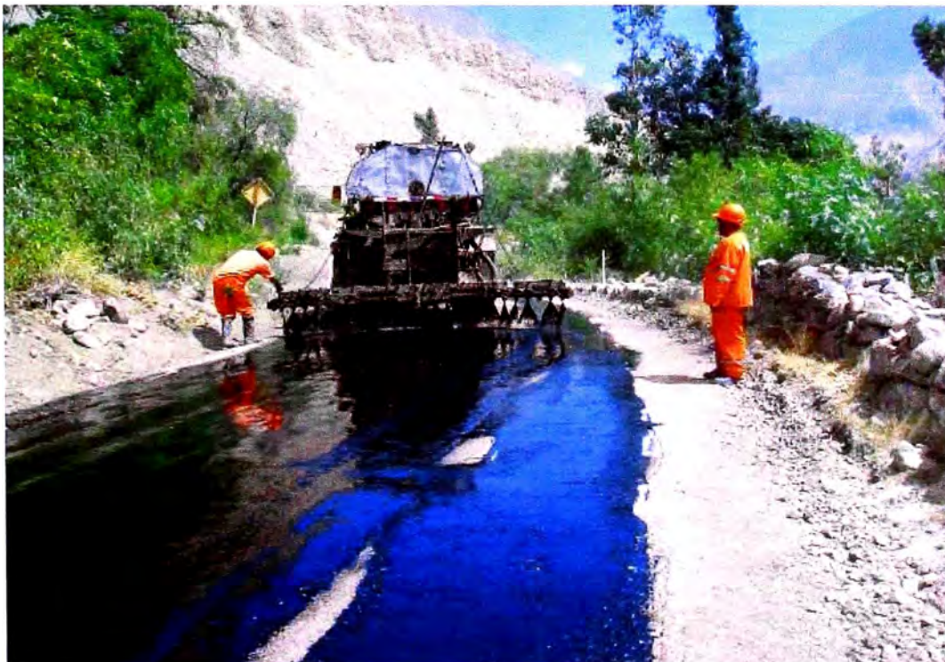
Foto. VISTA DE COLOCACION DE TRATAMIENTO SUPERFICIAL MONOCAPA KM.99+000 AL KM.104+000.
