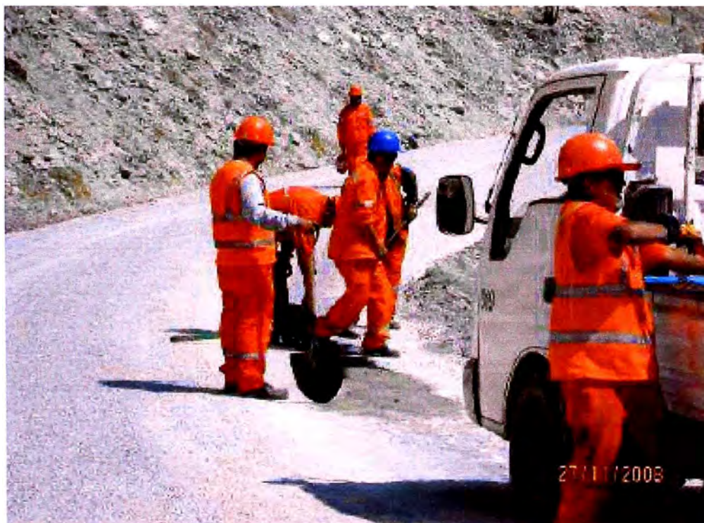
Foto. VISTA DEL PARCHADO Y CORRECCION DE IMPERFECCIONES DE CAPILLUCAS A CALACHOTA.
