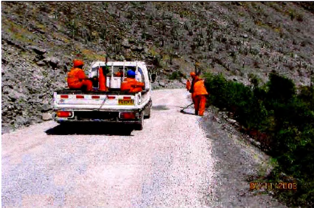
Foto. VISTA DEL PARCHADO Y CORRECCION DE IMPERFECCIONES DE CAPILLUCAS A CALACHOTA.
