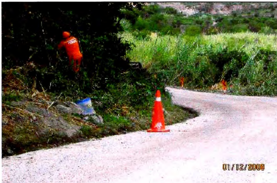
Foto. ROCE Y COLOCACION DE SEÑALES PROVISIONALES EN EL KM.99+800.
