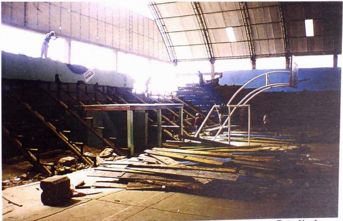
DESMONTAJE DE GRADERIAS
