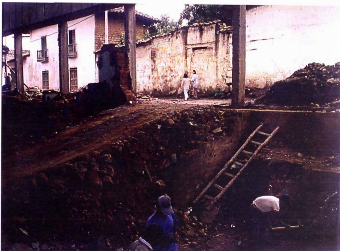
RAMPA PROVISIONAL PARA INGRESO
