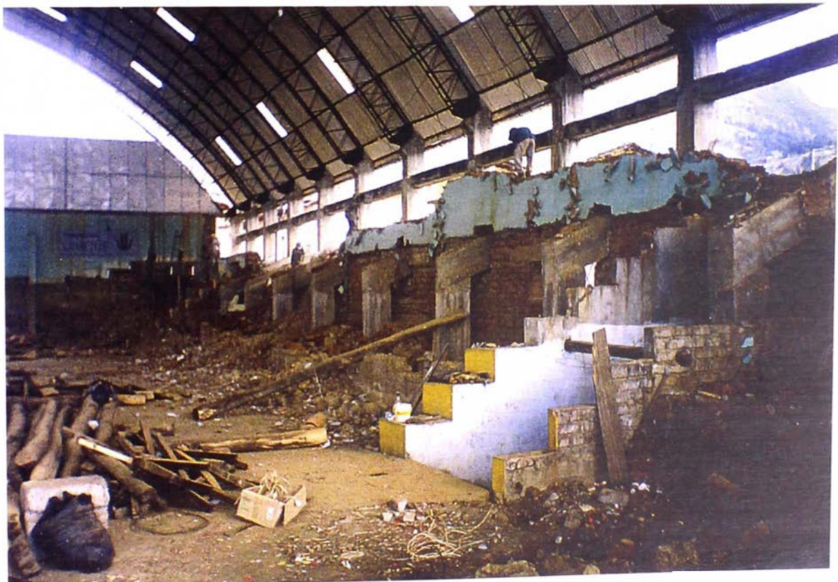
DEMOLICIÓN MANUAL DE MUROS
