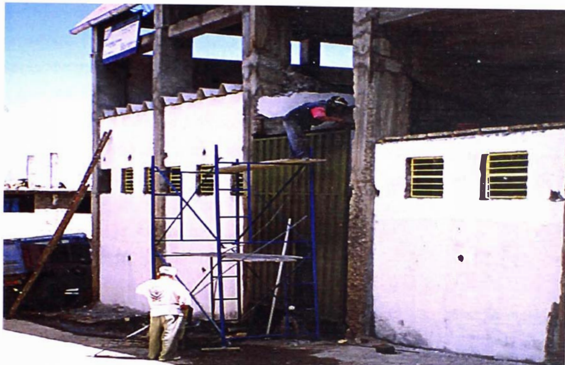
Instalación de Portón, Ventanas instaladas
