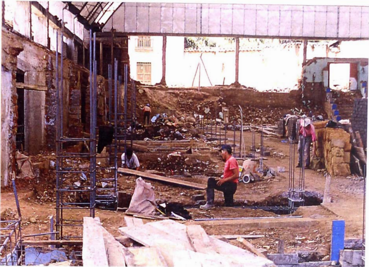
FIERRO EN COLUMNAS Y VIGAS DE CIMENTACIÓN
