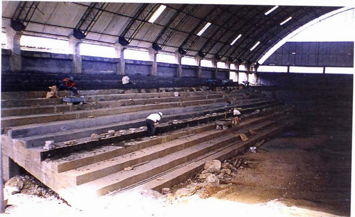
TARRAJEO DE GRADERÍAS
