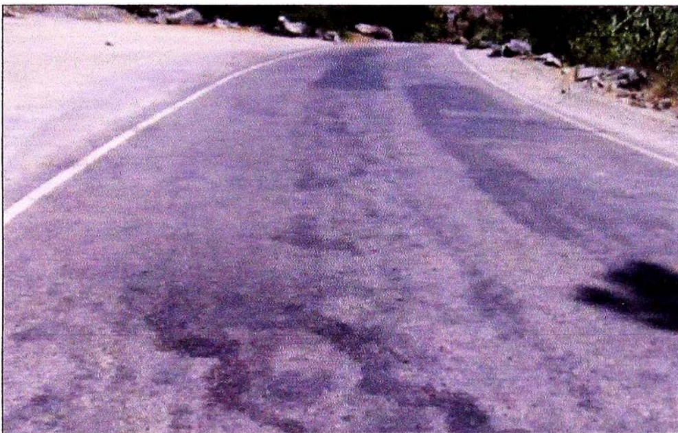
F6 COLORACIÓN DIFERENTE EN ZONA DE BACHEO
