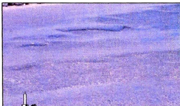
Fig. N°3.30: Deformación por empuje severidad alta Fuente: Catalogo de Fallas del MTC
