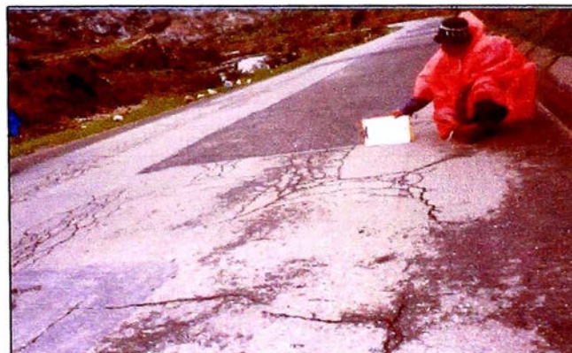
Fig. N°3.25: Baches y zanjas reparadas
