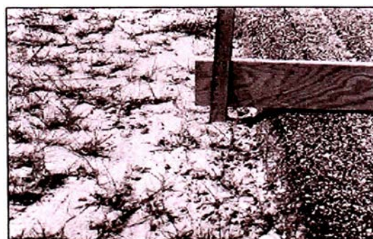
Fig. N°3.22: Desnivel calzada - Hombrillo severidad baja
