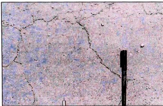
Fig. N°3.07: Falla en bloque severidad baja
