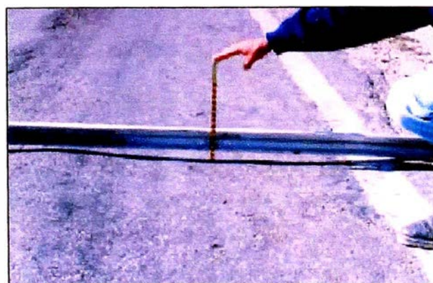
Fig. N°3.29: Ahuellamiento severidad alta
