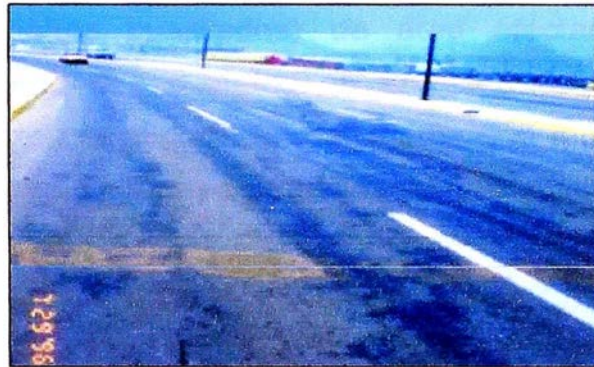
Fig. N°3.05: Exudación severidad media Fuente: Apuntes de Clase Ing. Luisa Shuan Lucas
