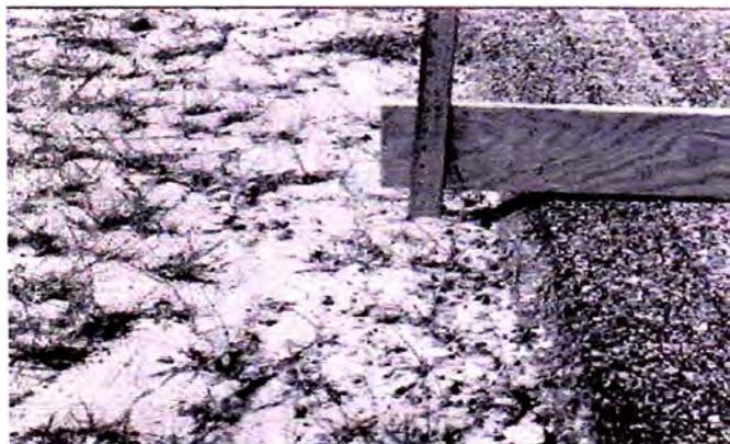
**Fig. X1.25 Desnivel Carril-Berma – Baja Severidad**
