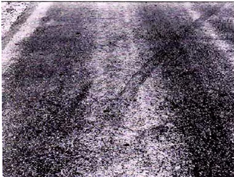
**Fig. X1.4 Exudación – Baja Severidad**
