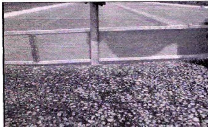
**Fig. X1.42 Ahuellamiento – Mediana Severidad**
