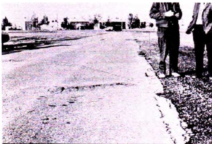
**Fig. X1.11 Abultamientos y Hundimientos – Mediana Severidad**
