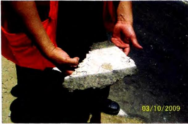
**Desprendimiento de la capa de Slurry Seal**
