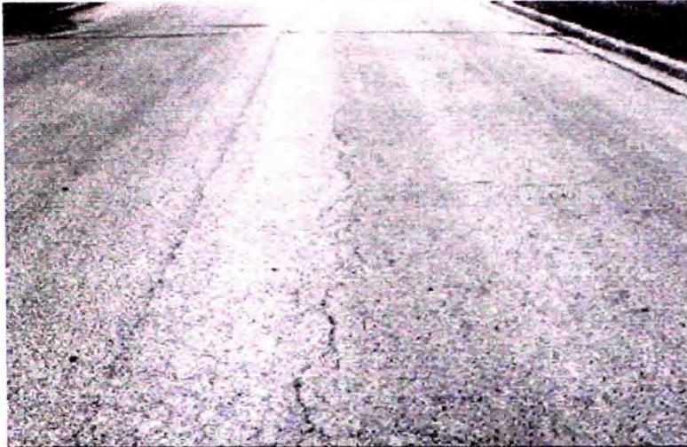
**Fig. X1.1 Piel de Cocodrilo – Baja Severidad**
