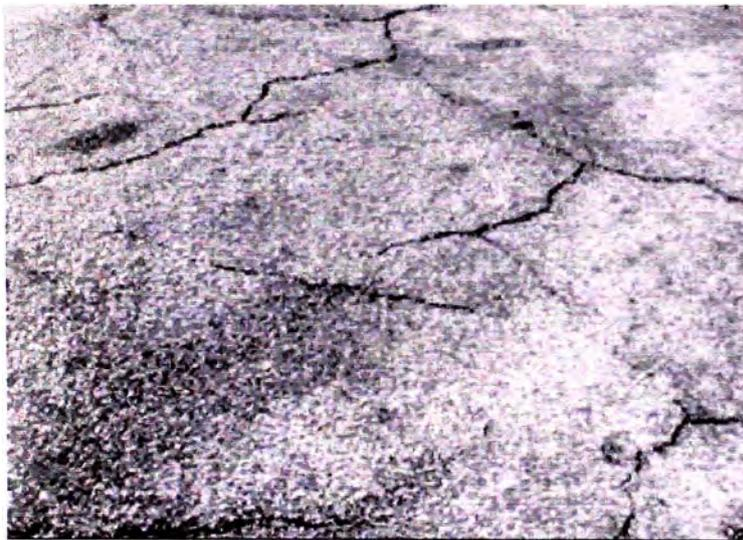
**Fig. X1.10 Abultamientos y Hundimientos – Baja Severidad**
