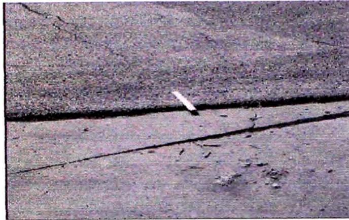
Fig. X1.45 Desplazamiento – Mediana Severidad
