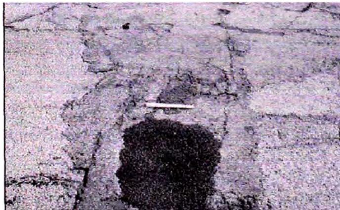
**Fig. X1.33 Parches y Parches de Cortes Utilitarios – Alta Severidad**
