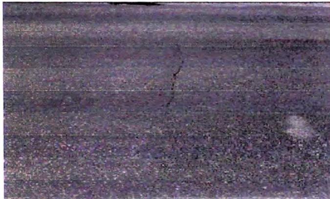
Fig. X1.28 Fisura Longitudinal y Transversal – Baja Severidad
