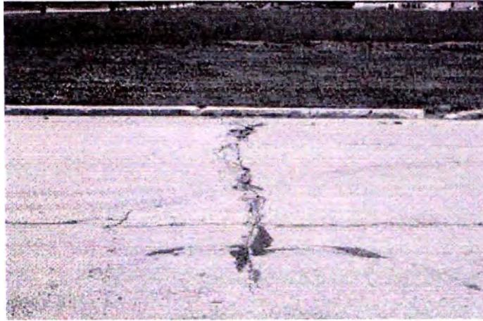
Fig. X1.30 Fisura Longitudinal y Transversal –Alta Severidad
