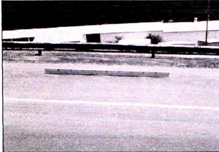
Fig. X1.14 Corrugación – Mediana Severidad
