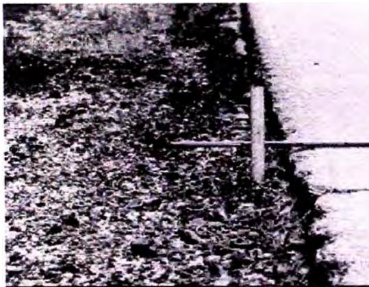
Fig. X1.27 Desnivel Carril-Berma – Alta Severidad
