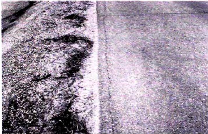
Fig. X1.19 Fisura de Borde – Baja Severidad
