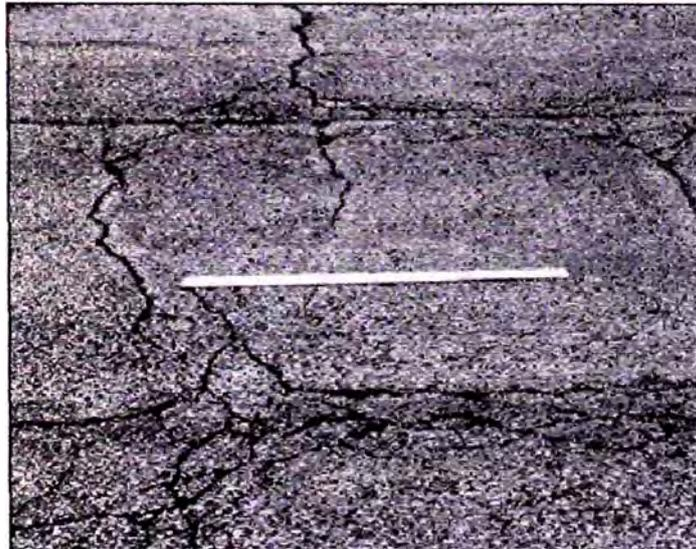
**Fig. X1.7 Fisuras en Bloque – Baja Severidad**
