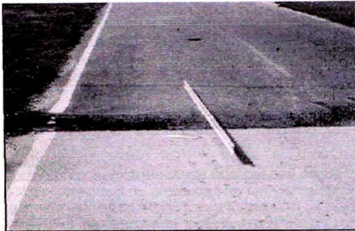
**Fig. X1.47 Fisura Parabólica o por Deslizamiento – Baja Severidad**
