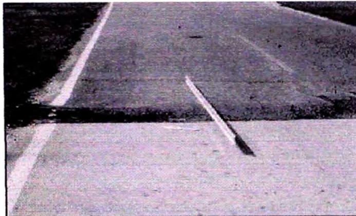
Fig. X1.46 Desplazamiento – Alta Severidad
