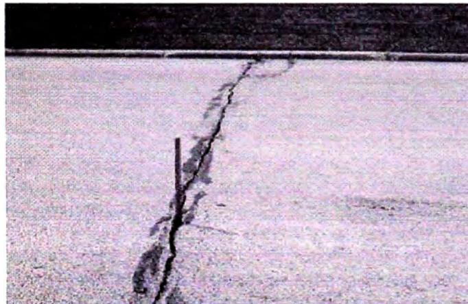
Fig. X1.29 Fisura Longitudinal y Transversal – Mediana Severidad
