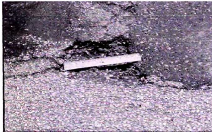
Fig. X1.35 Bache – Baja Severidad
