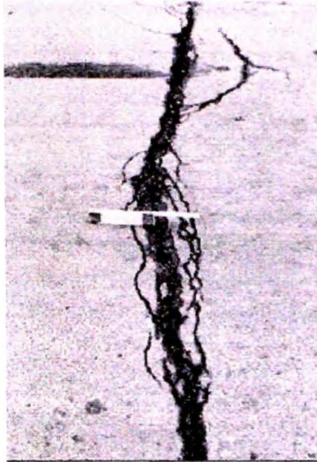
**Fig. X1.24 Fisura de Reflexión de Junta – Alta Severidad**
