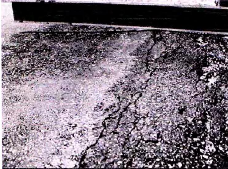
Fig. X1.12 Abultamientos y Hundimientos – Alta Severidad
