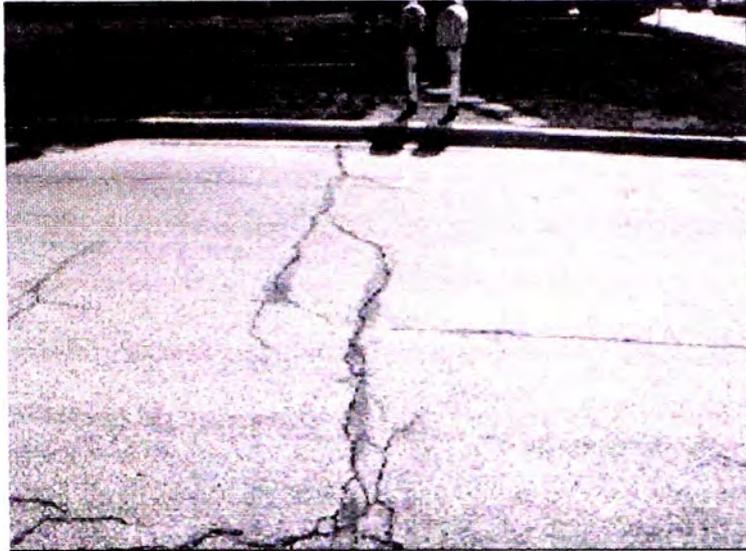
**Fig. X1.8 Fisuras en Bloque – Mediana Severidad**
