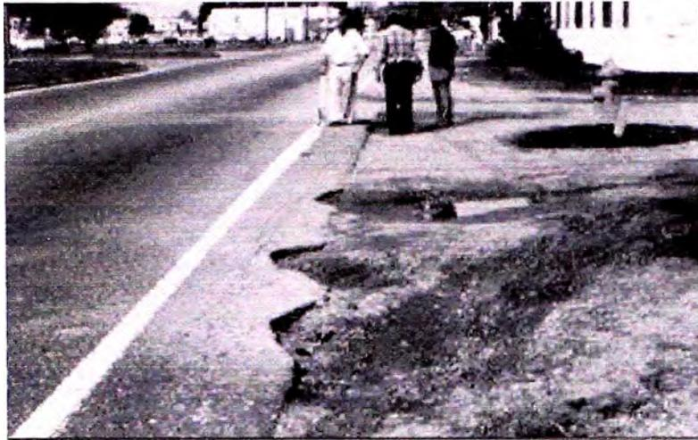
**Fig. X1.21 Fisura de Borde – Alta Severidad**
