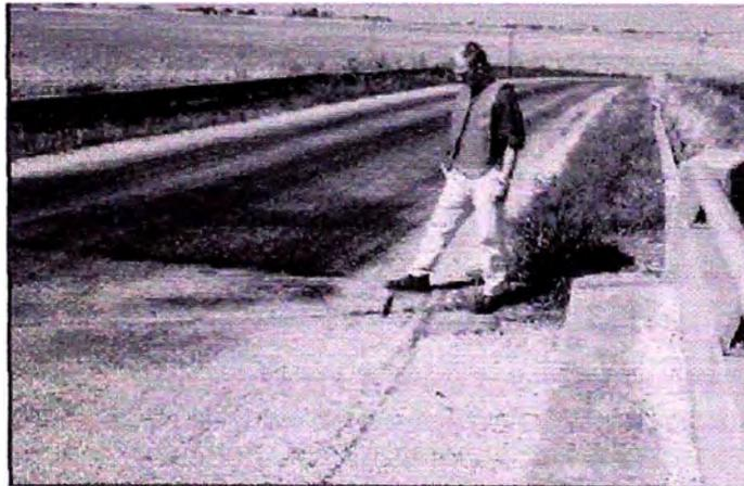
Fig. X1.44 Desplazamiento – Baja Severidad
