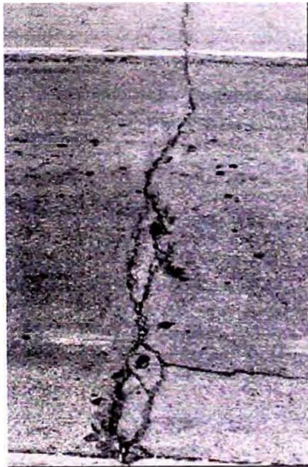
**Fig. X1.23 Fisura de Reflexión de Junta – Mediana Severidad**
