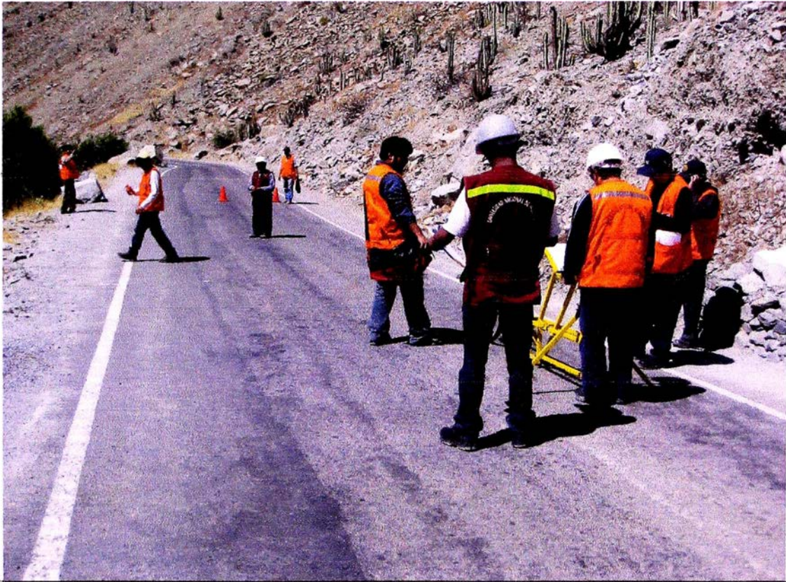
Foto N°05 TOMAS DE DATOS DEL GRUPO N° 07 EN EL TRAMO KM. 91+100 AL 91+500
