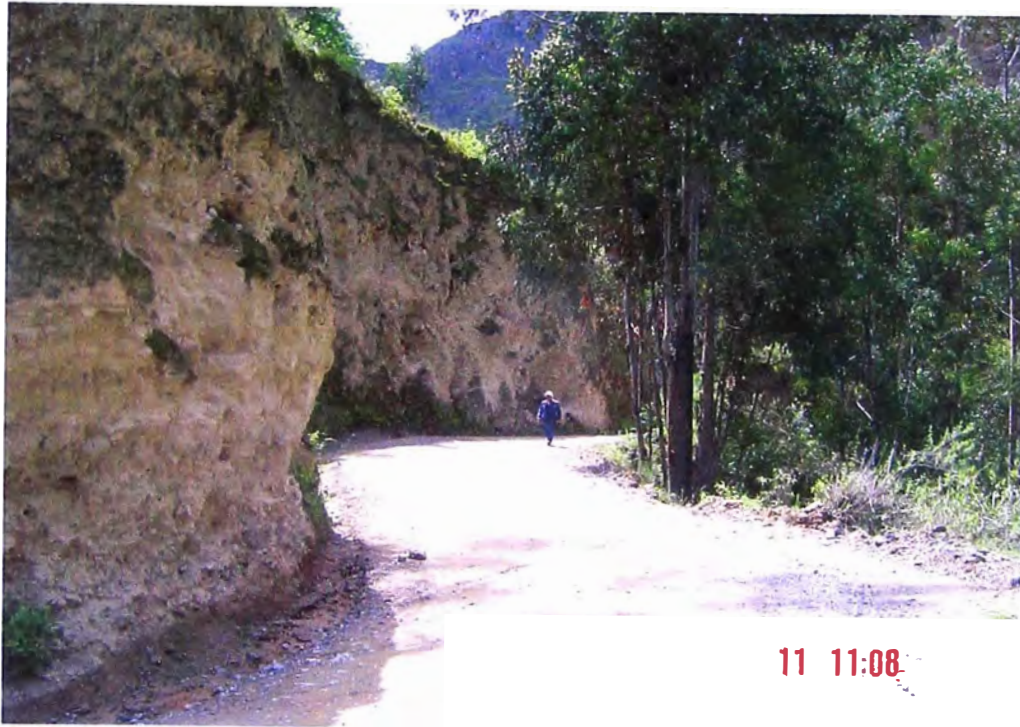
TALUDES VERTICALES ESTABLES
