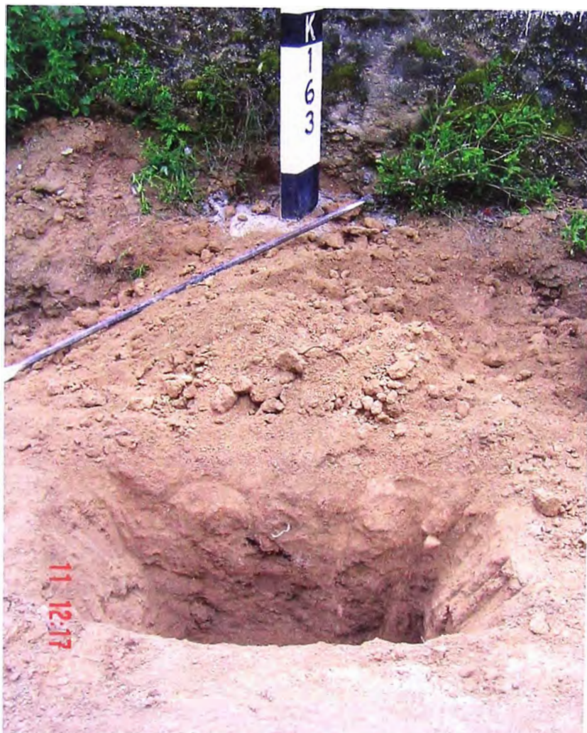
CALICATA EN LA PROG. Km. 163+000
