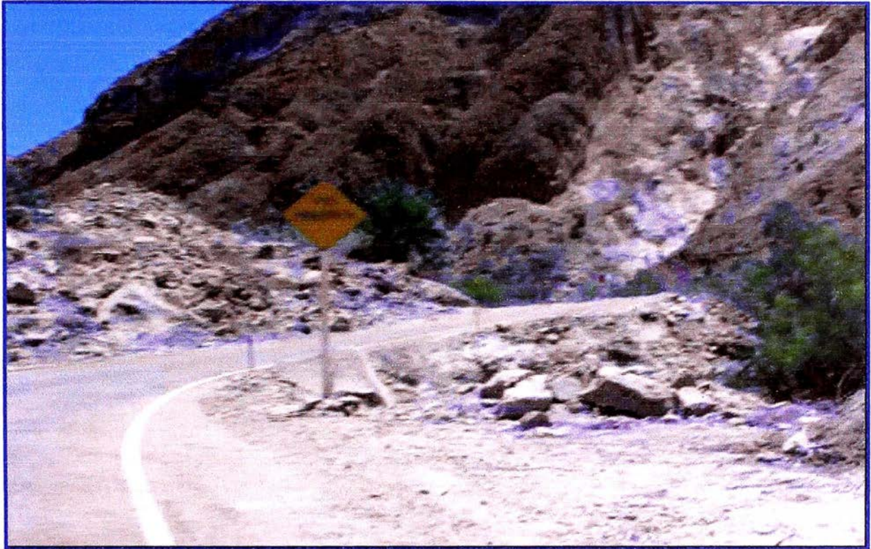
Figura N° 4.07. Fotografía de Señalización de Vía Angosta
