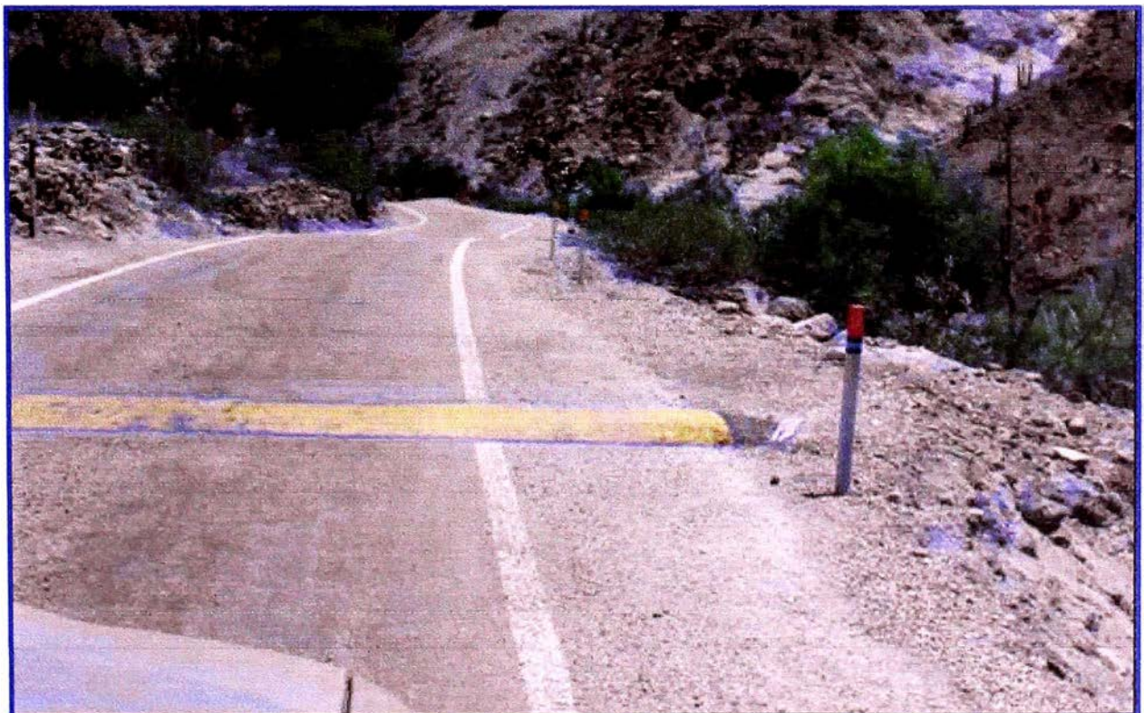
Figura N° 4.08. Fotografía de Ubicación de Giba Km.86+900
