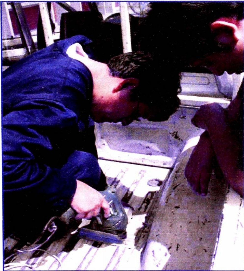
Figura N° 3.06. Fotografía de la Instalación del REBITU
