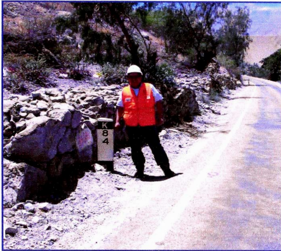
Figura N° 4.01. Fotografía de Ubicación de Progresiva Km.84+000
