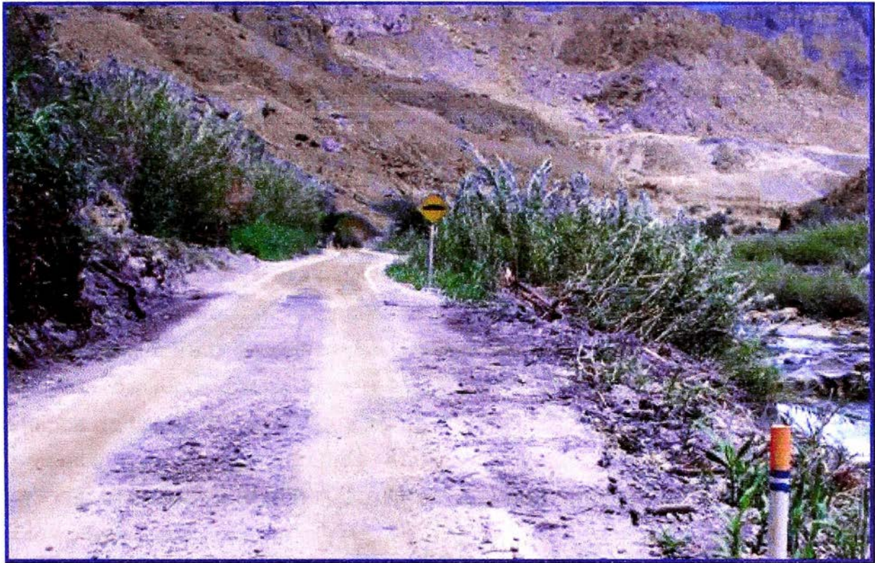
Figura N° 1.05. Fotografía del Desgaste del Recubrimiento Monocapa
