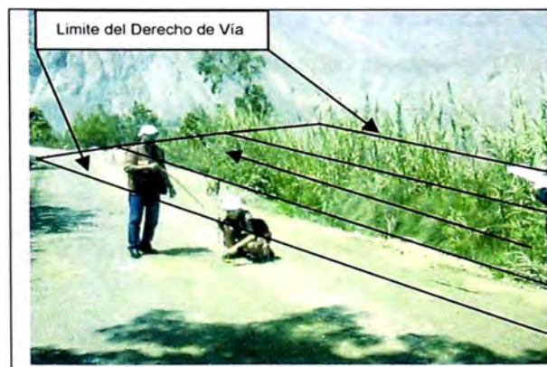
Predio ubicado al lado derecho de la vía, afectación de vegetación arbustiva (código 9).
