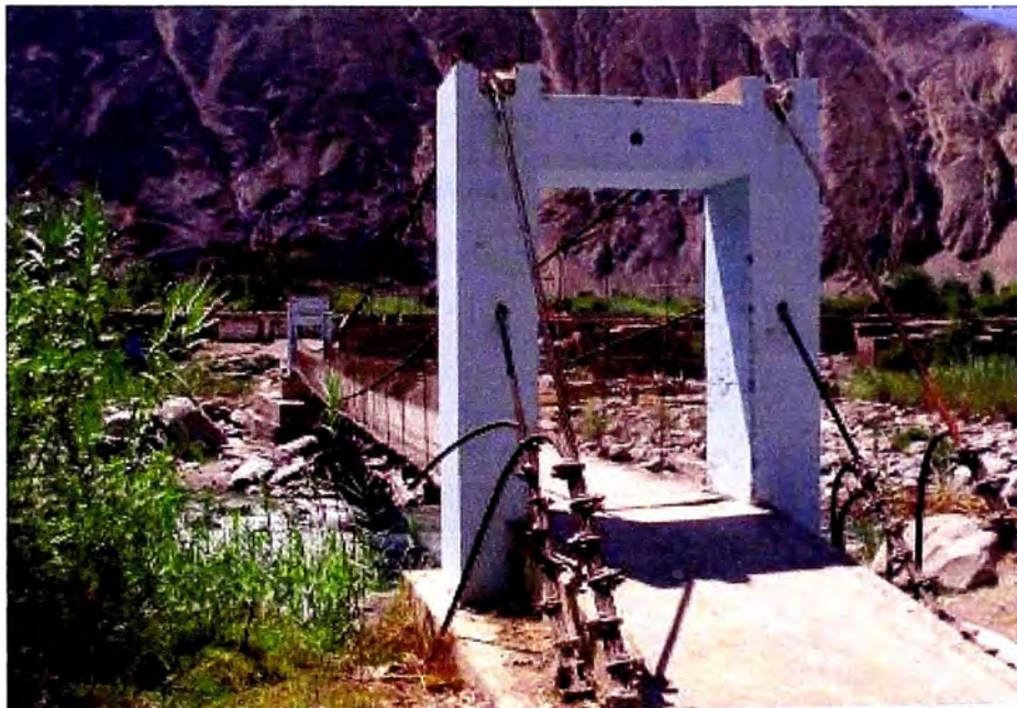
Foto 04: Puente peatonal sobre el rio Cañete, da acceso Centro poblado de Catapalla
