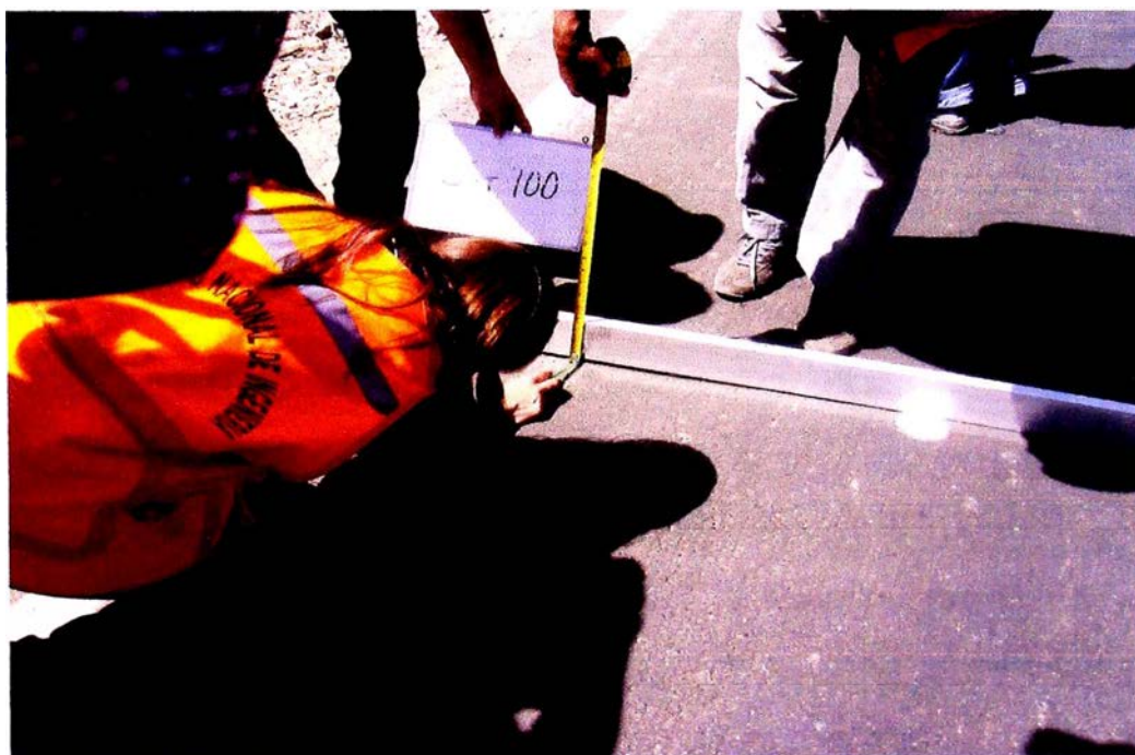
FIGURA N° 4.3 MEDICIÓN DEL AHUELLAMIENTO.
