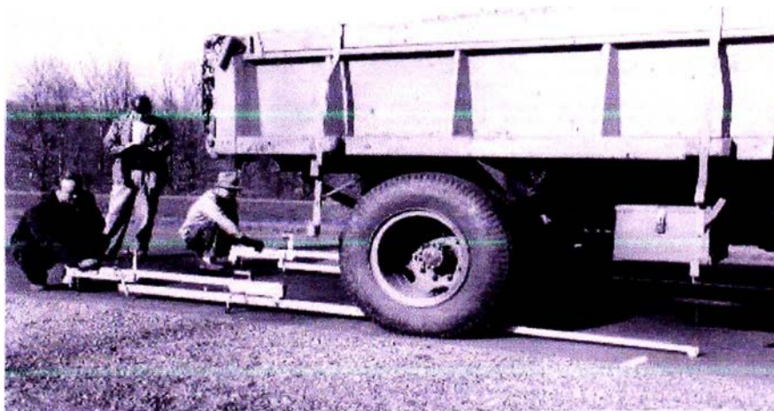
FIGURA Nº 2.1 PRUEBAS CON VIGA BENKELMAN (1952)
