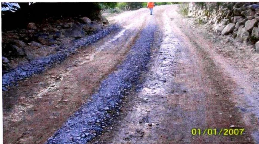
**Figura N° 1. 7: Ahuellamiento en tramo no pavimentado**
