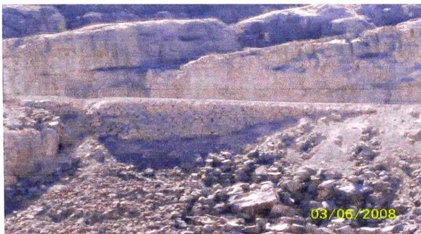
**Figura N° 1. 9: Muro de mampostería de piedra seco**
