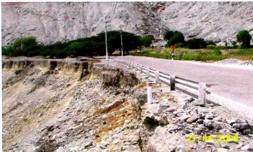
**Figura N° 1. 6: Erosión en tramo asfaltado**
