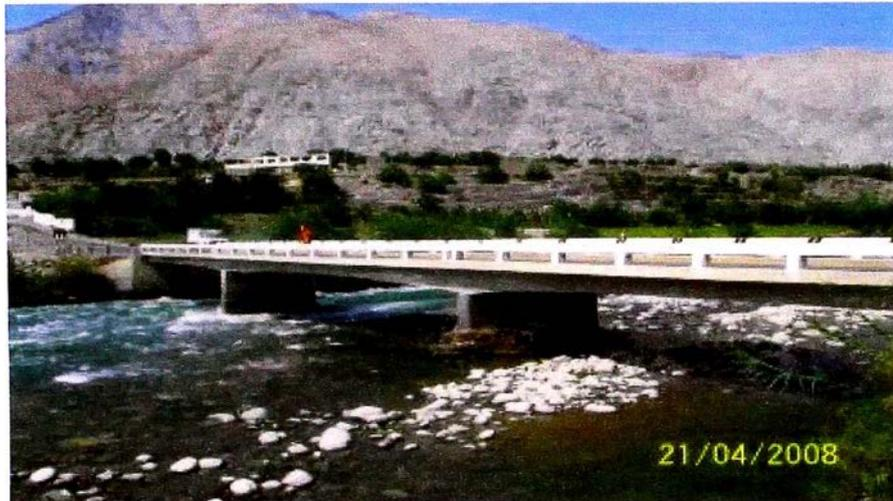
**Figura N° 1. 8: Puente viga-losa en buen estado estructural**
