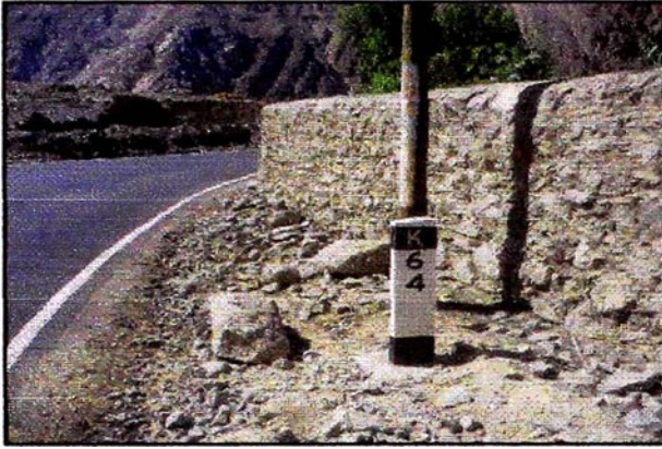
FOTOGRAFÍA N° 1.2 Progresiva Km. 64+000, inicio de tramo de estudio (Fuente: Elaboración propia)
