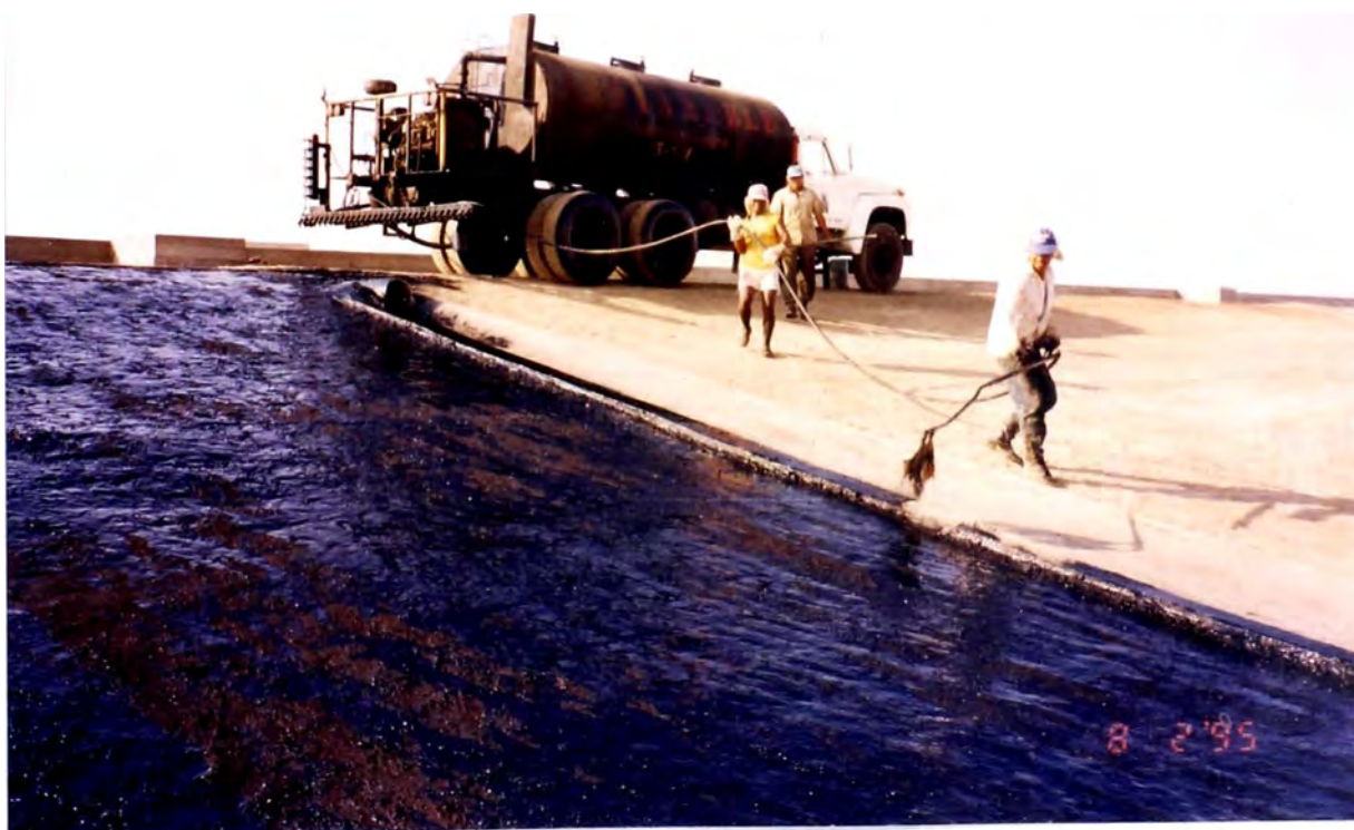
Foto No. 10: Primera capa de asfalto líquido, impermeabilización de taludes lagunas
