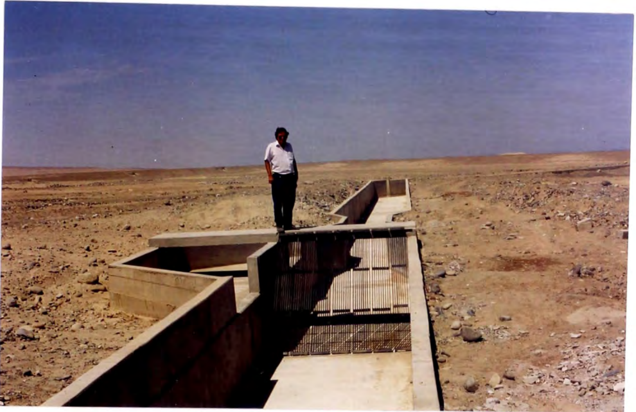
Foto No. 11: Canal principal, cámara de rejillas y canal bypass concluidos.
