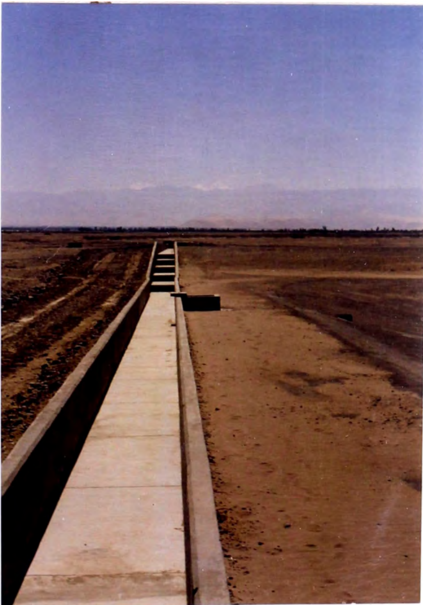
Foto No. 11: Canal principal, cámara de rejillas y canal bypass concluidos.
