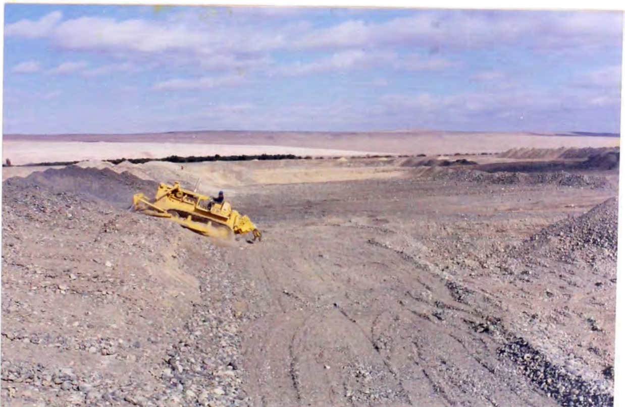
Foto No. 02: Tractor D8-H en corte de taludes Laguna Primaria No. 01
