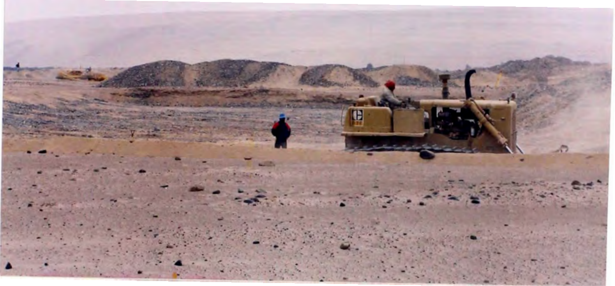
Foto No. 01: Tractor D7-F en excavación masiva de Lagunas de Estabilización
