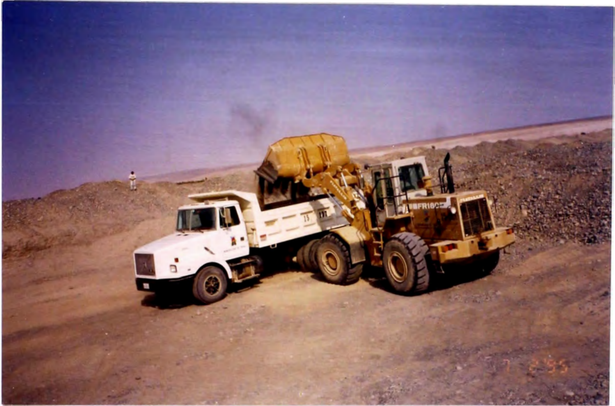
Foto No. 05: Eliminación de material excedente con cargador frontal de 4.0 yd 3 y volquetes de 10 m 3 .
