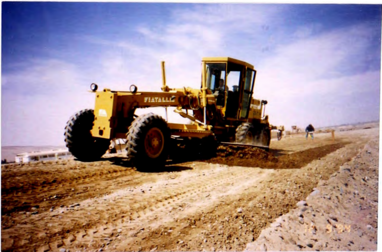
Foto No. 06: Peinado de taludes con motoniveladora de 162 H.P. y, al fondo, verificación de pendiente con escuadra de madera
