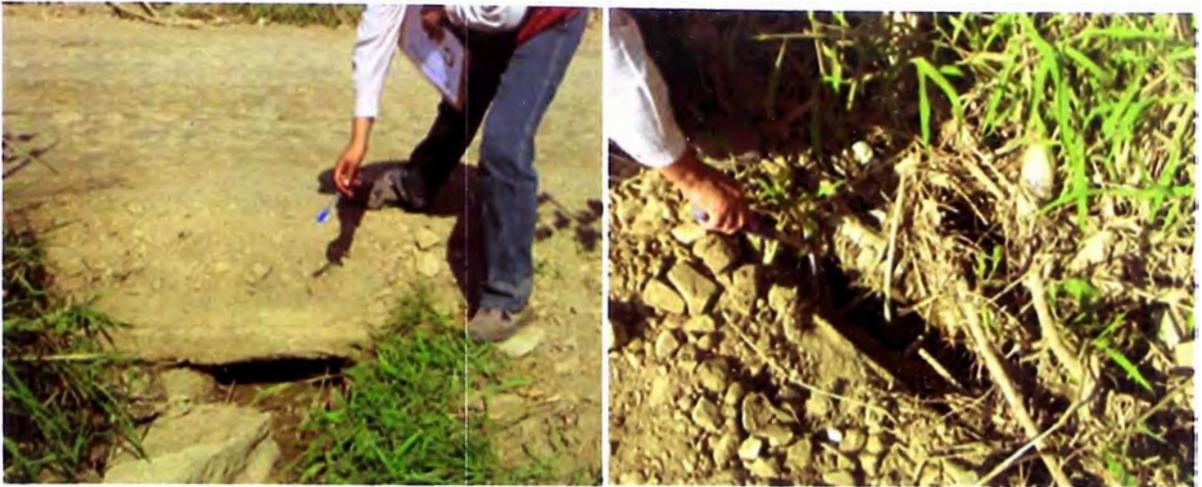
**Fotos 3 y 4:** Entrada y salida de una alcantarilla colmatada. Esta alcantarilla servía como desagüe de una cuneta de riego.
