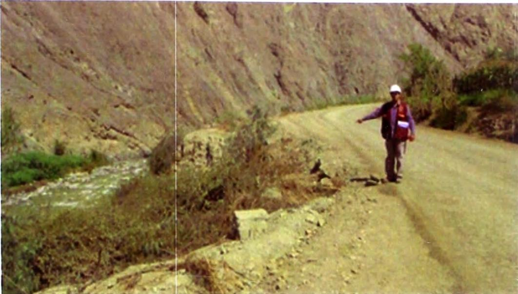
**Foto 1:** Zona crítica de erosión de taludes. Se presentaron dos zonas en el lado de la vía cercano al río Cañete.
