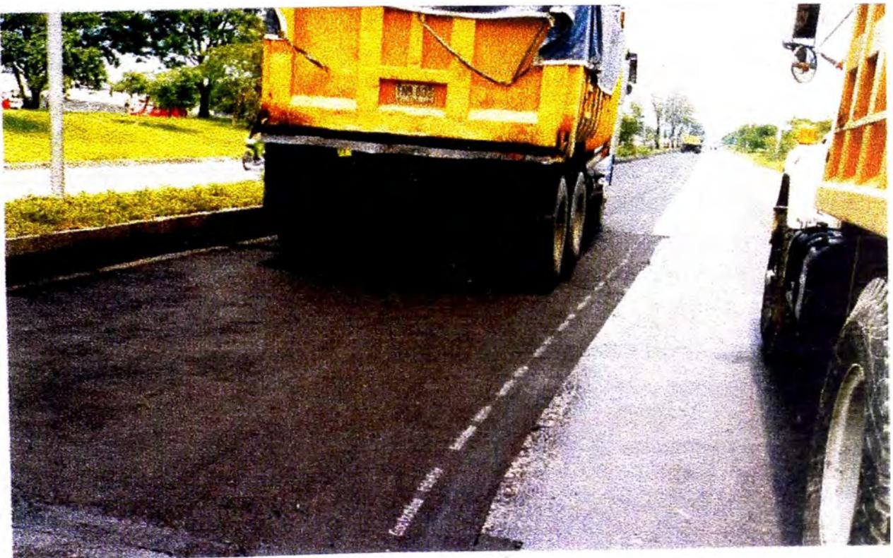
*Fotografía 3.7 Tren de volquetes con mezcla asfáltica pasando sobre el geotextil, y colocación de la mezcla asfáltica*
