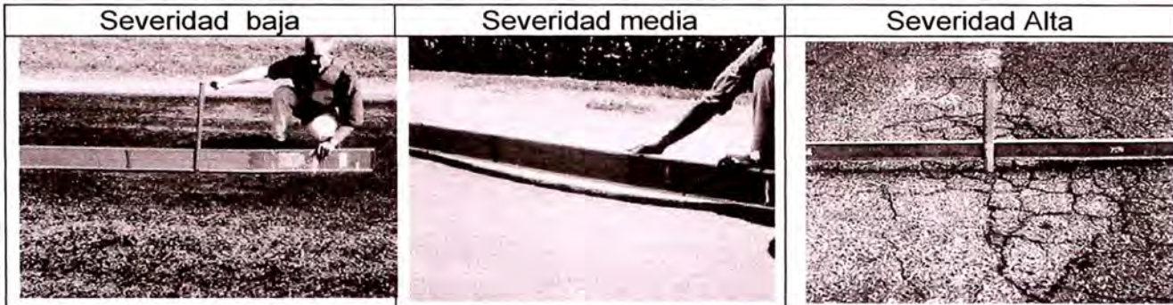
Foto N°3.06 DEPRESIONES (Fuente: Manual INGEPAV)
