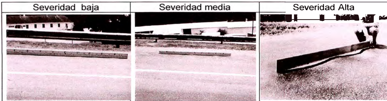
Foto N°3.05 CORRUGACIONES (Fuente: Manual INGEPAV)
