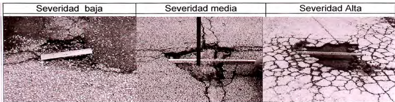
Foto N°3.13 HUECOS (Fuente: Manual INGEPAV)
