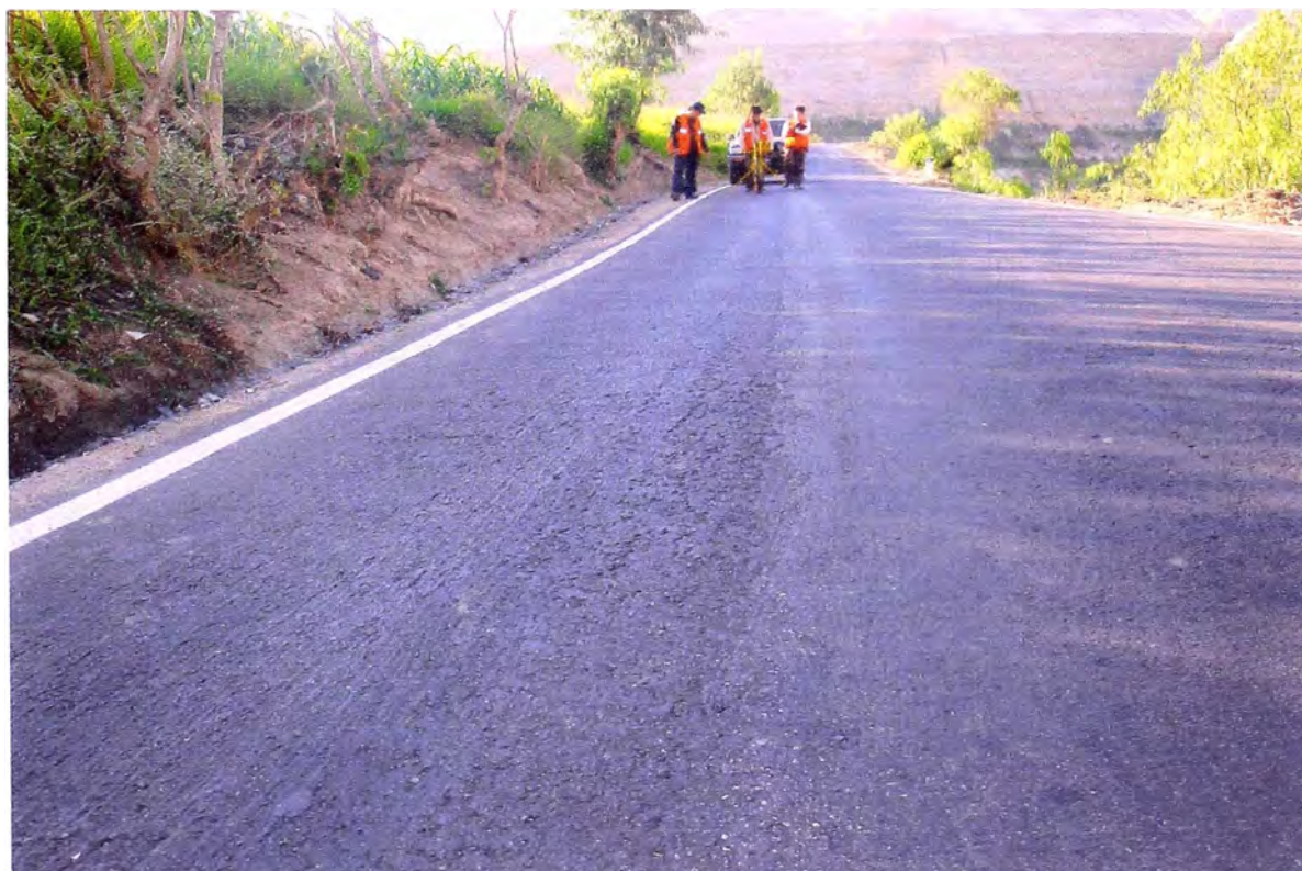
Foto N° 10: Superficie de rodadura en buen estado
