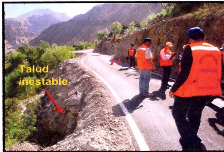
Fotografía N° 1.2: Inestabilidad de talud inferior
