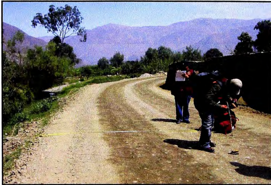
Se observa el trazo existente de la carretera – curvas.
