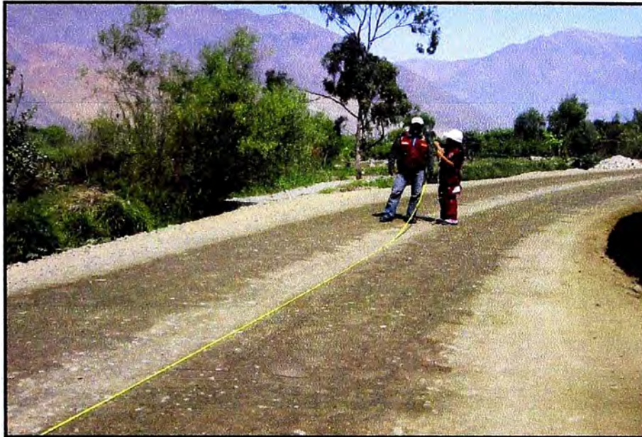
La situación actual de la Carretera, se encuentra a nivel de afirmado
