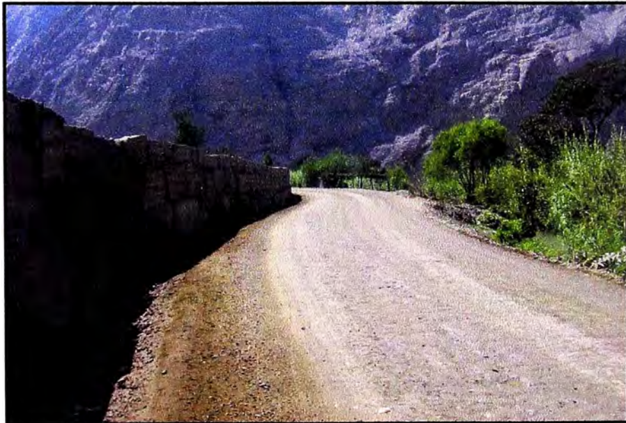
Curva existentes en la Carretera
