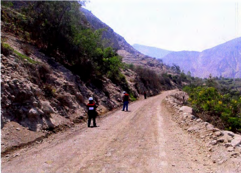
Equipo de Topografía realizando el estacado y winchado
