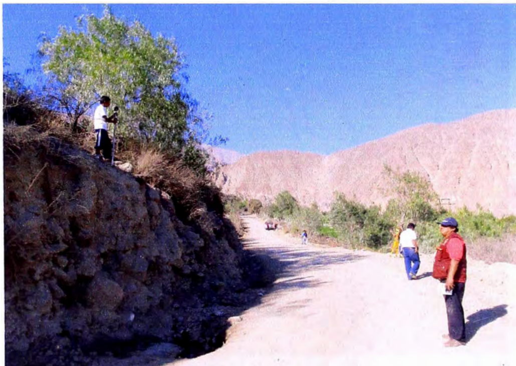
Levantamiento Topográfico del talud superior con estación total
