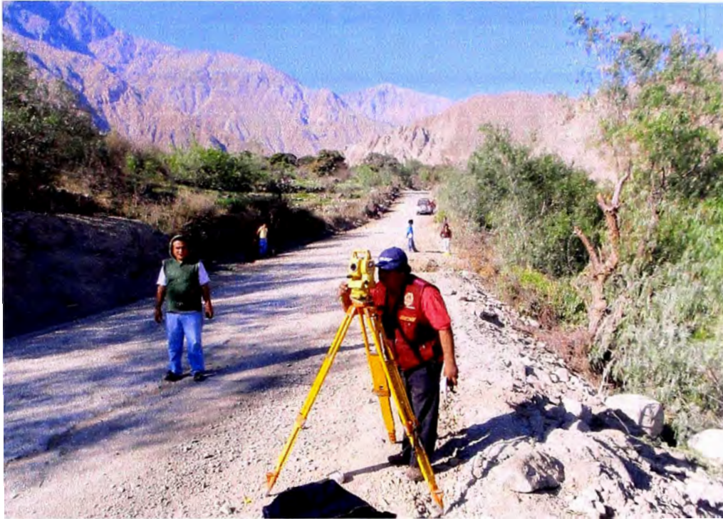
Vista de los trabajos de topografía, al fondo fin del tramo Km. 59+400
