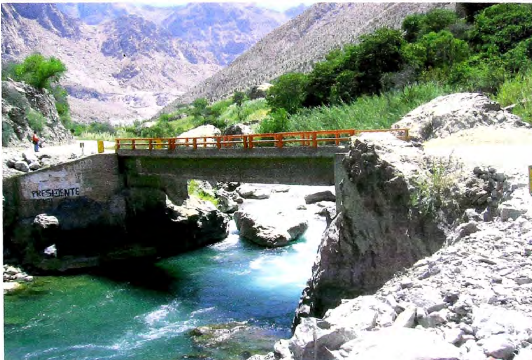
Figura 3.2 Puente Matica – Km. 85+377
