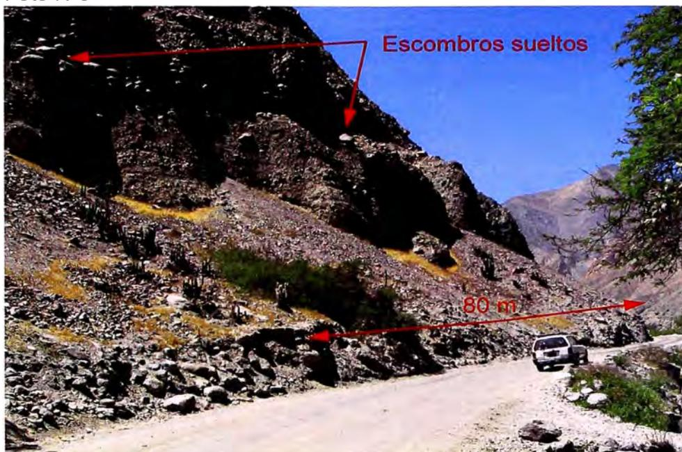
**82+850** Estrato de depósito de suelo aluvial, se aprecian fragmentos de roca y bolonerías de apreciable tamaño en los estratos del suelo, con posibilidad de caída a la plataforma mediante rodamiento. En éste caso se recomienda la colocación de una Malla de Contención a lo largo de la vía en todo el tramo comprendido, que es de aproximadamente 80 metros.
