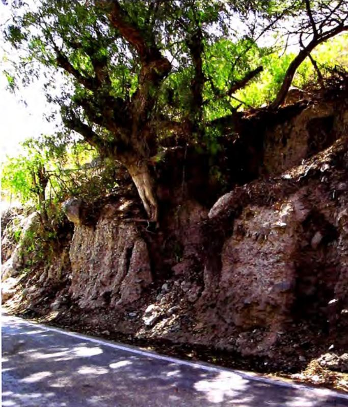
**80+340**      Árbol con raíces descubiertas en el talud, se aprecia la erosión del suelo que servía como sostenimiento y agarre de las raíces del árbol y por ello la posibilidad de caída del mismo hacia la plataforma. Se recomienda la remoción del árbol y su posterior resembrado.
