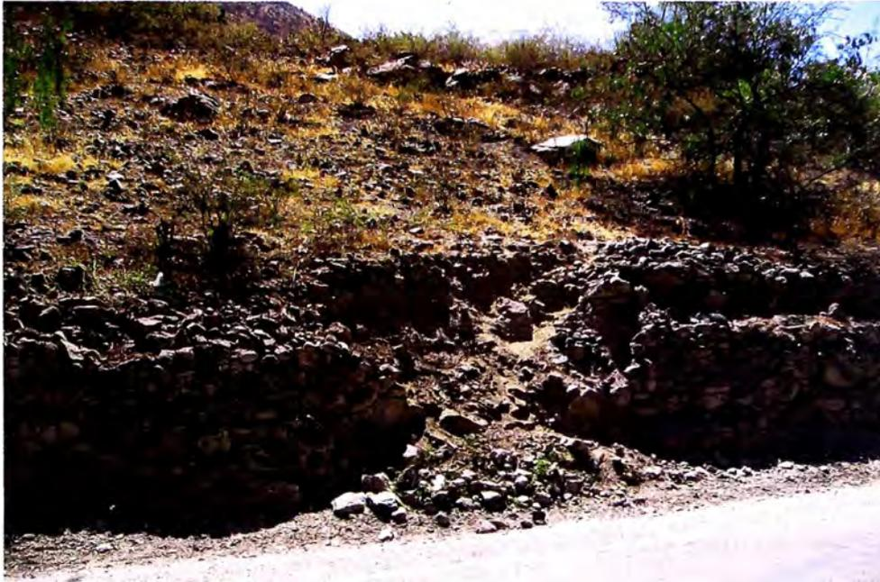
**83+980** Área de depósito de suelo aluvial, se aprecian deslizamiento de material que incluyen fragmentos de roca y bolonerías con posibilidad de caída a la plataforma. En éste caso se recomienda la remoción de fragmentos de rocas sueltos y la construcción de un Muro de contención artesanal.
