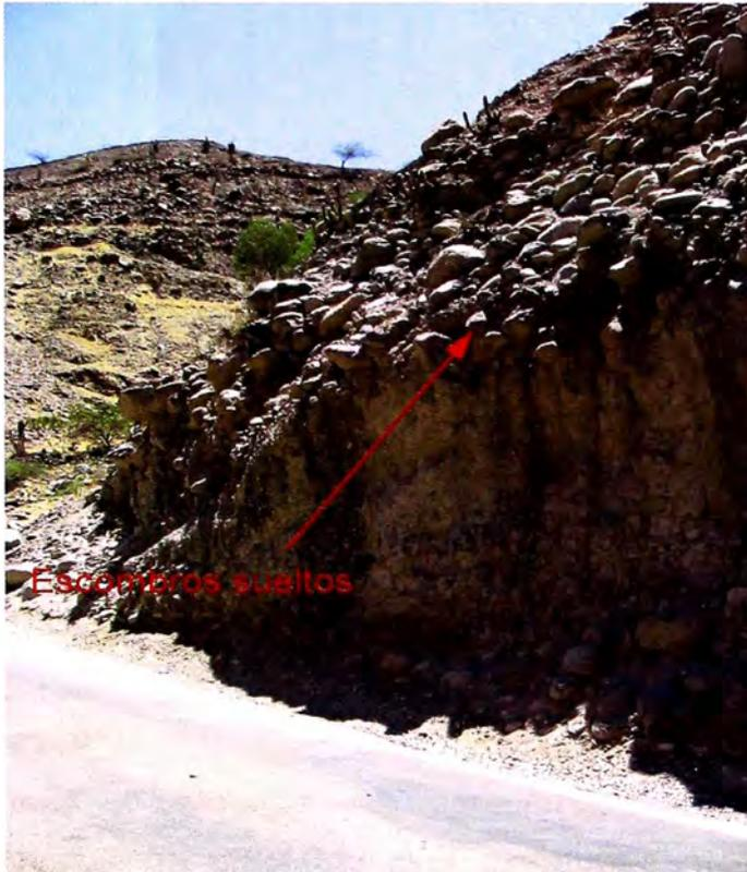
**81+770** Depósito de suelo aluvial, se aprecian fragmentos de roca y bolonerías de mediano tamaño con posibilidad de caída a la plataforma. En éste caso se recomienda la remoción de los fragmentos de roca y bolonería y hacer el posterior mantenimiento del talud mediante Shotcrete.
