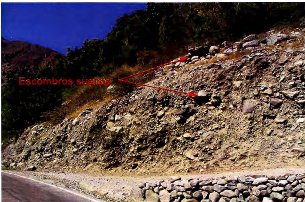
**79+050** Corte en depósito de suelo aluvial, se aprecian fragmentos de roca y bolonerías de apreciable tamaño con posibilidad de caída a la plataforma. En éste caso se recomienda la remoción de fragmentos de rocas sueltos y el mantenimiento del talud mediante Shotcrete.
