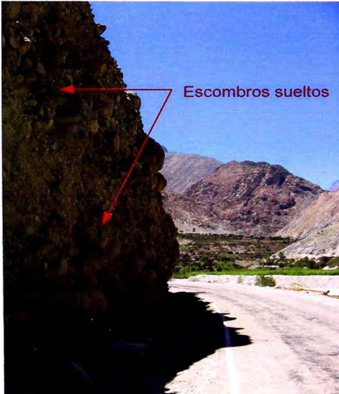
**81+160** Depósito de suelo aluvial, se aprecian fragmentos de roca y bolonerías de apreciable tamaño con posibilidad de caída a la plataforma. En éste caso se recomienda el mantenimiento del talud mediante Shotcrete.
