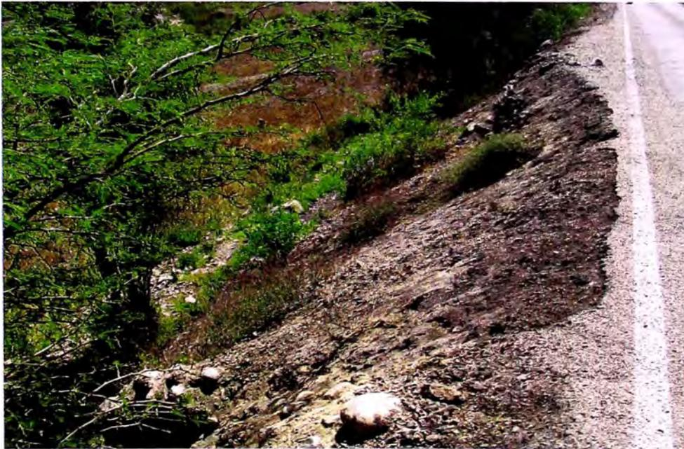
**80+050** Plataforma de vía erosionada, se aprecia el desmoronamiento del talud debido a erosión, con posibilidad de caída a la plataforma mediante rodamiento. En éste caso se recomienda estabilizar el talud con un muro de sostenimiento elaborado artesanalmente y en lo posible con mampostería de piedra de 8 metros de largo aproximadamente.
