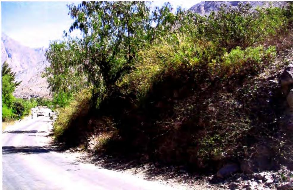
**83+940**      Árbol con raíces descubiertas en el talud, se aprecia la erosión del suelo que servía como sostenimiento y agarre de las raíces del árbol y por ello la posibilidad de caída del mismo hacia la plataforma. Se recomienda la remoción del árbol y su posterior resembrado.
