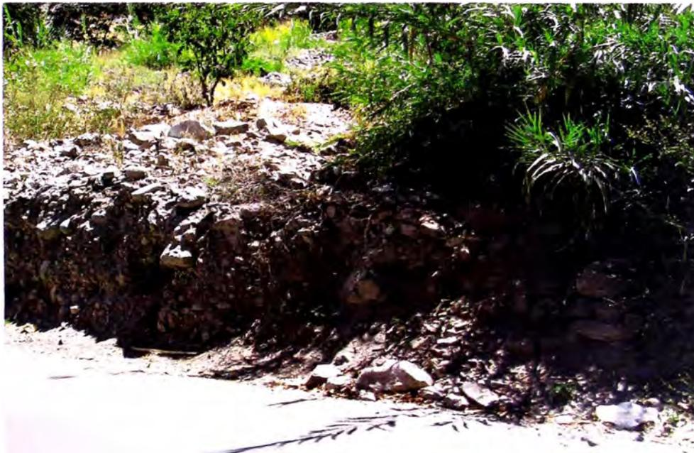
**83+370** Área de depósito de suelo aluvial, se aprecian deslizamiento de material que incluyen bolonerías con posibilidad de caída a la plataforma. En éste caso se recomienda la remoción de fragmentos de rocas sueltos y un perfilado del talud.
