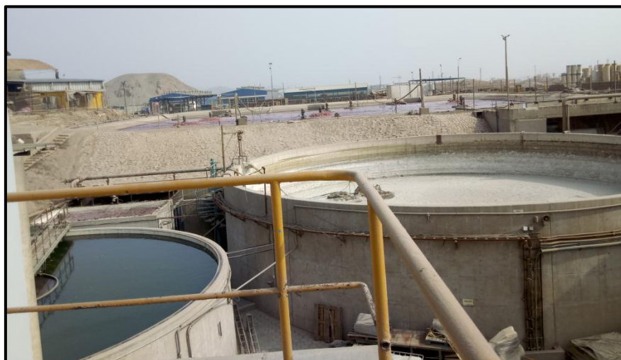
Figura 38. Tanque Ecuilizador, Planta GLORIA-Huachipa
