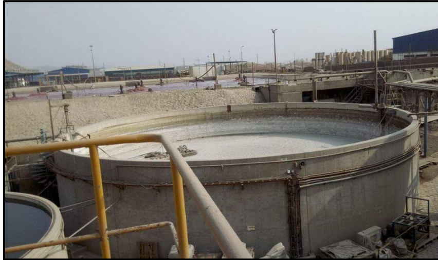
Figura 22. Toma de muestra del tanque ecualizador
