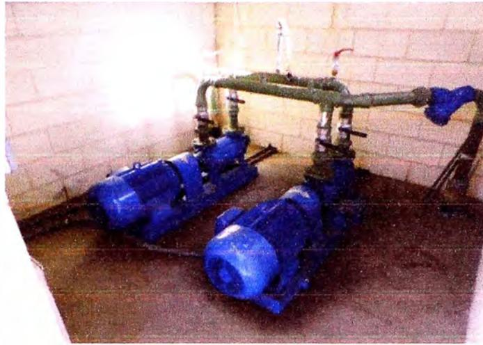
**Figura 3.-**Sistema de bombeo hidráulico con dos bombas centrífugas multietapa de 18,5 kW por unidad
