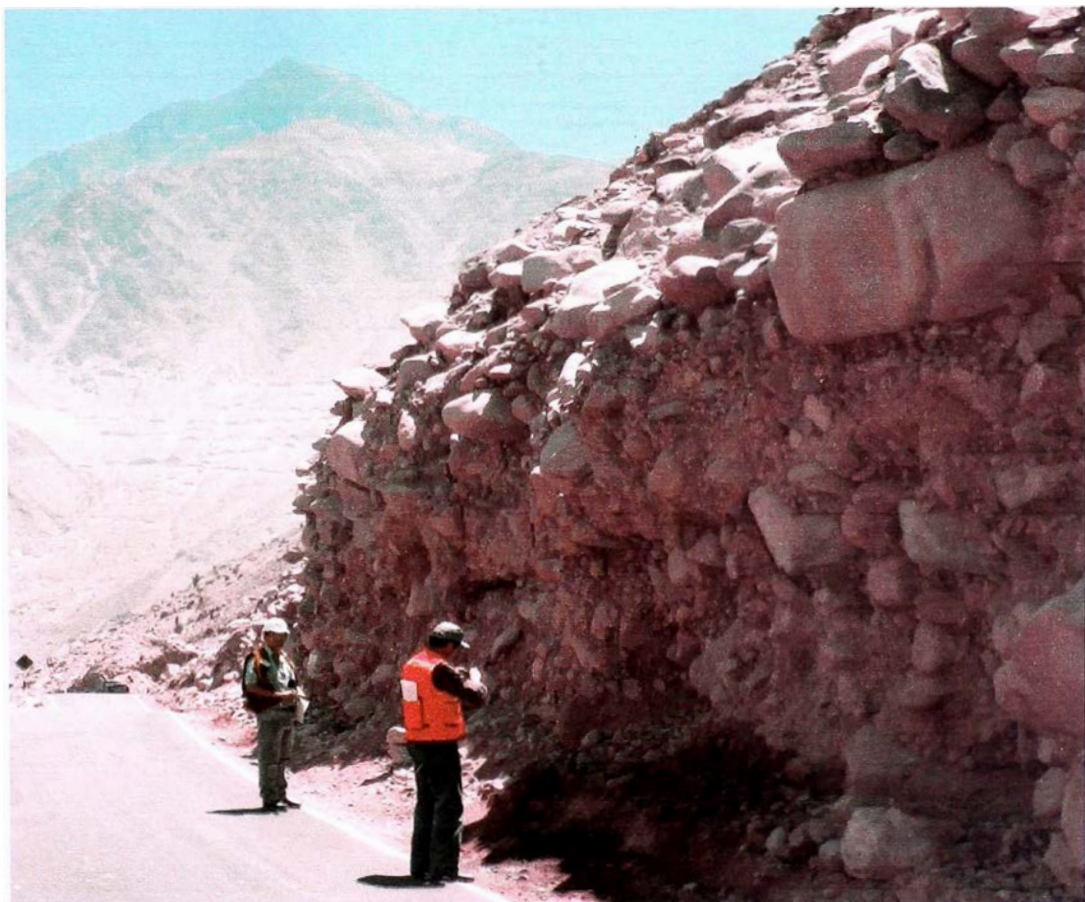
Foto 6: Sitio Crítico km 68+230
