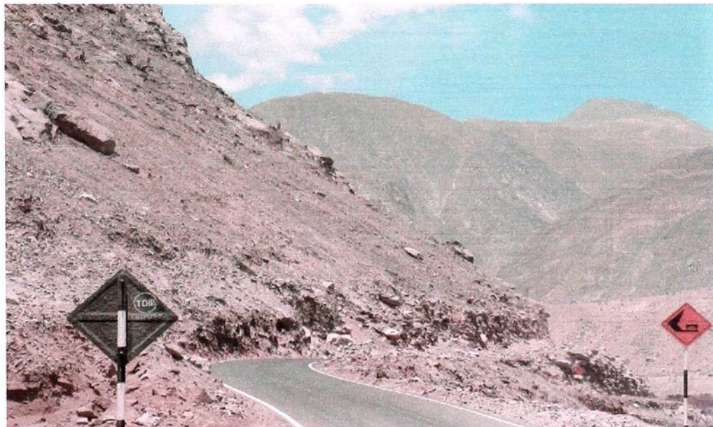
Figura N° 2.04: Estado del Talud
