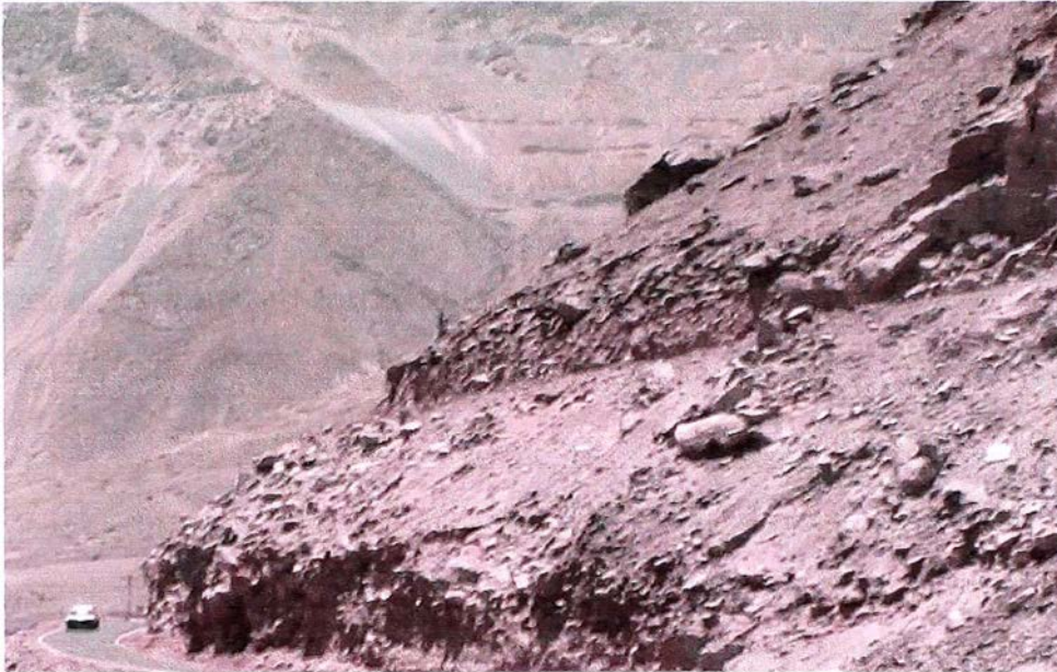
Figura N° 1.07: Sitio crítico km 68+200 al km 68+300
