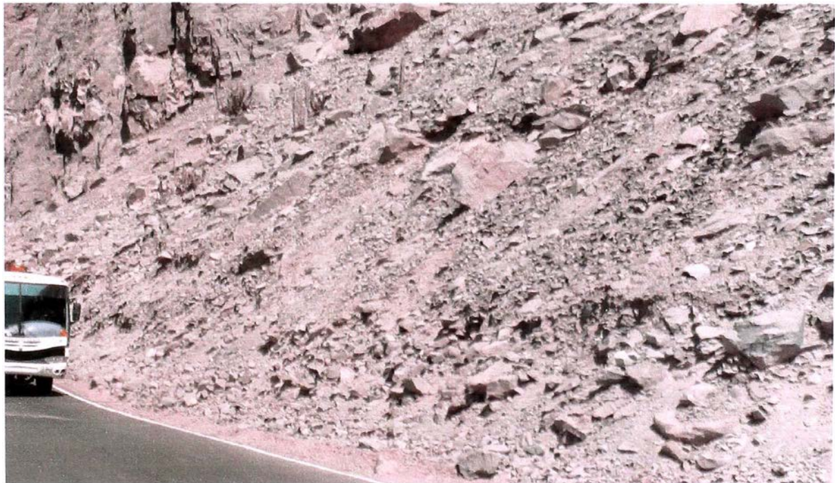
Foto 9: Depósito coluvial km 69+000
