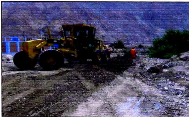
FIGURA N°3.4 ESTABILIZACIÓN DE AFIRMADO CON EMULSIÓN
