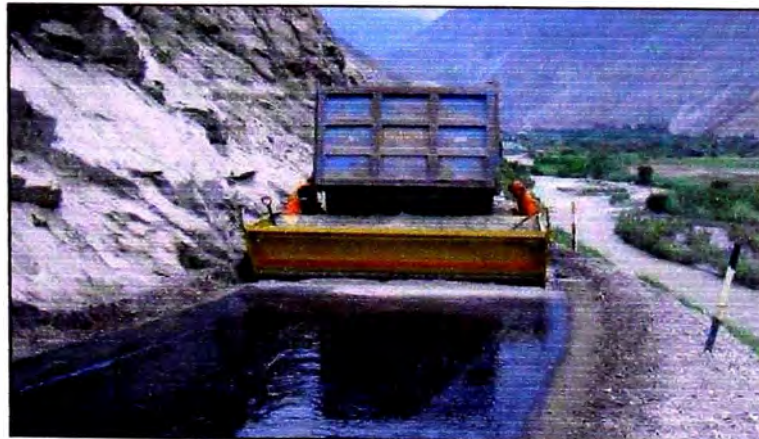
FIGURA N°3.5 COLOCACIÓN DE GRAVILLA PARA MONOCAPA
