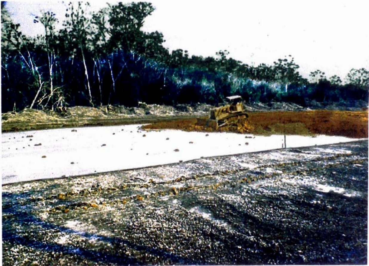
Colocación de la primera capa Granular sobre el Geotextil
