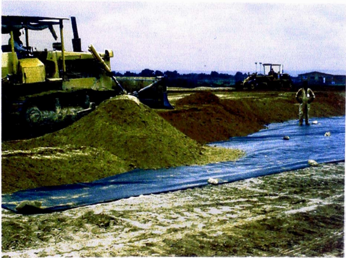
Tendido del material granular de la forma tradicional utilizando motorizadora y tractor
