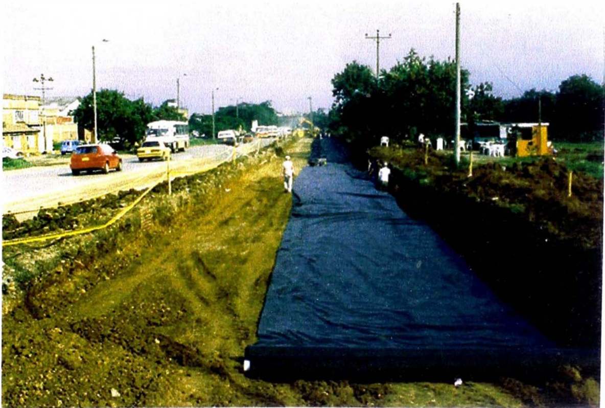
Tendido del Geotextil sobre la subrasante sin compactar cumpliendo la función de separación y refuerzo
