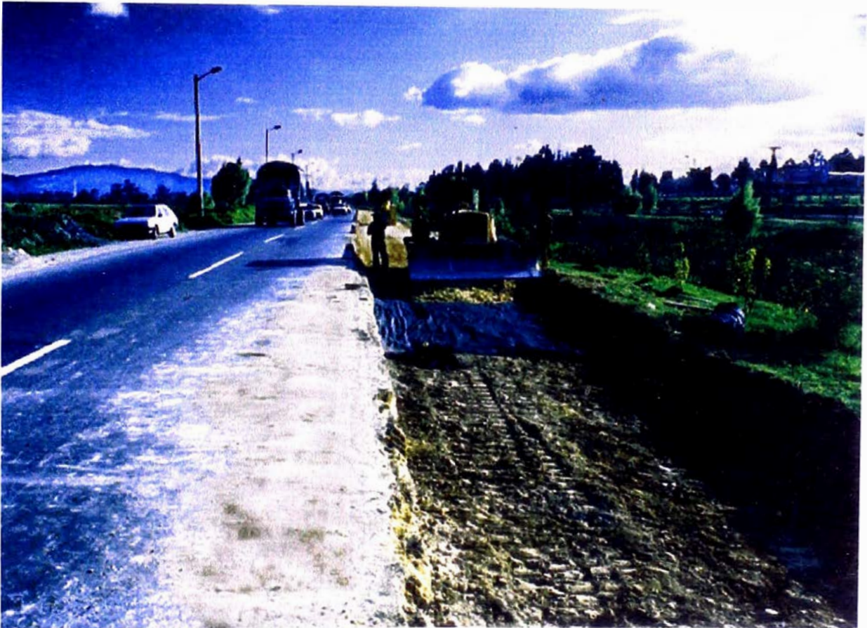
En esta vista se aprecia la colocación del Geotextil sobre la subrasante sin compactar
