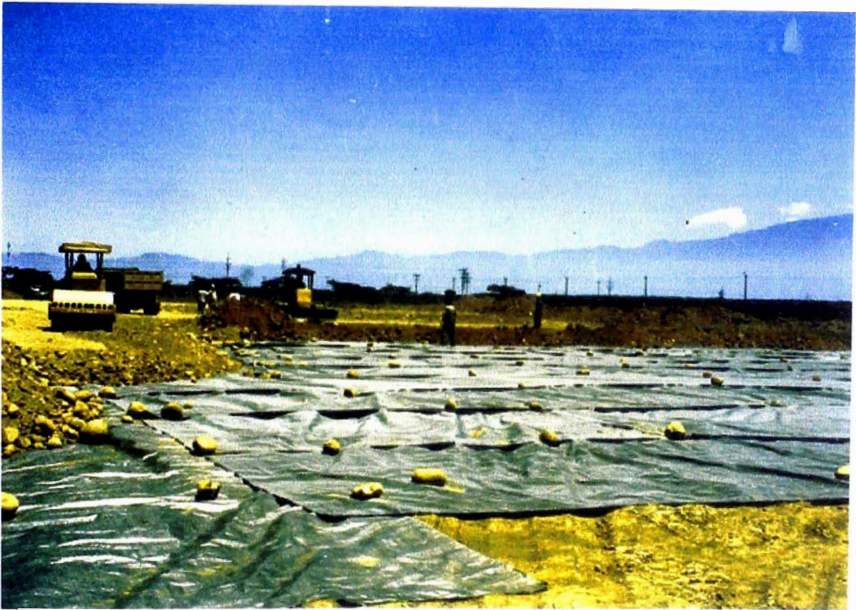
Colocación del Geotextil como refuerzo de la subrasante se puede apreciar los traslapes entre geotextiles
