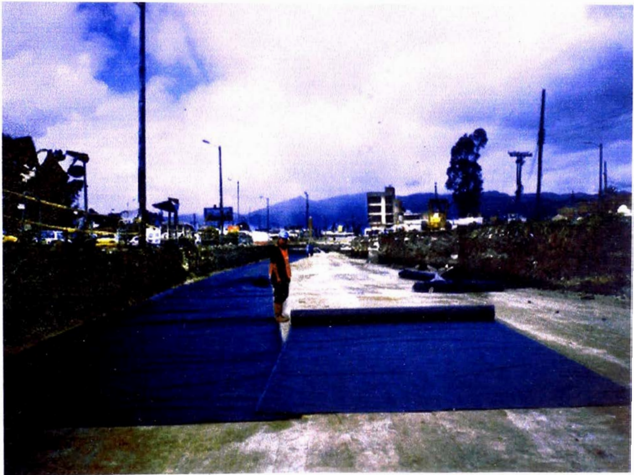
Presentación del Geotextil
