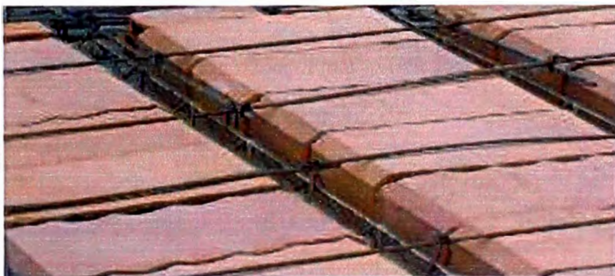
FOTO. N° 7.6 Colocación del Acero de Temperatura.
