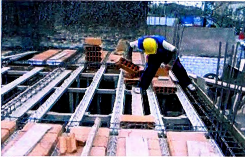
FOTO. N° 7.3 Colocación de bovedillas de arcilla.
