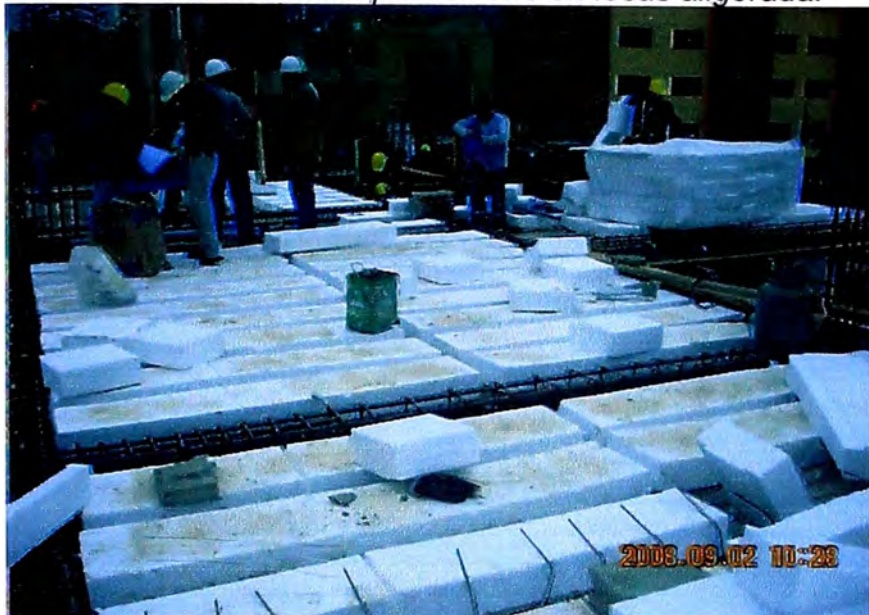
Bovedillas de poliestireno en losas aligerada.
