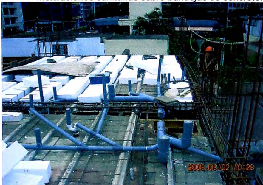
Instalaciones sanitarias sobre bandejas de concreto.
