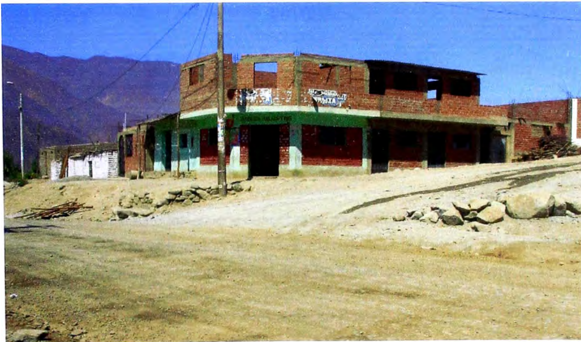
Figura 2.5 Vivienda de material noble de la zona de Zúñiga
