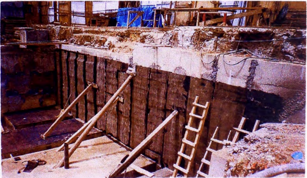
COLOCADO DE LA MANTA TORODIN PARA IMPERMEABILIZAR
