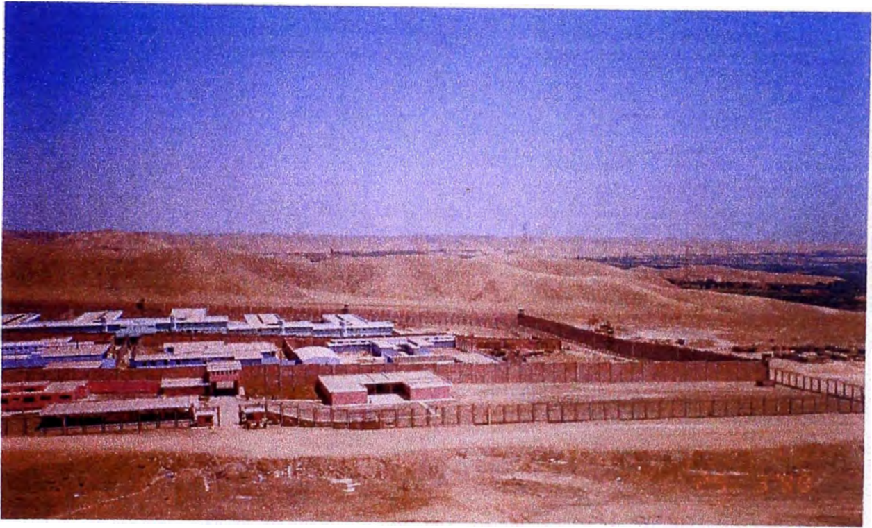
VISTA PANORAMICA DEL PENAL
