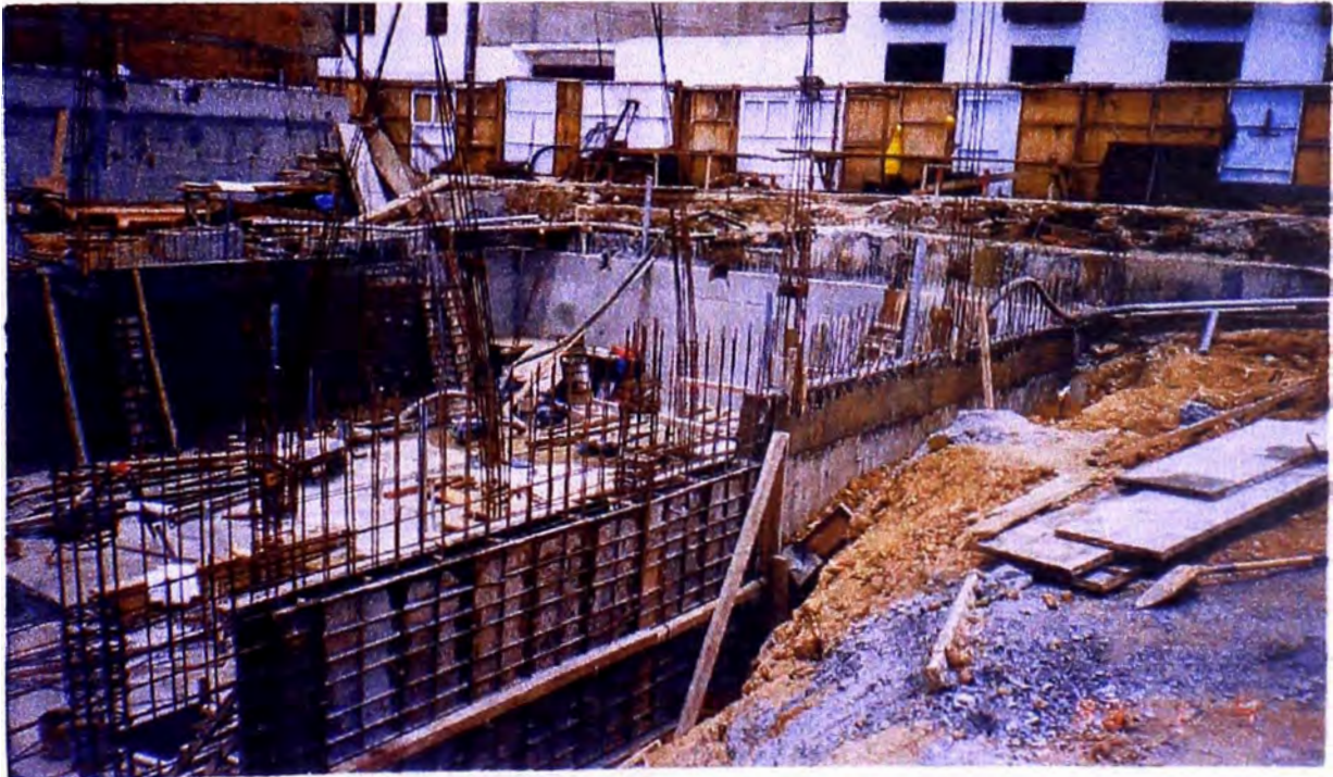
ENCOFRADO DE MURO DE CONCRETO REFORZADO
