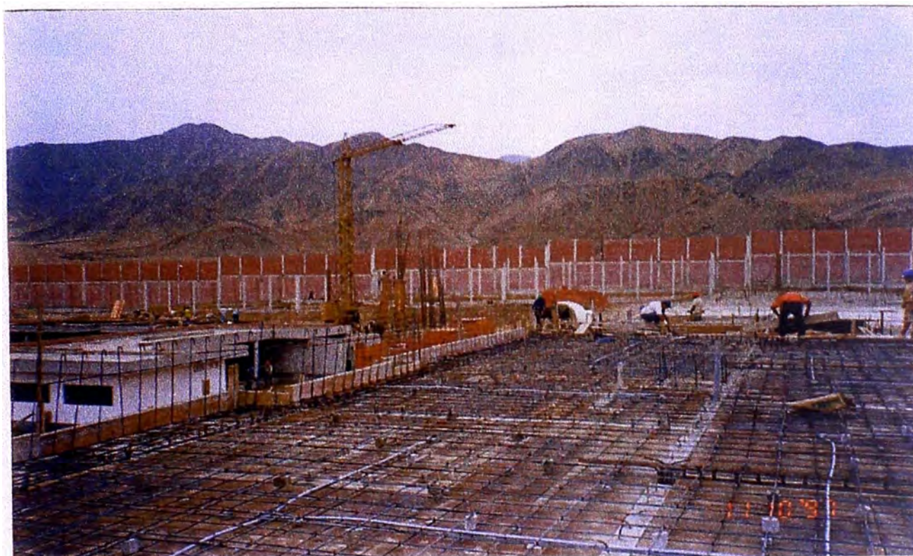
ENFIERRADO DE LOSA MACIZA EN PABELLO DE INTERNOS
