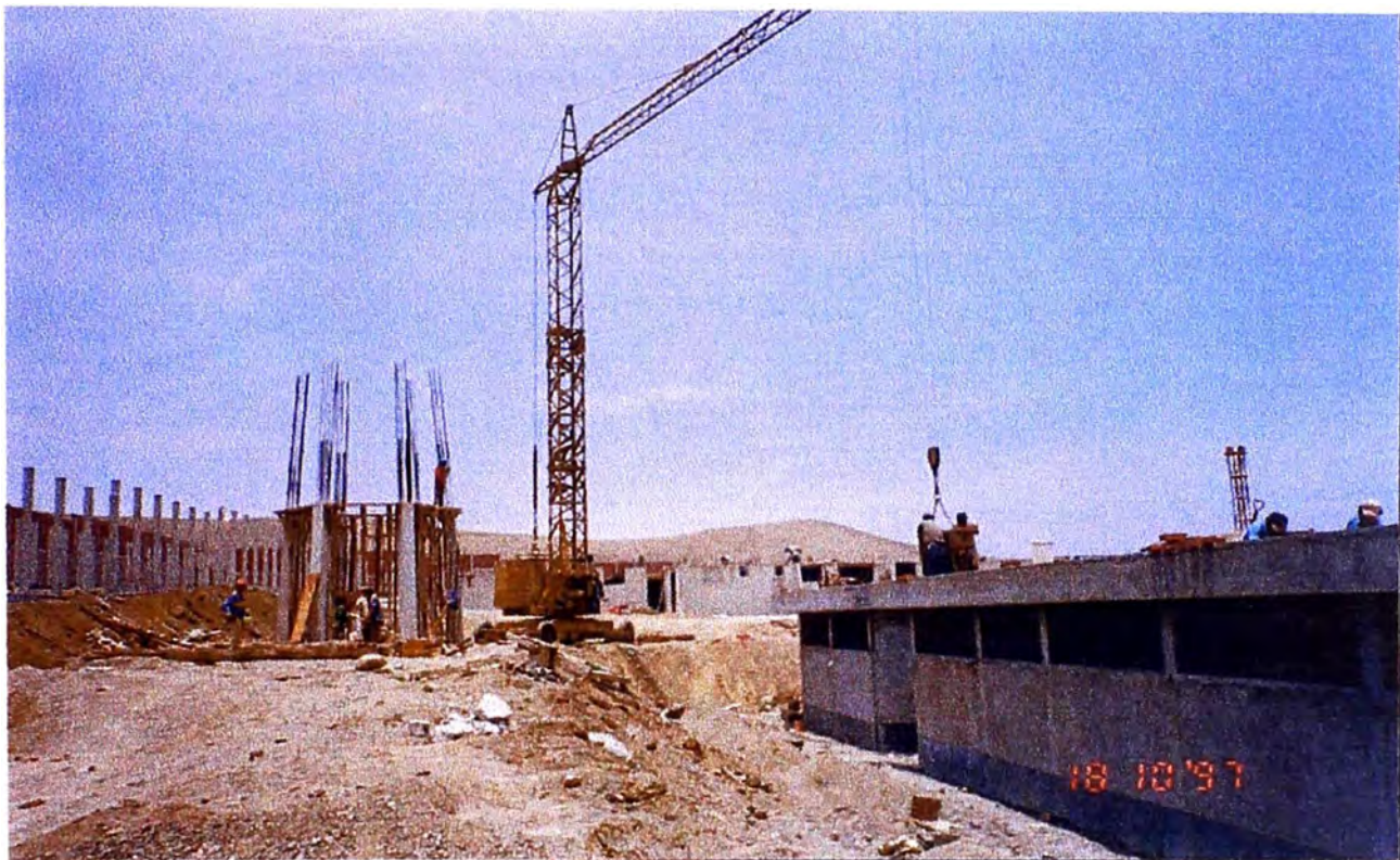
CONSTRUCCION DEL TANQUE ELEVADO
